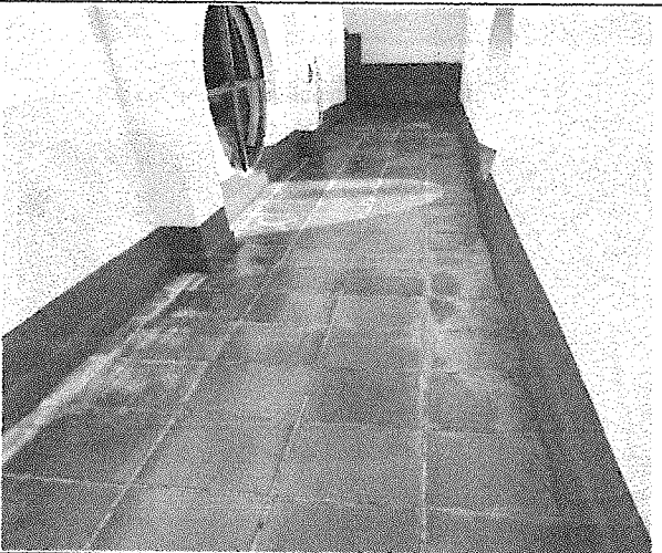
Foto No. 13 COMANDO DEMAM (Mantenimiento cubiertas)
