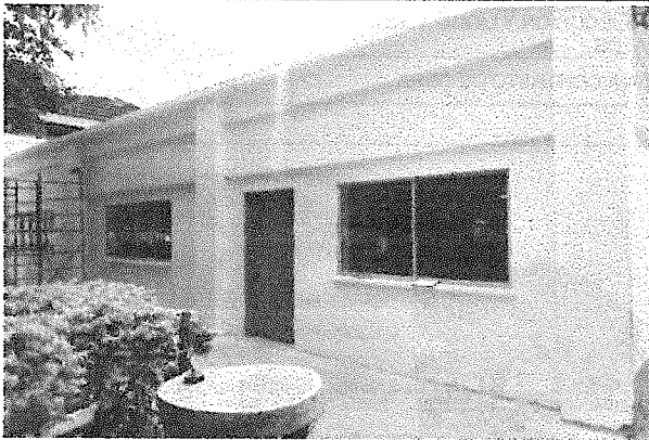
Foto No. 9 FUERTE SUR (Mantenimiento fachada movilidad)
