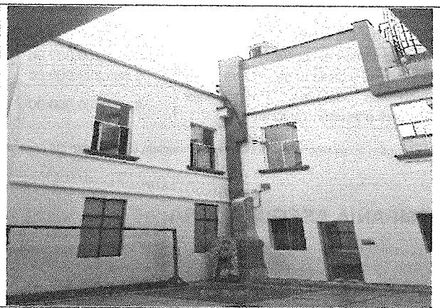
Foto No. 2 Comando MEBUC (pinturas fachadas)
