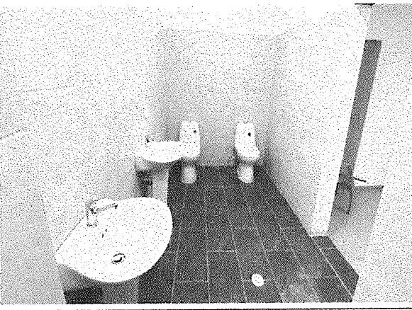
Foto No. 18 ESTACION SANTA ROSA (Mantenimiento de enchape de pisos)
