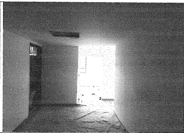
Foto No. 1 Comando MEBUC (alojamiento piso 2)
