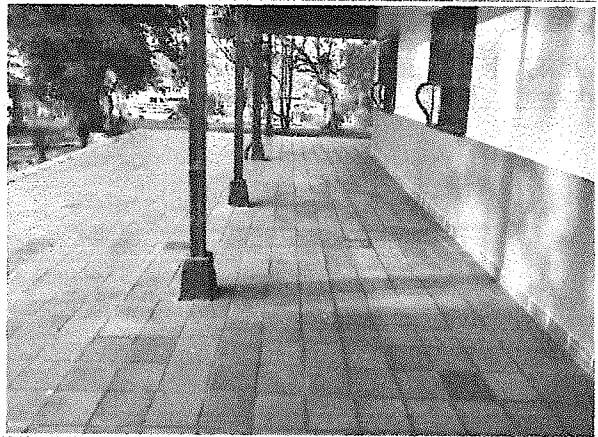
Foto No. 11 CASONA ASTURIAS (Cambio de pisos exteriores)
