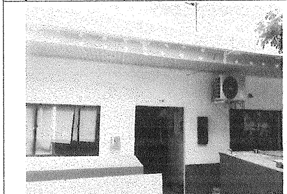
Foto No. 17 ESTACION PUERTO PARRA (Mantenimiento fachadas)
