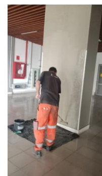
Arreglo Paredes Aguas Bogota
