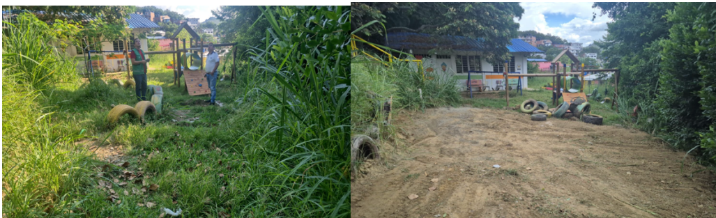
Adecuación de terreno en Montebello
