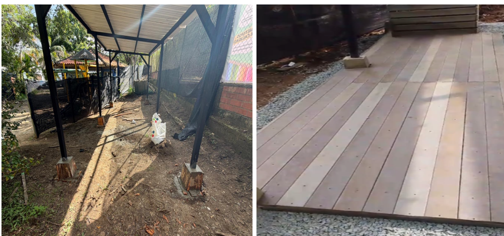
Instalación de cobertura y piso en Montebello
