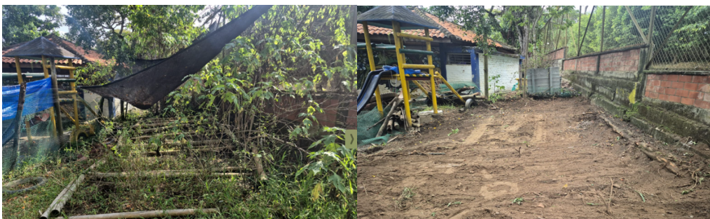
Instalación de cobertura y piso en Buitrera
