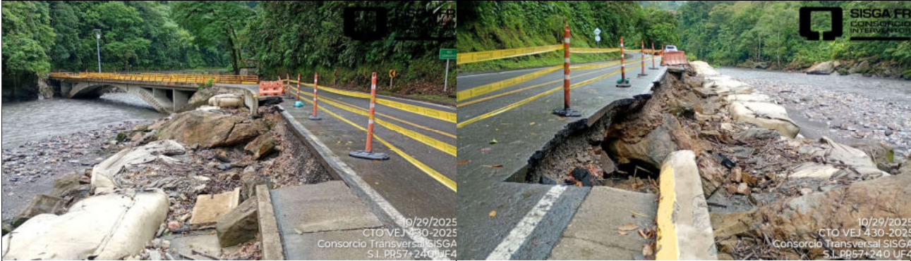
PR57+190. Instalación geocontenedores. Ruta 5608. Unidad Funcional 4.
