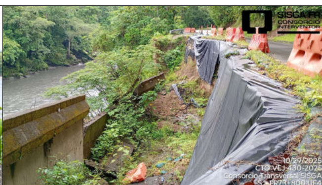
Sitio PR73+800 Ruta 5608. Unidad Funcional 4. Perdida de la banca, No relacionado en el Apéndice Técnico 1.
