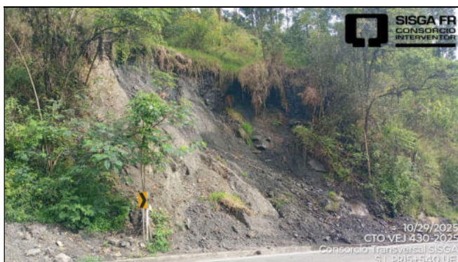
Sitio PR15+540 Ruta 5607. Unidad Funcional 1. Se observa un flujo de detritos y un movimiento en masa detonado por la saturación del suelo. No relacionado en el Apéndice Técnico 1.
