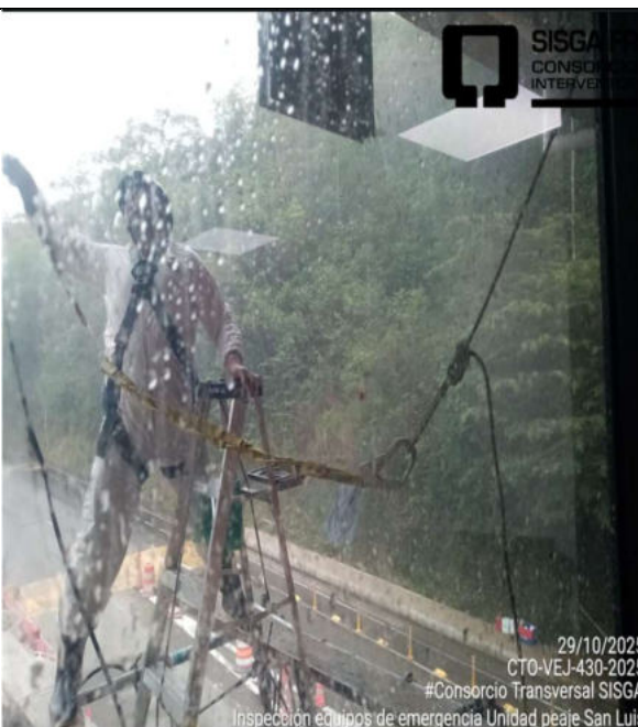
Inspección labores de mantenimiento con personal en alturas, peaje san Luis de Gaceno
