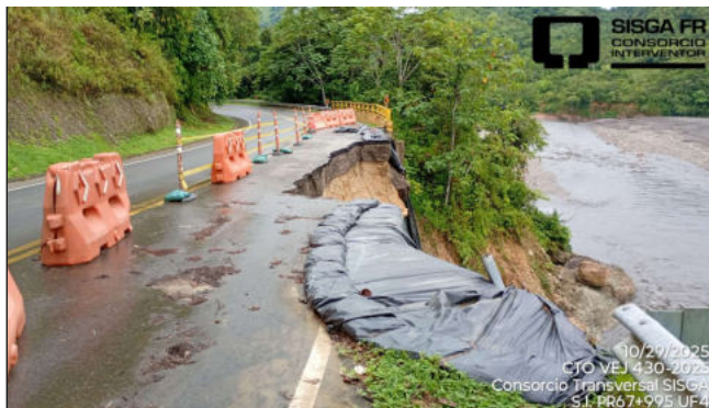
Sitio PR67+995 al PR68+000 Ruta 5608. Unidad Funcional 4. Se presenta erosión en talud inferior, debido a creciente súbita del río Lengupá. No relacionado en el Apéndice Técnico 1.
