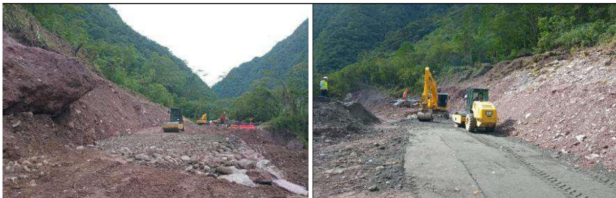
PR42+020. Sitio Inestable. Ruta 5608. Unidad Funcional 3. Extendido y compactación de granulares
