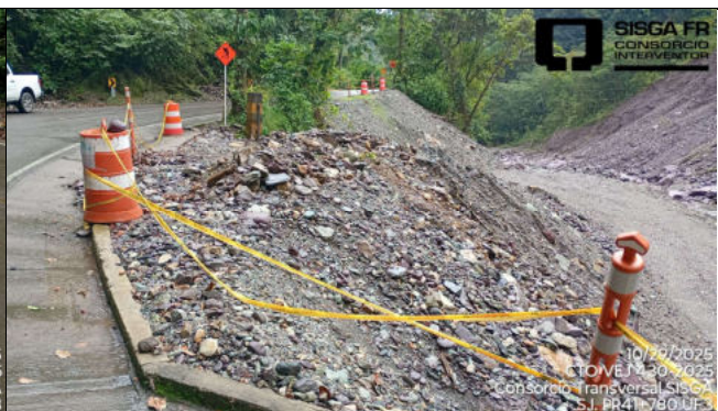
Sitio PR41+710 a PR41+780 Ruta 5608. Unidad Funcional 3. Se presenta erosión en talud inferior con pérdida de soporte de la cuneta debido a creciete súbita del río Batá. No relacionado en el Apéndice Técnico 1.
