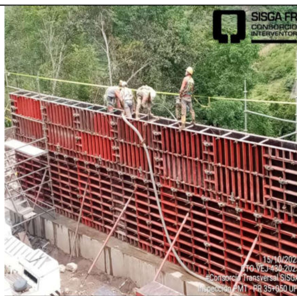
Utilización de equipos de seguridad obra PR35+050 UF1
