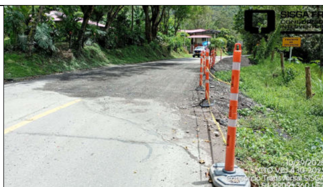
Sitio PR9+360 Ruta 5608. Unidad Funcional 2. Hundimiento de la calzada. No relacionado en Apéndice Técnico 1
