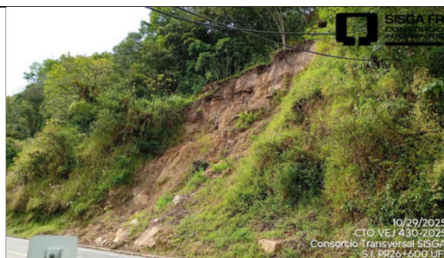
Sitio PR26+600 Ruta 5607 Unidad Funcional 1. Inestabilidad generada por la saturación que tiene el terreno. Activación de movimiento en masa. No relacionado en el Apéndice Técnico 1.
