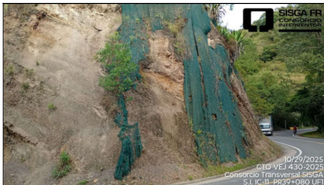
Sitio Contractual IC – 11 -PR39+080 Ruta 5607. Unidad Funcional 1. En la ilustración anterior se observan zonas con manto para control de erosión desprendidos y zonas sin protección con este elemento.
