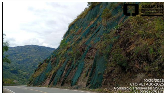
Sitio Contractual IC – 12 -PR39+270 Ruta 5607. Unidad Funcional 1. En la ilustración anterior se observan zonas con manto para control de erosión desprendidos y zonas sin protección con este elemento.
