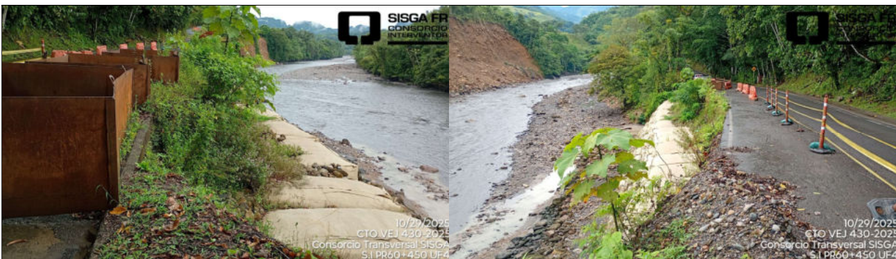
PR60+400. Instalación geocontenedores. Ruta 5608. Unidad Funcional 4.
