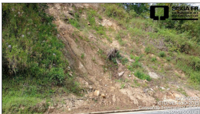
Sitio PR26+600 Ruta 5607 Unidad Funcional 1. Inestabilidad generada por la saturación que tiene el terreno. Activación de movimiento en masa. No relacionado en el Apéndice Técnico 1.
