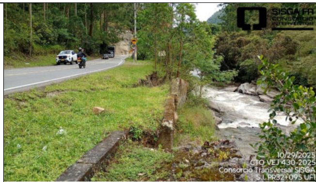
Sitio PR32+095. Ruta 5607. Unidad Funcional 1. Muro colapsado, grietas de tracción y hundimiento en la estructura del Pavimento. No relacionado Apéndice Técnico 1
