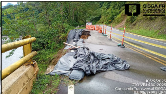
Sitio PR67+995 al PR68+000 Ruta 5608. Unidad Funcional 4. Se presenta erosión en talud inferior, debido a creciente súbita del río Lengupá. No relacionado en el Apéndice Técnico 1.
