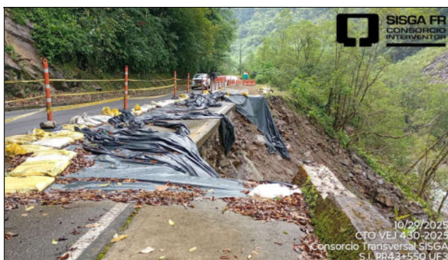
Sitio PR42+550 al PR42+590 Ruta 5608. Unidad Funcional 3. Se presenta perdida parcial de banca y erosión en talud inferior debido a creciete súbita del río Batá. No relacionado en el Apéndice Técnico 1.
