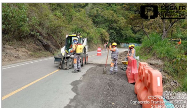
Sitio PR39+900 Ruta 5607. Unidad Funcional 1. Hundimiento de la calzada - No relacionado en el Apéndice Técnico. Talud Inferior
