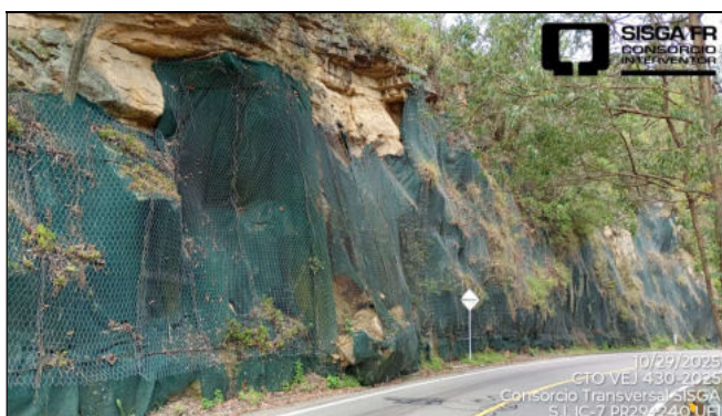
Sitio Contractual IC-7 - PR29+240. Ruta 5607. Unidad Funcional 1. En la ilustración anterior se aprecian la cantidad de bloques que han caído, se observan zonas con manto para control de erosión desprendidos y la malla triple torsión con pernos sueltos.
