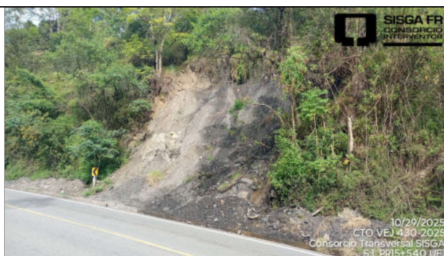
Sitio PR15+540 Ruta 5607. Unidad Funcional 1. Se observa un flujo de detritos y un movimiento en masa detonado por la saturación del suelo. No relacionado en el Apéndice Técnico 1.
