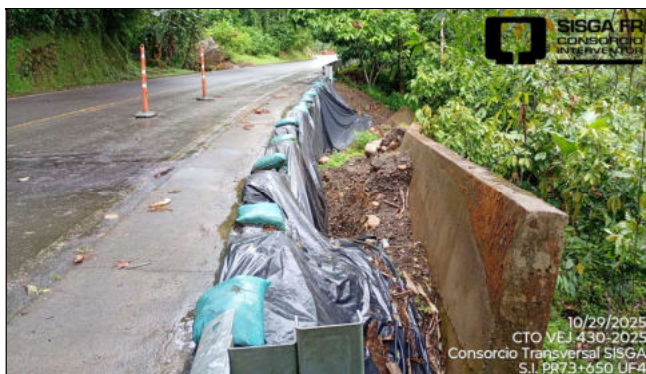
Sitio PR73+450 Ruta 5608. Unidad Funcional 4. Perdida de confinamiento de la calzada, No relacionado en el Apéndice Técnico 1.
