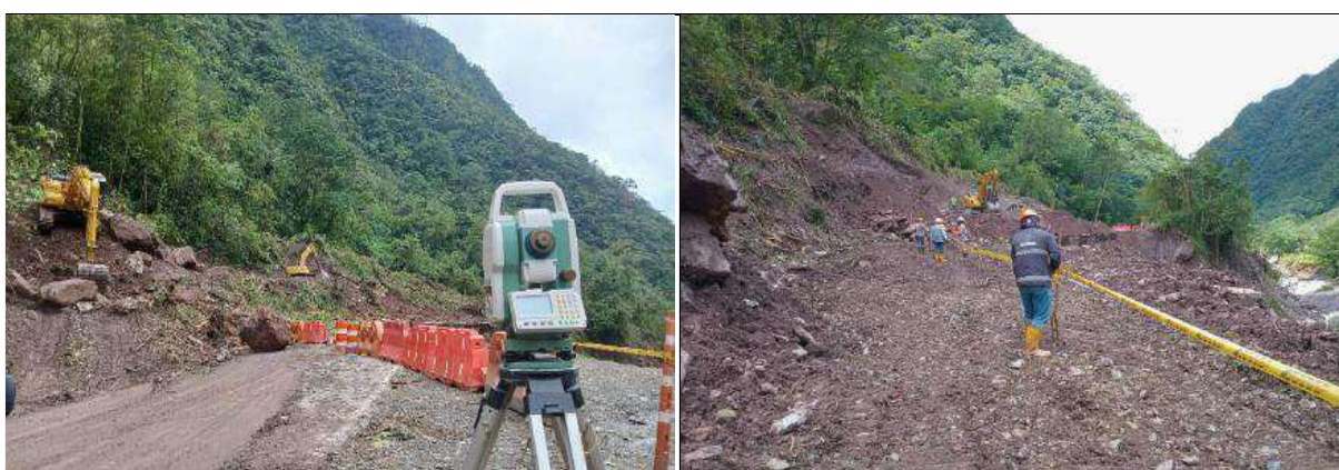
PR42+020. Sitio Inestable. Ruta 5608. Unidad Funcional 3. Control topográfico y señalización
