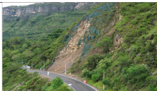
Sitio Contractual - IC-5 PR26+930 Unidad Funcional 1. – A lo largo de este talud se presenta caída de grandes bloques de areniscas, principalmente por falla en cuña y por erosión diferencial que los deja sin soporte, se observan zonas sin control de erosión en el talud con instalación de un conjunto de manto para control de erosión fijado con una malla triple torsión con pernos.
