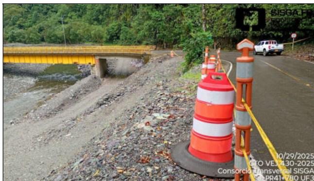
Sitio PR41+710 a PR41+780 Ruta 5608. Unidad Funcional 3. Se presenta erosión en talud inferior con pérdida de soporte de la cuneta debido a creciete súbita del río Batá. No relacionado en el Apéndice Técnico 1.
