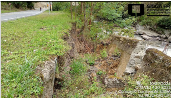
Sitio PR32+095. Ruta 5607. Unidad Funcional 1. Muro colapsado, grietas de tracción y hundimiento en la estructura del Pavimento. No relacionado Apéndice Técnico 1
