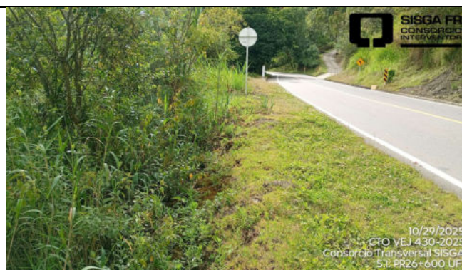
Sitio PR26+480 Ruta 5607 Unidad Funcional 1. Se evidencia grietas de tracción en el talud inferior. No relacionado en el Apéndice Técnico 1.
