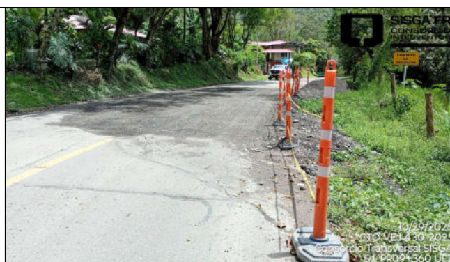
Sitio PR9+360 Ruta 5608. Unidad Funcional 2. Hundimiento de la calzada. No relacionado en Apéndice Técnico 1 Actividades de Mantenimiento: Demolición de carpeta de rodadura afectada fresado.
