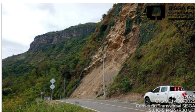
Sitio Contractual - IC-5 PR26+930 Unidad Funcional 1. – A lo largo de este talud se presenta caída de grandes bloques de areniscas, principalmente por falla en cuña y por erosión diferencial que los deja sin soporte, se observan zonas sin control de erosión en el talud con instalación de un conjunto de manto para control de erosión fijado con una malla triple torsión con pernos.
