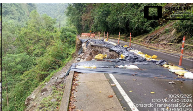
Sitio PR42+550 al PR42+590 Ruta 5608. Unidad Funcional 3. Se presenta perdida parcial de banca y erosión en talud inferior debido a creciete súbita del río Batá. No relacionado en el Apéndice Técnico 1.
