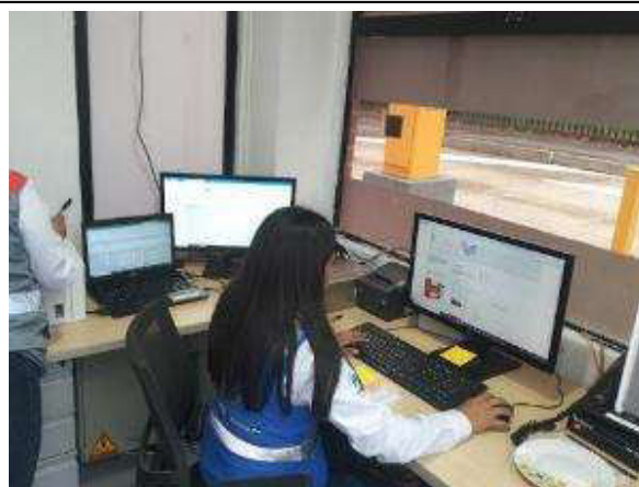
Equipos de control de peso y detección de sobrepeso
