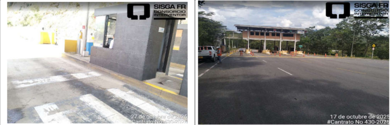
Demarcación de piso de los resaltos y del carril en la zona de recaudo y la zona de transición de la Estación de Peaje
