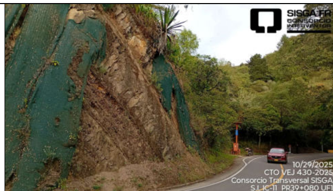
Sitio Contractual IC – 11 -PR39+080 Ruta 5607. Unidad Funcional 1. En la ilustración anterior se observan zonas con manto para control de erosión desprendidos y zonas sin protección con este elemento.
