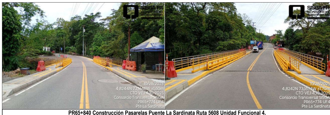
PR65+840 Construcción Pasarelas Puesto La Sardinata Ruta 5608 Unidad Funcional 4.
