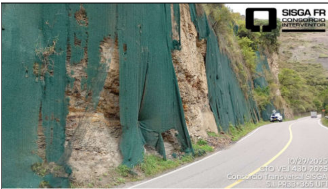
Sitio Contractual PR33+365. Ruta 5607. Unidad Funcional 1. En la ilustración anterior se aprecian, se observan zonas con manto para control de erosión desprendidos y zonas sin protección.
