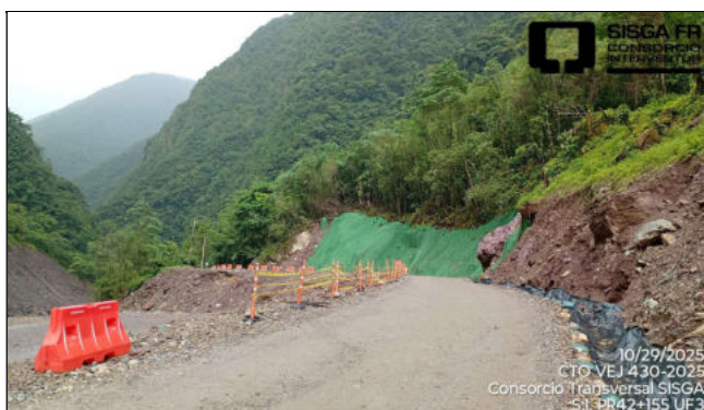
Sitio PR41+965 al PR42+155 Ruta 5608. Unidad Funcional 3. Se presenta pérdida total de la banca debido a creciete súbita del río Batá. No relacionado en el Apéndice Técnico 1.
