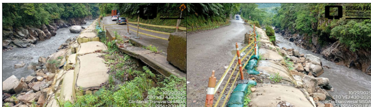
Sitio PR56+200 Ruta 5608. Unidad Funcional 4. Recuperación de la banca mediante la construcción de Geocontenedores
