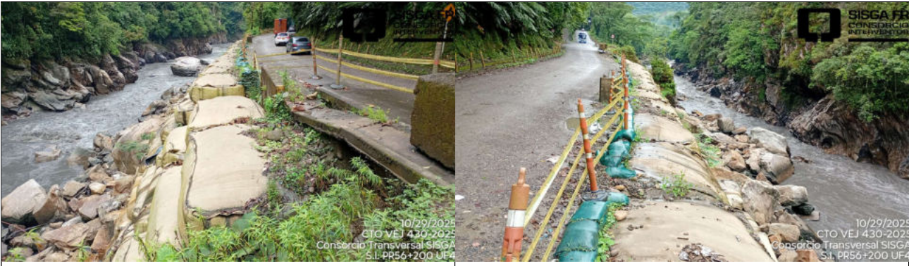
PR56+200. Instalación geocontenedores. Ruta 5608. Unidad Funcional 4.
