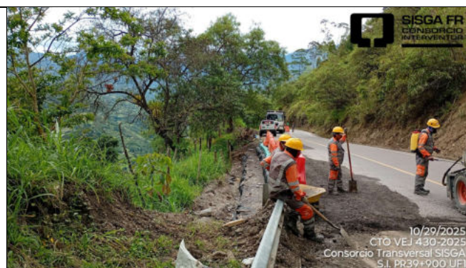
Sitio PR39+900 Ruta 5607. Unidad Funcional 1. Hundimiento de la calzada - No relacionado en el Apéndice Técnico. Talud Inferior
