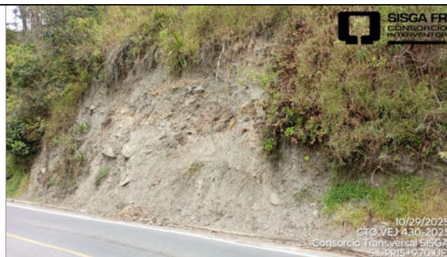
Sitio PR15+970. Ruta 5607. Unidad Funcional 1. La problemática que se presenta es una erosión en el talud superior. No relacionado en el Apéndice Técnico 1.
