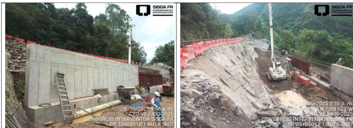
PR35+050. Sitio Inestable 64. Ruta 5607. Unidad Funcional 1. Avance de Obras
