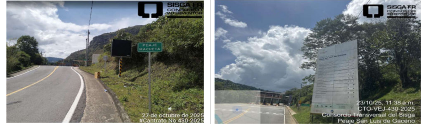
fabricación e instalación de la señalización vertical informativa y de aproximación a la Estación de Peaje
