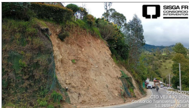
Sitio PR18+930 Ruta 5607. Unidad Funcional 1. Problemática de erosión en talud en el talud superior. No relacionado en el Apéndice Técnico 1.
