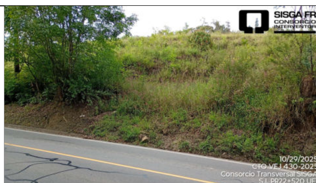
Sitio PR22+540 Ruta 5607 Unidad Funcional 1. Proceso de reptación en el talud superior debido a la saturación que tiene el terreno. Activación de movimiento en masa. No relacionado en el Apéndice Técnico 1.
