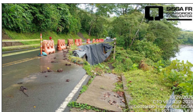
Sitio PR73+800 Ruta 5608. Unidad Funcional 4. Perdida de la banca, No relacionado en el Apéndice Técnico 1.
