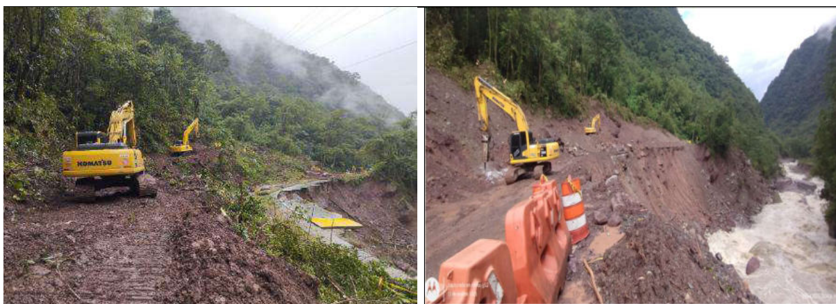
PR42+020. Sitio Inestable. Ruta 5608. Unidad Funcional 3. Corte y excavación carreteable temporal
