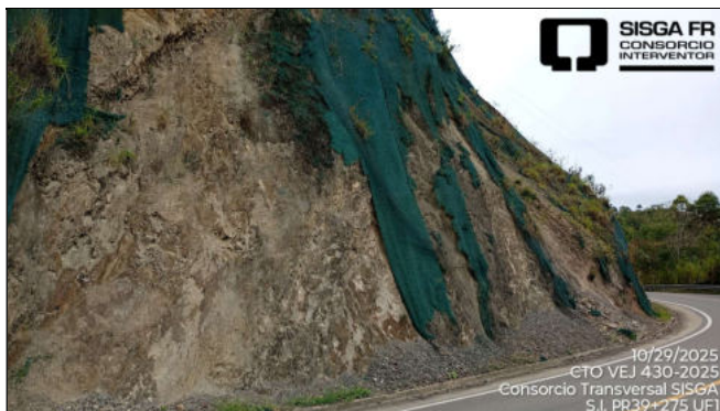
Sitio Contractual IC – 12 -PR39+270 Ruta 5607. Unidad Funcional 1. En la ilustración anterior se observan zonas con manto para control de erosión desprendidos y zonas sin protección con este elemento.
