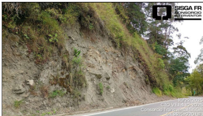
Sitio PR15+970. Ruta 5607. Unidad Funcional 1. La problemática que se presenta es una erosión en el talud superior. No relacionado en el Apéndice Técnico 1.
