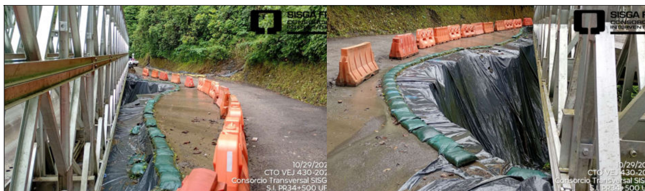
PR34+520. Puente Militar. Ruta 5608. Unidad Funcional 3.
