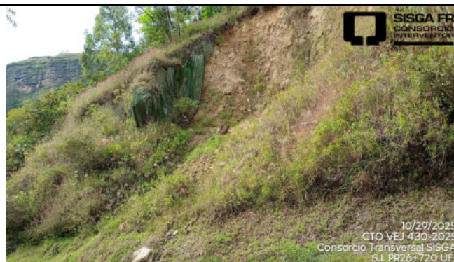
Sitio PR26+720 Ruta 5607 Unidad Funcional 1. Inestabilidad generada por la saturación que tiene el terreno. Activación de movimiento en masa. No relacionado en el Apéndice Técnico 1.
