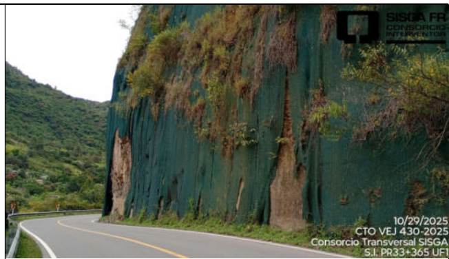
Sitio Contractual PR33+365. Ruta 5607. Unidad Funcional 1. En la ilustración anterior se aprecian, se observan zonas con manto para control de erosión desprendidos y zonas sin protección.
