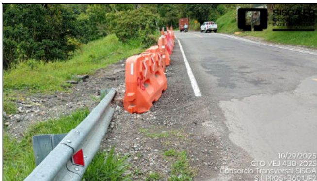
Sitio PR5+360. Ruta 5608. Unidad Funcional 2. Hundimiento de la calzada movimiento rotacional. No relacionado en Apéndice Técnico 1
