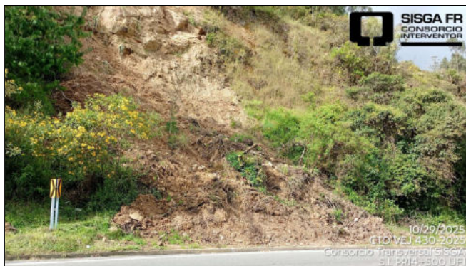
Sitio 25 – Contractual - PR14+500. Ruta 5607. Unidad Funcional 1 – Proceso de reptación en el talud superior debido a la saturación que tiene el terreno.
