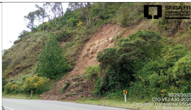
Sitio 25 – Contractual - PR14+500. Ruta 5607. Unidad Funcional 1 – Proceso de reptación en el talud superior debido a la saturación que tiene el terreno.
