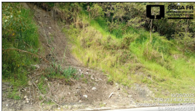
Sitio PR26+480 Ruta 5607 Unidad Funcional 1. Inestabilidad generada por la saturación que tiene el terreno. Activación de movimiento en masa. No relacionado en el Apéndice Técnico 1. No relacionado en el Apéndice Técnico 1.
