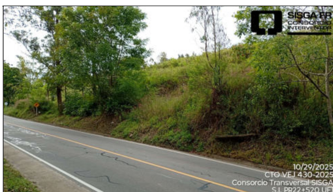
Sitio PR22+540 Ruta 5607 Unidad Funcional 1. Proceso de reptación en el talud superior debido a la saturación que tiene el terreno. Activación de movimiento en masa. No relacionado en el Apéndice Técnico 1.
