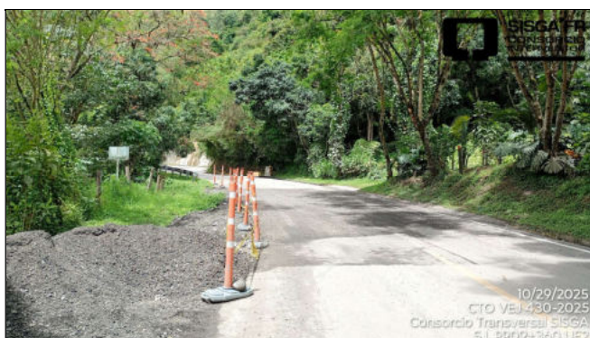
Sitio PR9+360 Ruta 5608. Unidad Funcional 2. Hundimiento de la calzada. No relacionado en Apéndice Técnico 1
