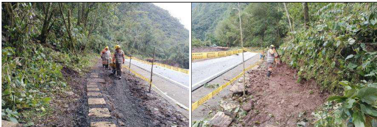
PR42+020. Sitio Inestable. Ruta 5608. Unidad Funcional 3. Adecuación paso peatonal
