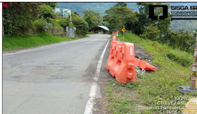
Sitio PR5+360. Ruta 5608. Unidad Funcional 2. Hundimiento de la calzada movimiento rotacional. No relacionado en Apéndice Técnico 1
