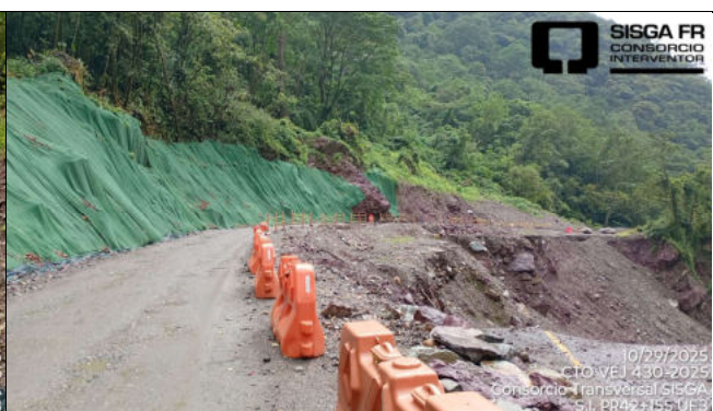
Sitio PR41+965 al PR42+155 Ruta 5608. Unidad Funcional 3. Se presenta pérdida total de la banca debido a creciete súbita del río Batá. No relacionado en el Apéndice Técnico 1.
