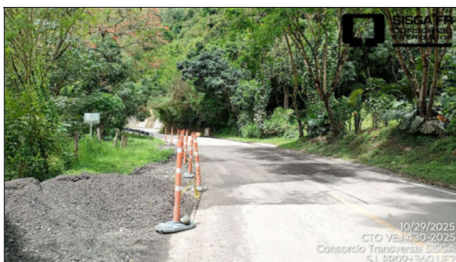
Sitio PR9+360 Ruta 5608. Unidad Funcional 2. Hundimiento de la calzada. No relacionado en Apéndice Técnico 1 Actividades de Mantenimiento: Demolición de carpeta de rodadura afectada fresado.
