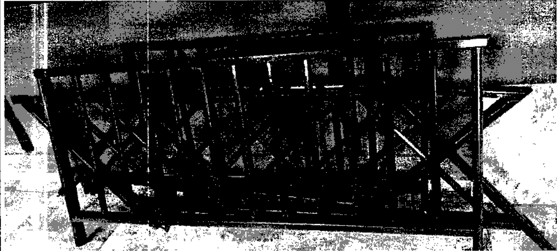
LIJADA, RESANE, INMUNIZACIÓN Y BARNIZ DE REJA EN MADERA ZONA GRADAS INTERNAS
