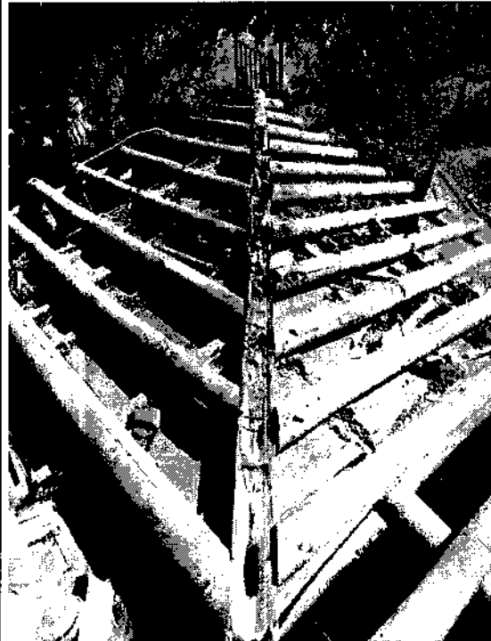
LIJADA, ESMALTE, DESMONTE, RETIRO Y REPOSICIÓN DE GUADUAS MAL ESTADO:
