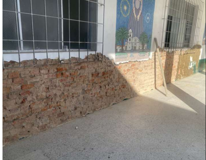
Demolición de pañetes.
