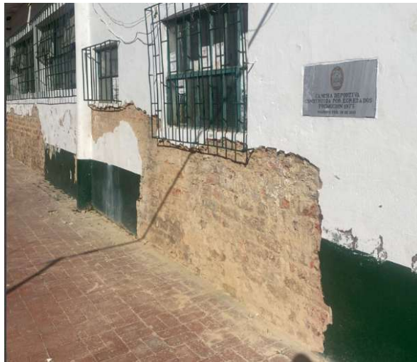
Demolición de pañetes.
