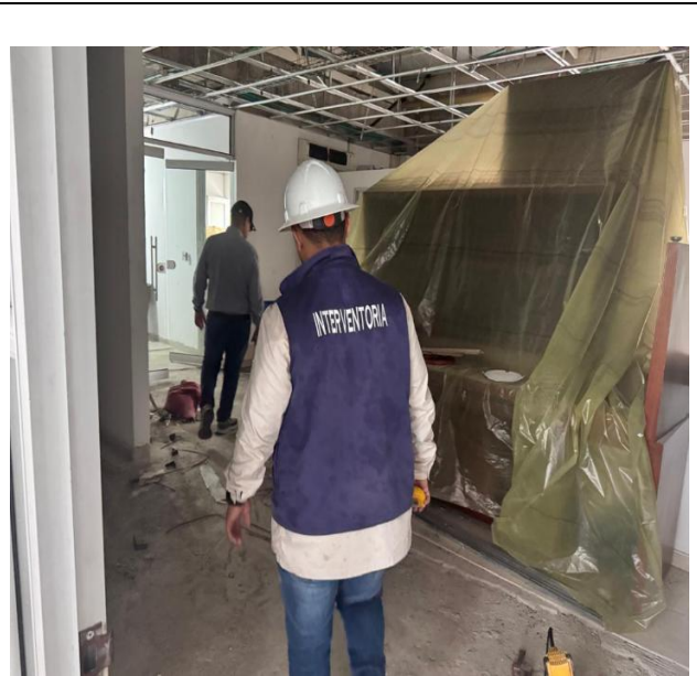
Ubicación séptima brigada, se realiza control y seguimiento en el suministro e instalación de cieloraso.
