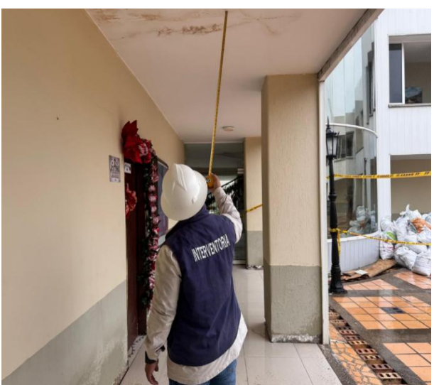
Ubicación cuarta división, se realiza control y seguimiento en la verificación de medidas.
