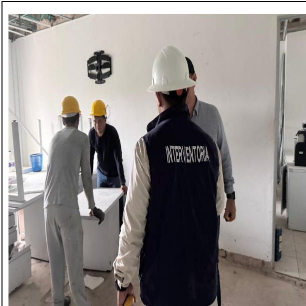
Ubicación séptima brigada, se realiza control y seguimiento en el suministro e instalación de cieloraso.
