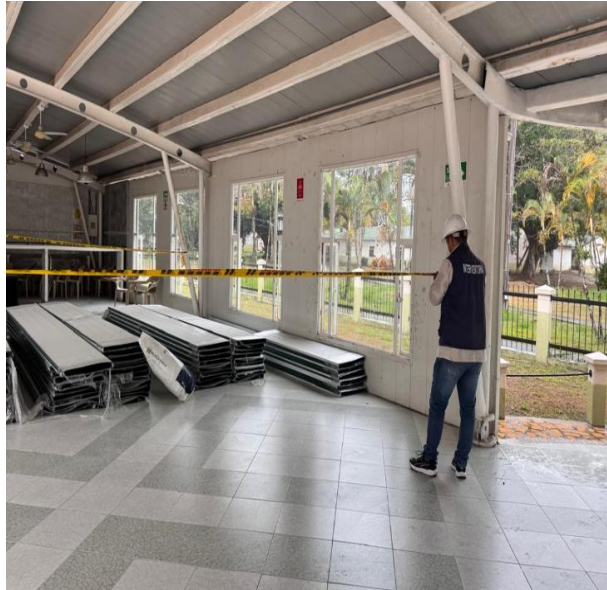
Ubicación cuarta división, se realiza control y seguimiento en la verificación de enchape y suministro de la teja.
