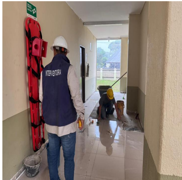
Ubicación cuarta división, se realiza control y seguimiento en la verificación de medidas en la instalación del enchape.
