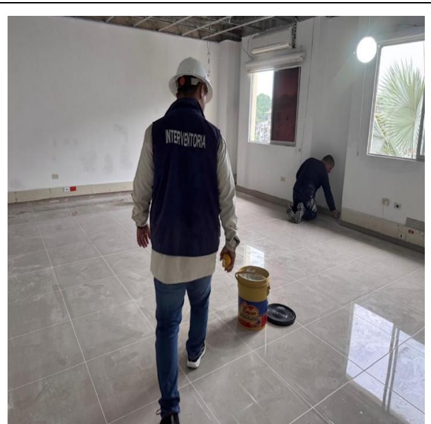
Ubicación séptima brigada, se realiza control y seguimiento en el suministro e instalación del enchape.
