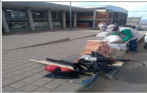
Suministro de materiales
