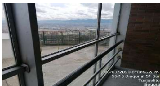
Perfiles y tubos instalados en forma horizontal y vertical
