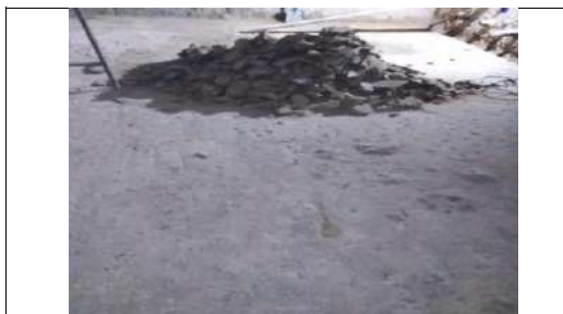
Retiro de pañete en tanque 2
