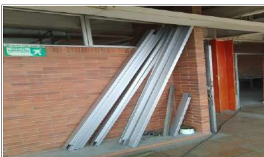
Suministro de materiales
