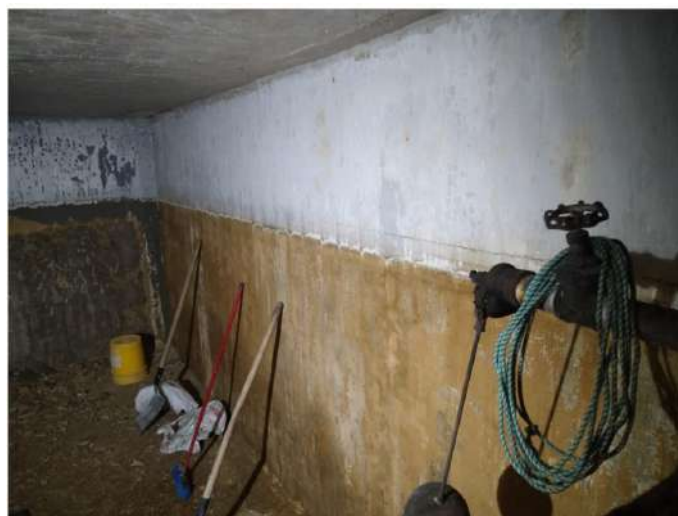
ESTADO GENERAL DE MUROS
