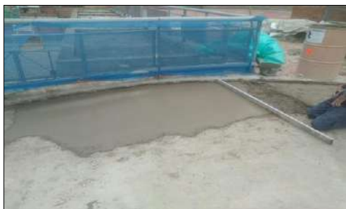
Mortero de nivelación en placa 2
