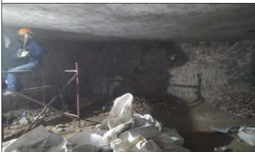
Retiro de pañete en tanque subterráneo de almacenamiento de agua potable
