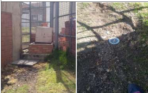
Revisión del estado del trazado de la tubería hidráulica
