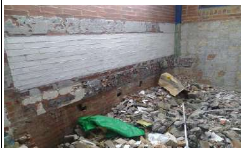
Demolición de lavamanos en batería sanitaria segundo piso
