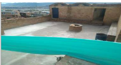
Mortero de nivelación terminado
