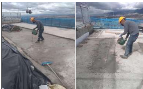
Sellado de fisuras en placa 1
