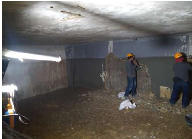
RETIRO DE PAÑETES EXISTENTES
