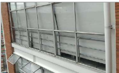
Verificación de instalación del reforzamiento en la estructura en el tercer piso
