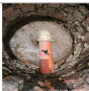
Limpieza de materia y verificación de su estado
