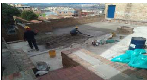
Mortero de nivelación de placa
