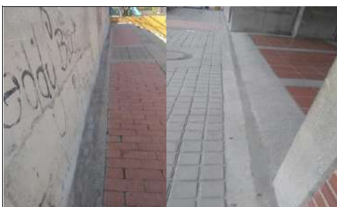
Revisión del estado del trazado de la tubería hidráulica
