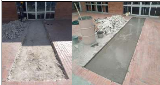
Levantamiento de adoquin y realización de mortero de nivelación
