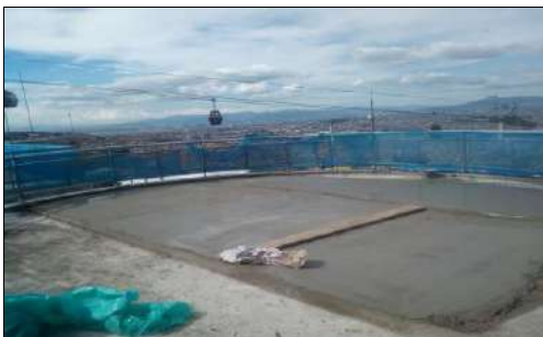
Mortero de nivelación en placa 2
