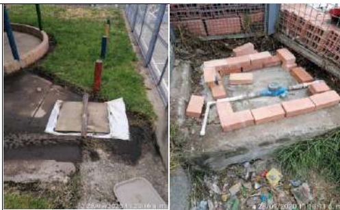
Realización de tapa e inicio de caja para acometida hidráulica.
