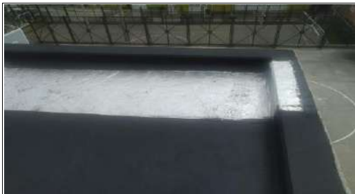
Inicio de impermeabilización con manto foil de aluminio en terrazas del segundo piso
