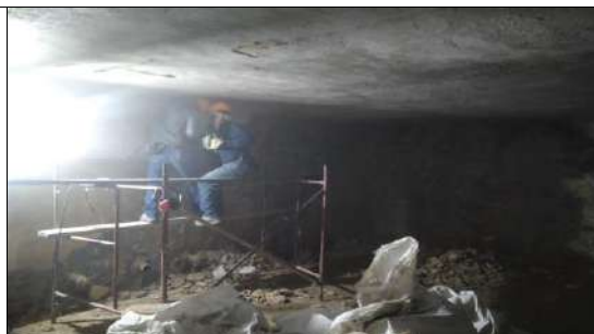
Retiro de pañete en tanque subterráneo de almacenamiento de agua potable
