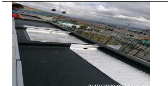
Inicio de impermeabilización con manto foil de aluminio en terrazas del segundo piso
