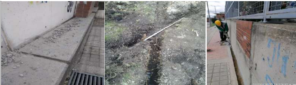
Excavación en tierra y perforaciones en concretos para trazado de tubería hidráulica para llenado de tanque.
