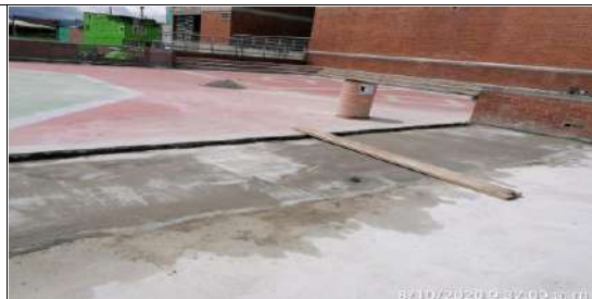
Se terminó con la realización de mortero de nivelación en las placas intervenidas en el segundo piso
