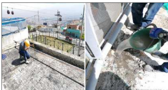
Suministro de materiales, verificación de niveles y pruebas a bajantes
