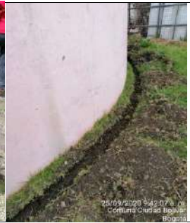
Excavación para tubería hidráulica
