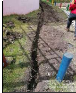
Excavación para tubería hidráulica
