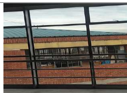
Verificación de instalación del reforzamiento en la estructura en el tercer piso
