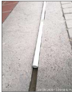
Excavación para tubería hidráulica
