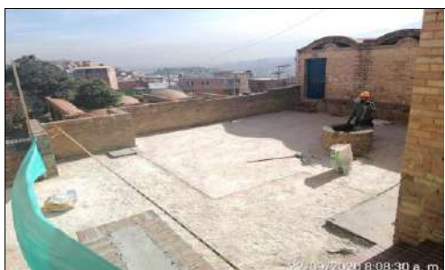
Limpieza de placa
