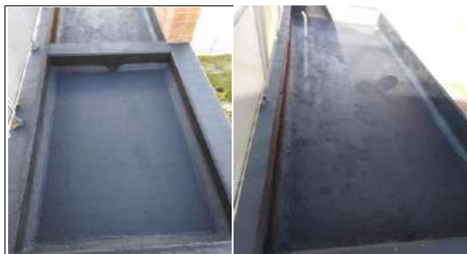
Aplicación de emulsion en terrazas
