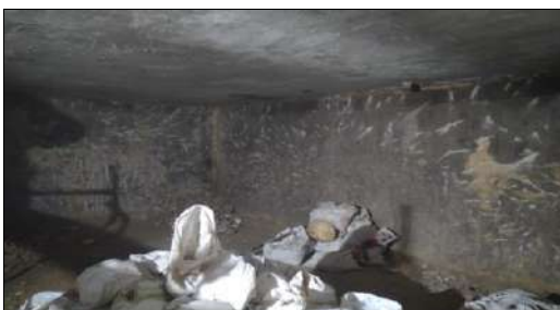
Retiro de pañete en tanque subterráneo de almacenamiento de agua potable
