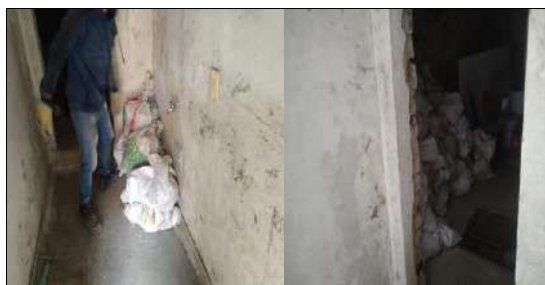
Acopio de residuos de retiro de pañete de tanque
