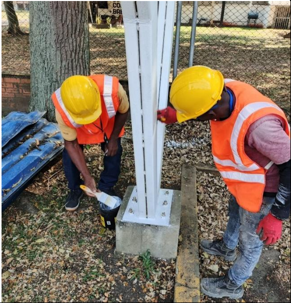
Aplicación de anticorrosivo y esmalte
