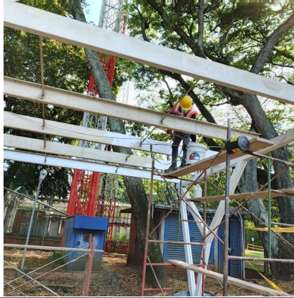
Aplicación de anticorrosivo y esmalte
