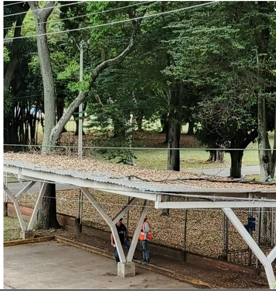
Limpieza de cubierta
