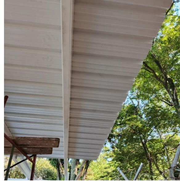
Instalación de teja termoacústica ecoroof upvc
