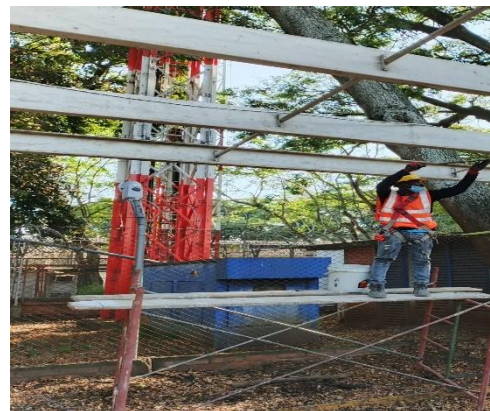
Limpieza de estructura metálica
