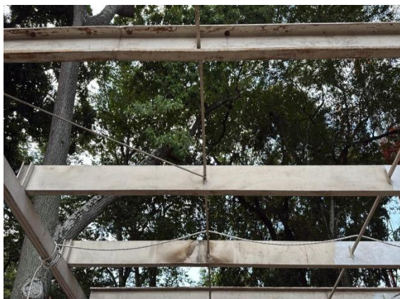
Limpieza de estructura metálica
