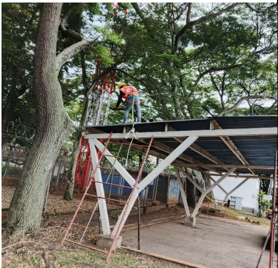
Limpieza de cubierta
