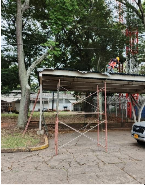
Limpieza de cubierta
