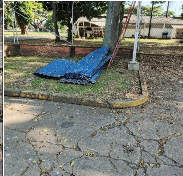
Desmonte de teja
