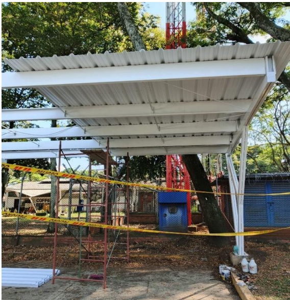
Instalación de teja termoacústica ecoroof upvc
