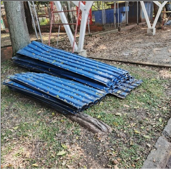
Desmonte de teja
