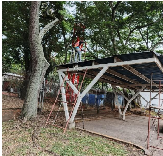
Limpieza de cubierta
