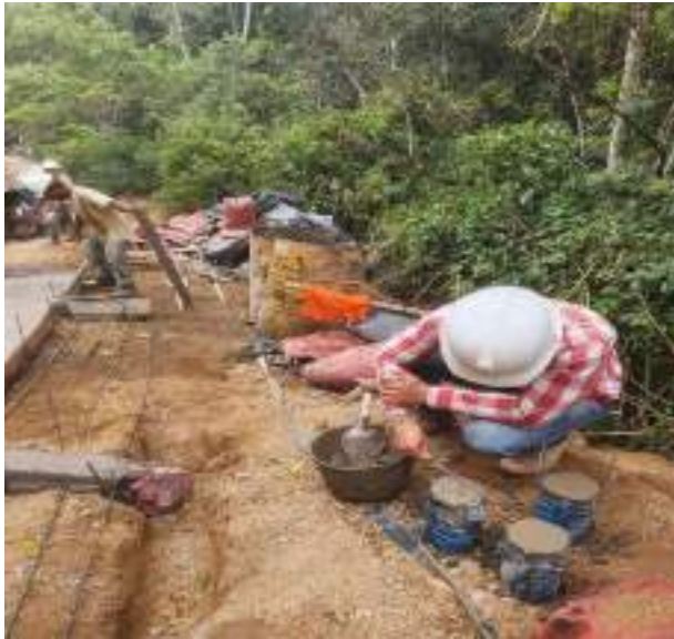
Ilustración 3. Fundición in situ de placa huella con concreto de 3000 psi y se toman muestras de concreto.
