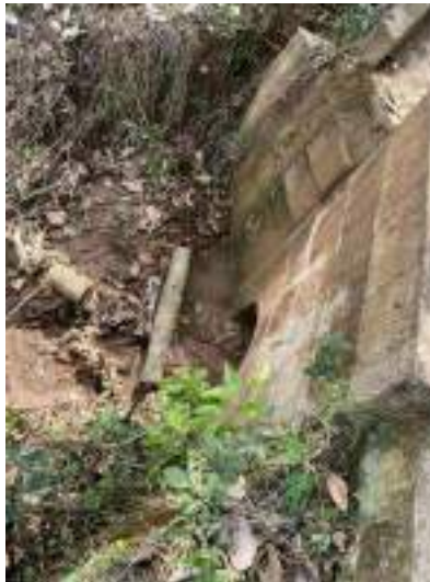
Ilustración 3. Alcantarilla existente No. 2 K0+663
