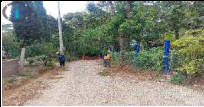
Descripción: A678 Nivelación de terreno para instalación de bordillo - Sector ortiz
