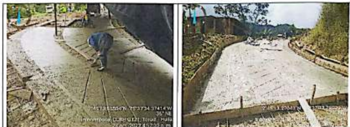
Ilustración 3. Tramo de vía construir mediante placa huella – El Paraíso – Tramo 1
