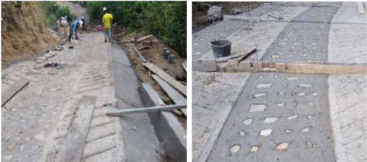
Ilustración 2. Fundición in situ de concreto Ciclópeo con concreto de 3000 psi
