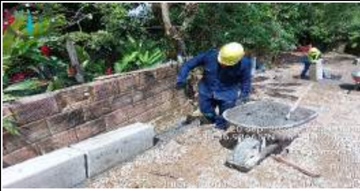
Descripción: Instalacion de bordillo - Sector ortiz
