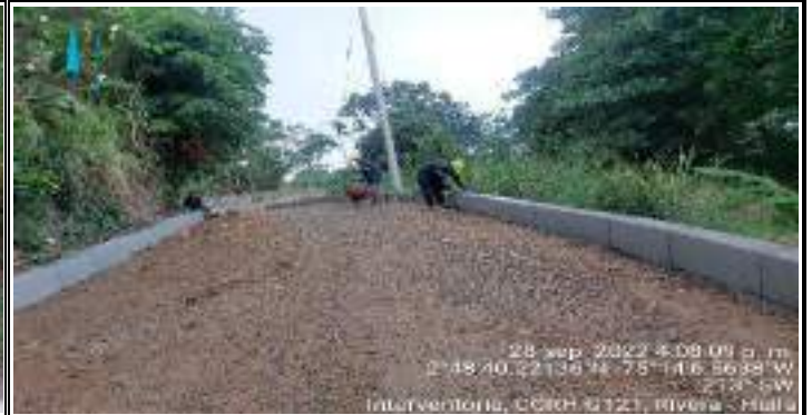
Descripción: Instalacion de bordillo - Sector ortiz
