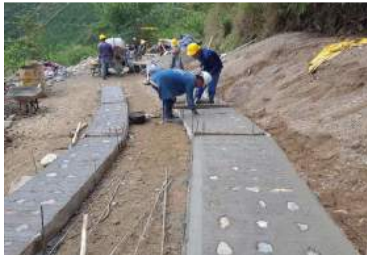
Ilustración 3. Fundición in situ de ciclópeo.
