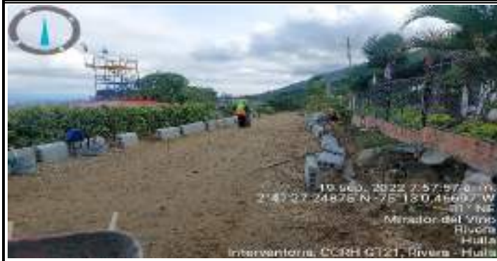
Descripción: Instalacion de bordillo.
