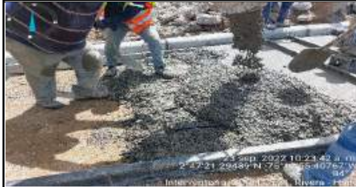
Descripción: Proceso de instalación de juntas de transferencia para la pavimentación de la vía en concreto.
