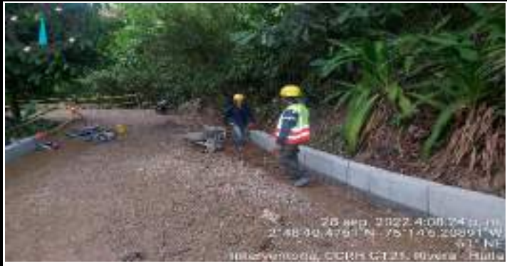
Descripción: Instalacion de bordillo - Sector ortiz
