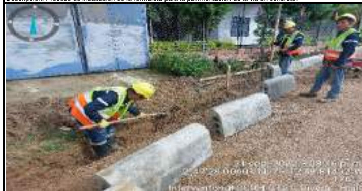
Descripción: Instalacion de bordillo.
