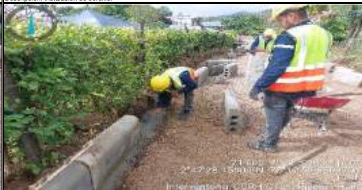
Descripción: Instalacion de bordillo.
