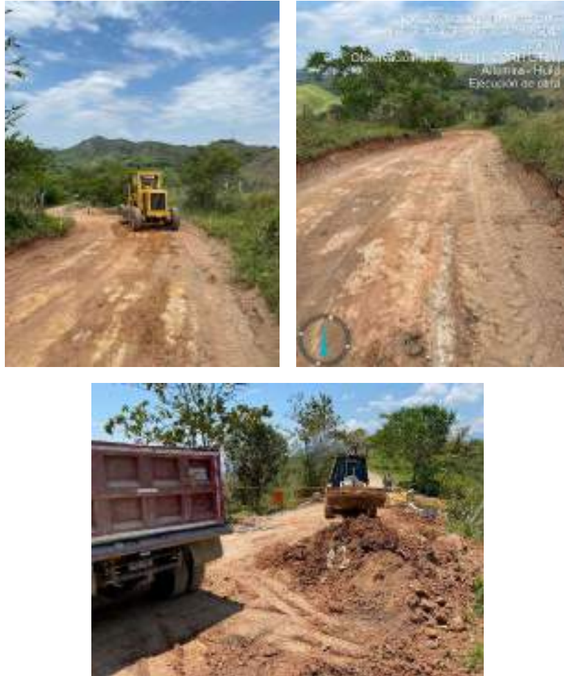
Ilustración 10. Excavación y retiro de material sobrante.
