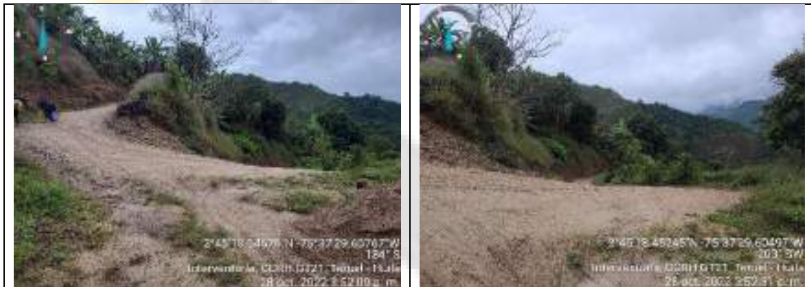
Ilustración 2. Tramo de vía construir mediante placa huella – El Paraíso – Tramo 2
