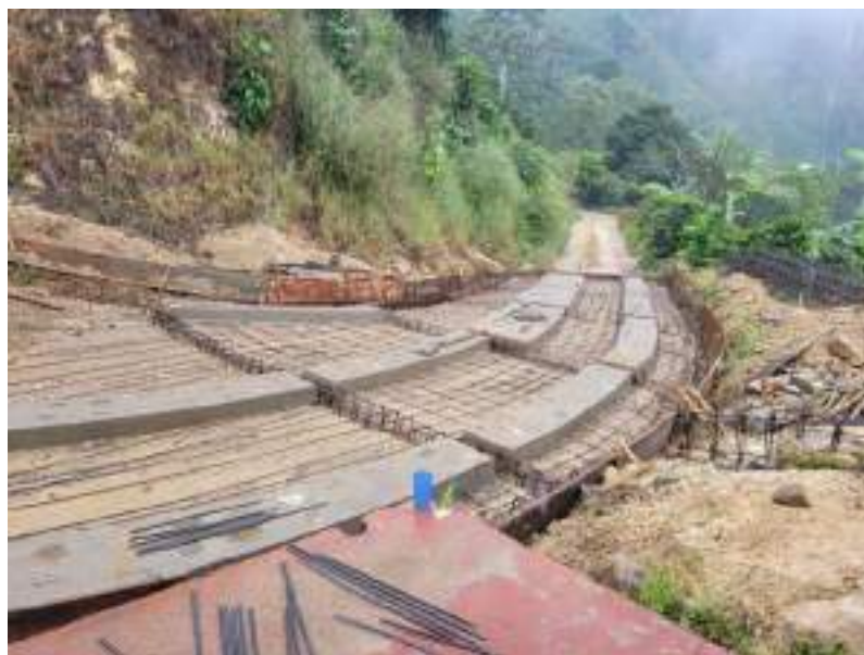
Ilustración 3. Instalación de acero de refuerzo para placa huella.
