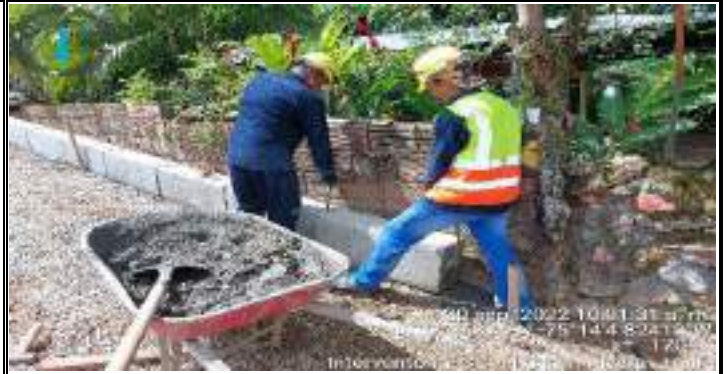
Descripción: Instalacion de bordillo - Sector ortiz
