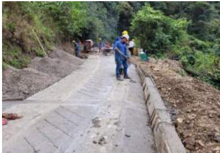
Ilustración 2. Fundición in situ de huella y bordillo con concreto in situ de 3000 psi.
