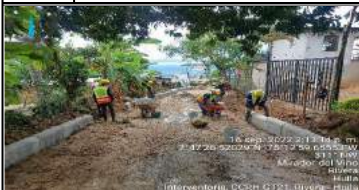
Descripción: Instalacion de bordillo.
