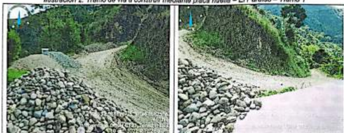
Ilustración 2. Tramo de vía a construir mediante placa huella – El Paraiso – Tramo 1
