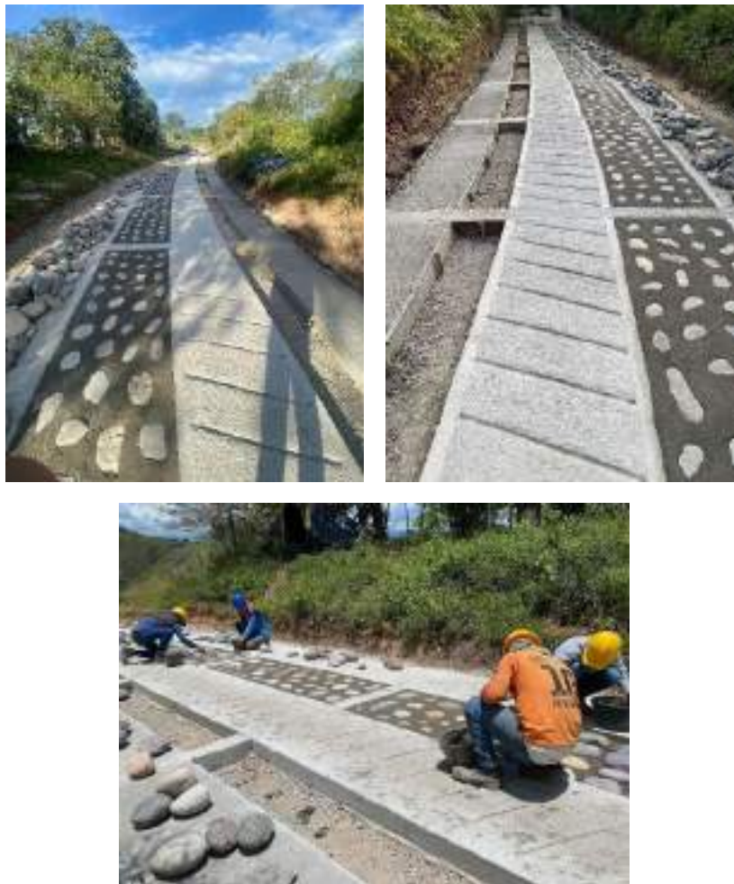
Ilustración 13. Instalación de concreto ciclópeo.
