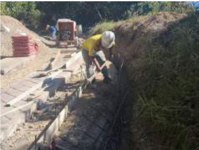
Ilustración 1. Excavación manual para cunetas riostras y bordillo
