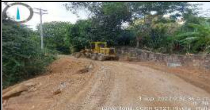
Descripción: Nivelacion con material para la subbase para la via - Sector ortiz
