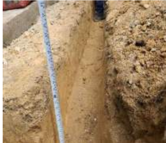
Ilustración 1. Excavación manual para cunetas riostras y bordillo
