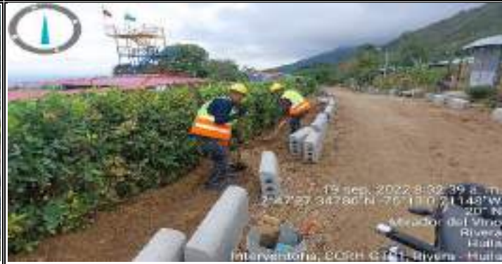
Descripción: Instalacion de bordillo.
