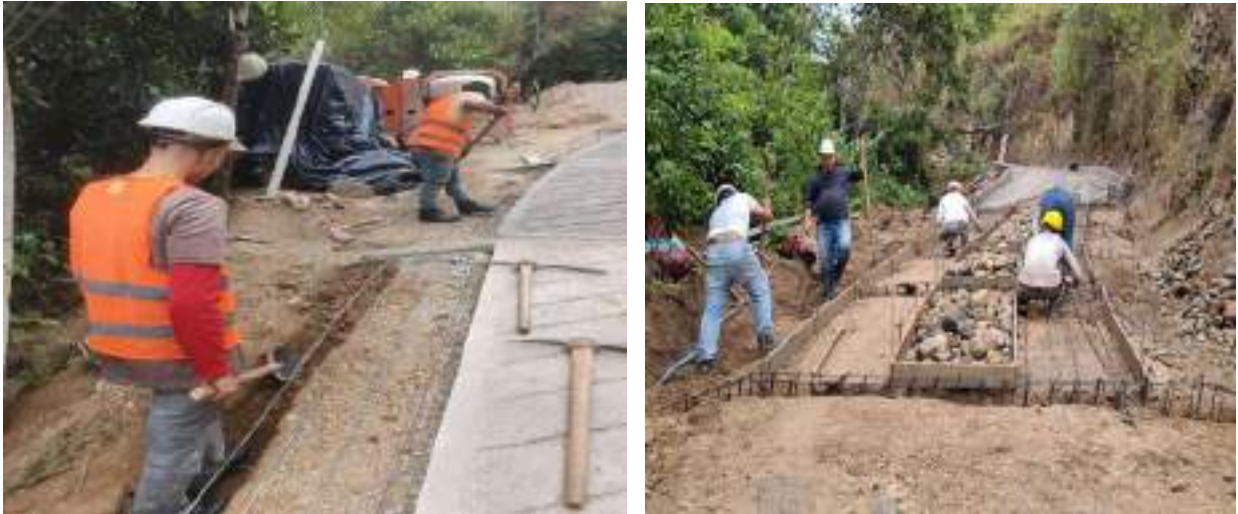
Ilustración 1. Excavación manual para riostras, cunetas y bordillos
