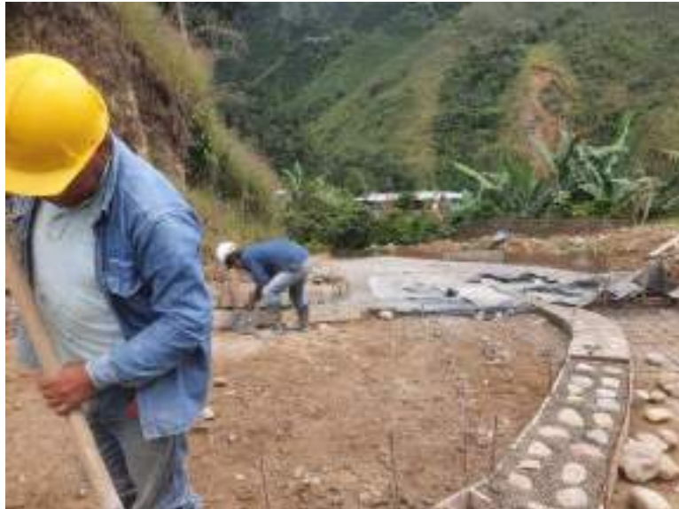
Ilustración 2. Fundición in situ de concreto ciclópeo.
