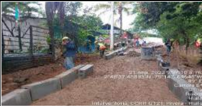
Descripción: Nivelacion de terreno para instalacion de bordillo - Sector ortiz
