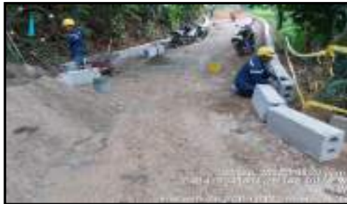
Excavación, perfilado y nivelación de la subrasante desde el K 0+000 al K 1+600 - Sector los miradores
