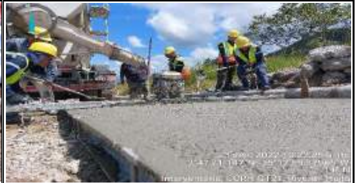
Descripción: Proceso de compactacion del concreto con regla vibratoria modular.
