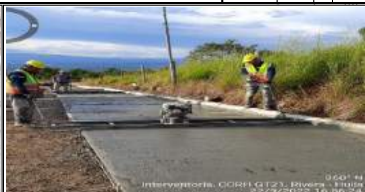
Descripción: Proceso de compactación del concreto con regla vibratoria modular.
