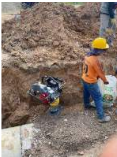
Ilustración 9. Relleno en recebo común.
