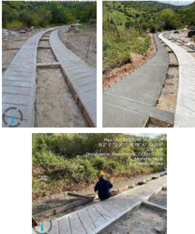
Ilustración 12. Construcción de placa huella y cunetas.
