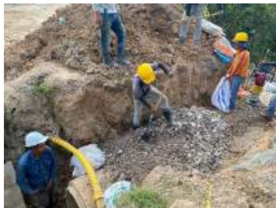
Ilustración 5. Instalación de tubería y encofrado.
