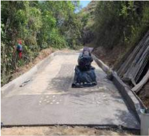
Ilustración 5. Placa huella terminada con placa de acceso
