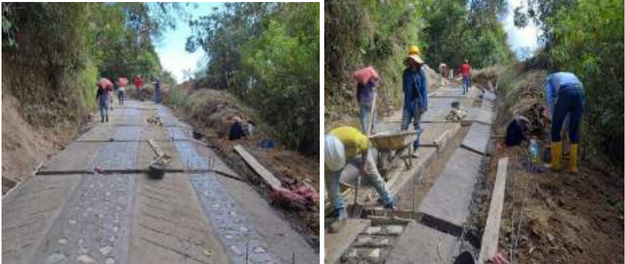
Ilustración 4. Fundición in situ de ciclópeo.
