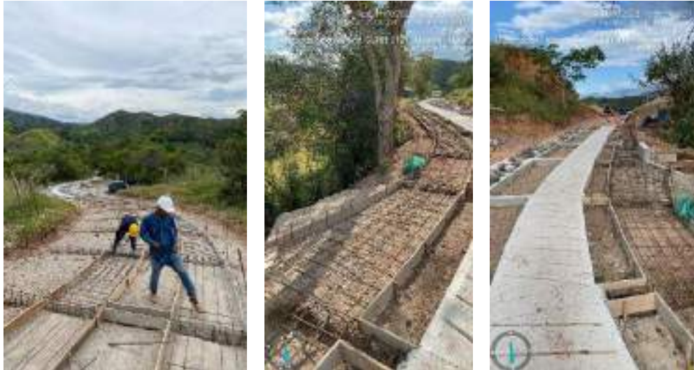
Ilustración 14. Figurado y amarrado de acero longitudinal y transversal.
