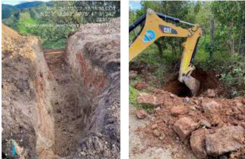
Ilustración 4. Excavaciones en alcantarilla No. 3 K0+520
