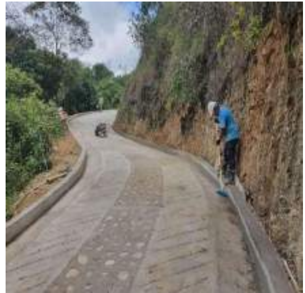
Ilustración 3. Fundición in situ de placa huella con concreto de 3000 psi y se toman muestras de concreto.
