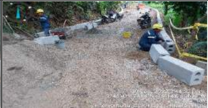
Descripción: Instalación de bordillo - Sector ortiz
