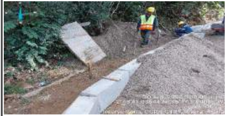
Descripción: Instalación de bordillo - Sector ortiz
