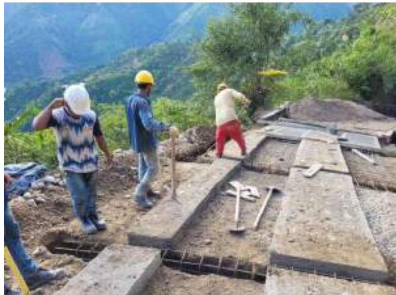
Ilustración 1. Excavación manual para cunetas riostras y bordillo
