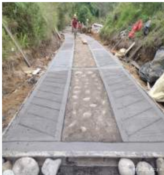
FUNDICION DE VIGAS RIOTRAS EN CONCRETO CLASE "D"
