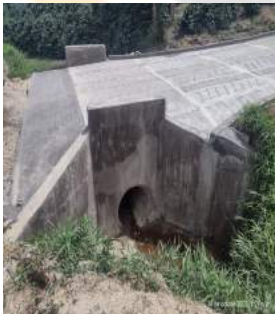
CONSTRUCCION OBRA TRANSVERSAL
