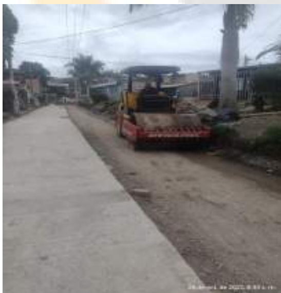
COMPACTACION MECANICA CON EQUIPO VIBROCOMPATADOR
