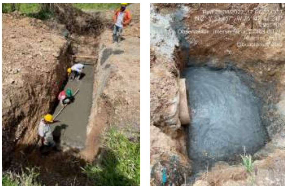
Ilustración 6. Solado para tubería en alcantarilla No.2 k0+663.
