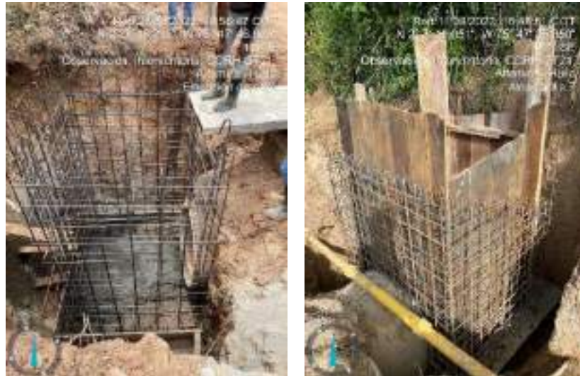
Ilustración 8. Figurado y armado de acero para pocetas.
