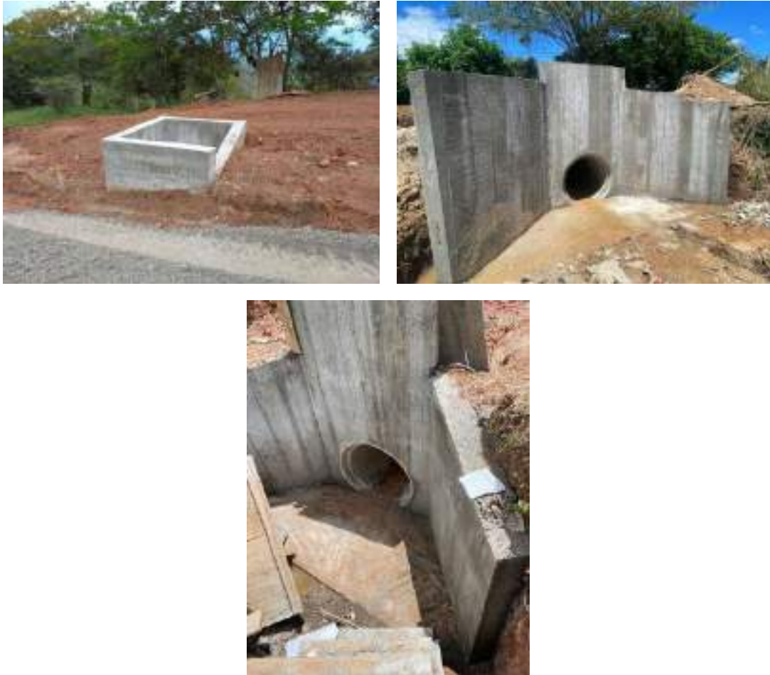
Ilustración 7. Cabezote y aletas alcantarilla No. 7 K0+999.
