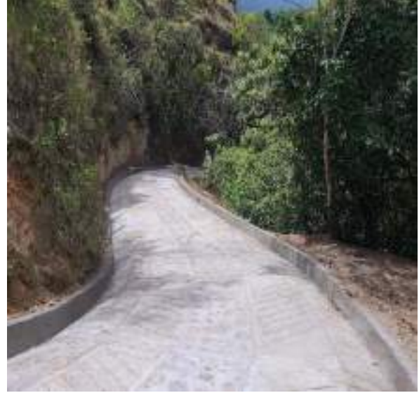
Ilustración 5. Placa huella terminada con placa de acceso
