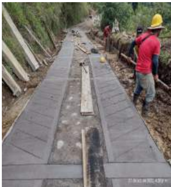
FUNDICION EN PLACA HUELLAS EN CONCRETO CLASE "D"
