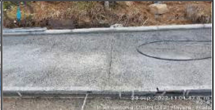
Descripción: Se realizo juntas de dilatación sobre el pavimento.
