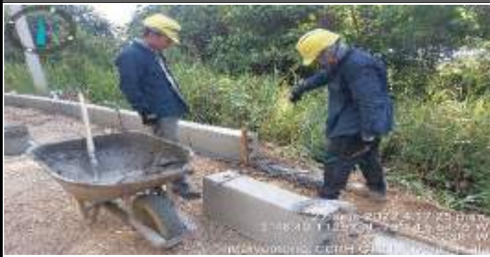
Descripción: Instalacion de bordillo - Sector ortiz
