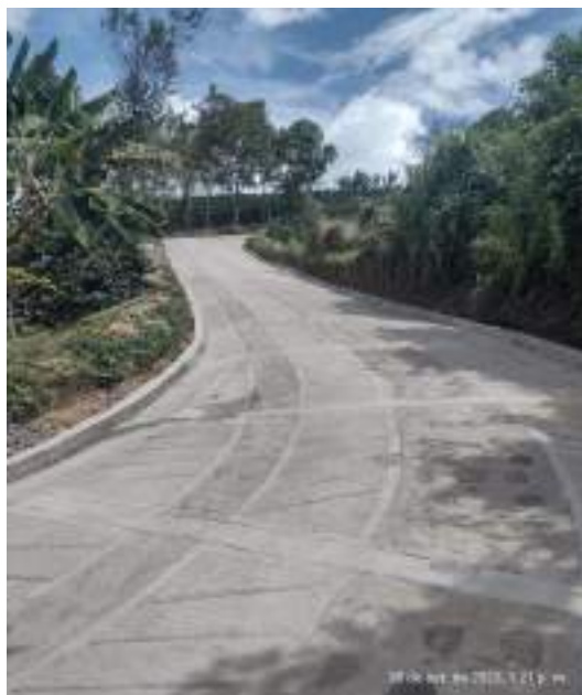
CONSTRUCCION PLACA HUELLA EN CONCRETO CLASE D
