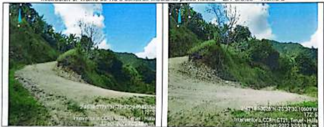
Ilustración 3. Tramo de vía a construir mediante placa huella – El Paraiso – Tramo 2
