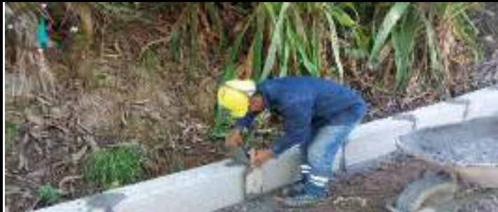
Descripción: Nivelacion de terreno para instalacion de bordillo - Sector ortiz
