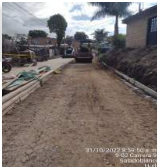
MEJORAMIENTO SUB BASE GRANULAR Y COMPACTACION MECANICA
