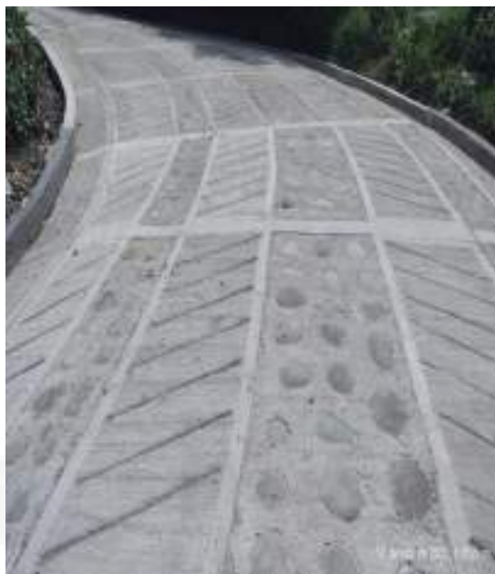
CONSTRUCCION PLACA HUELLA EN CONCRETO CLASE D
