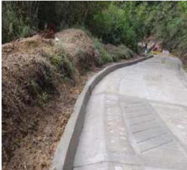
Ilustración 2. Relleno de espaldares de los bordillos de la placa huella.
