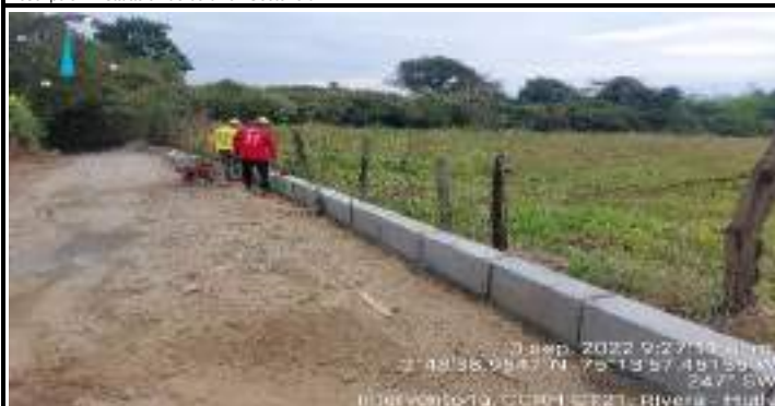
Descripción: Instalacion de bordillo - Sector ortiz
