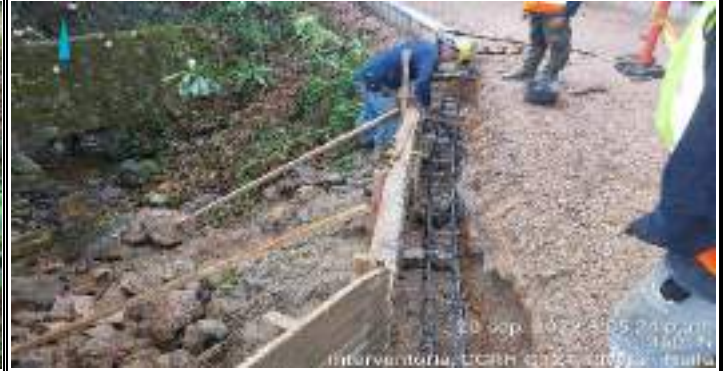
Descripción: Instalación de la formaleta para vaciado de concreto para el realce de las aletas - sector ortiz
