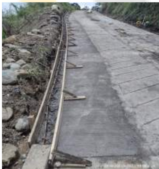
MODULACION Y FUNDICION DE CUNETAS EN CONCRETO CLASE "D"
