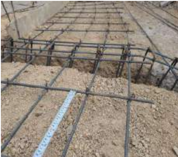
Ilustración 4. Instalación de acero de refuerzo en obra.
