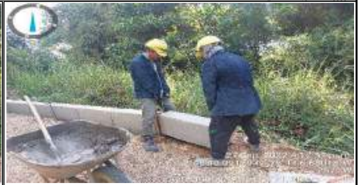
Descripción: Instalacion de bordillo - Sector ortiz
