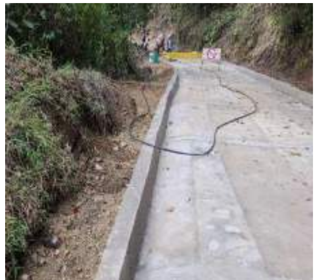
Ilustración 2. Relleno de espaldares de los bordillos de la placa huella.
