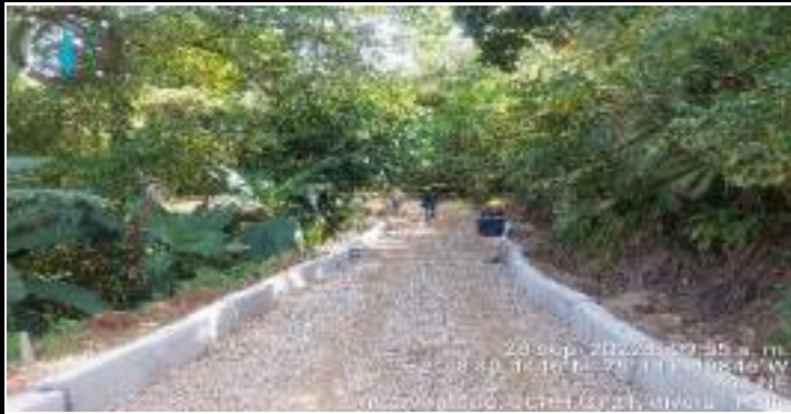
Descripción: Instalacion de bordillo - Sector ortiz
