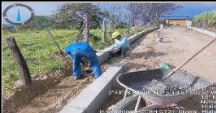
Descripción: Instalacion de bordillo - Sector ortiz
