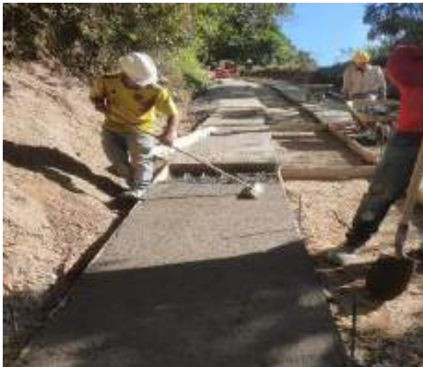
Ilustración 3. Fundición in situ de huellas con concreto de 3000 psi.
