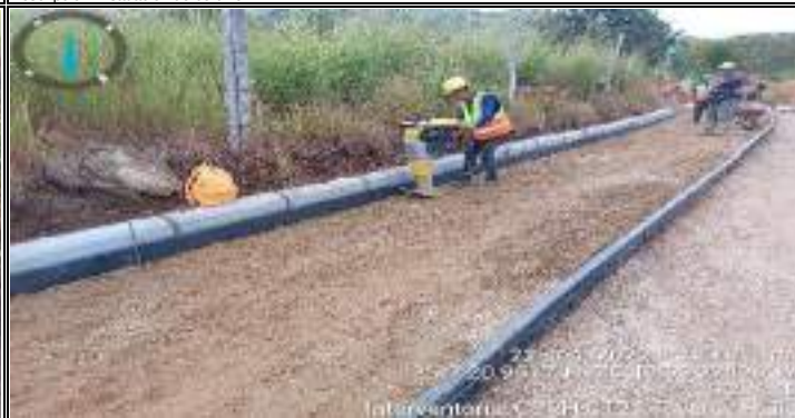
Descripción: Proceso de compactacion para la pavimentacion de la via.
