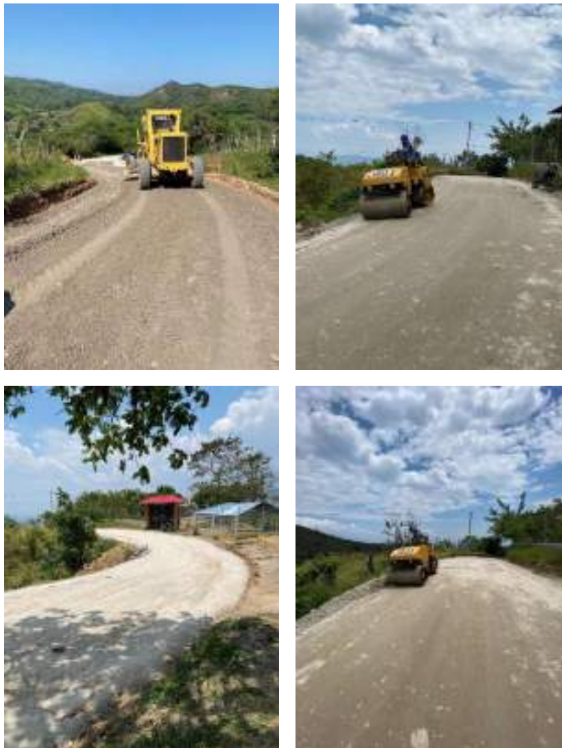
Ilustración 11. Afirmado y compactación.
