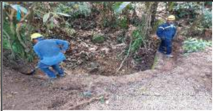
Descripción: Proceso de limpieza de la alcantarilla para realce de las aletas en concreto - sector ortiz U953
