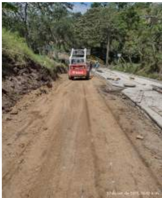
INSTALACION Y MEJORAMIENTO MECANICO DE SUB BASE GRANULAR - K 00+ K 0+130
