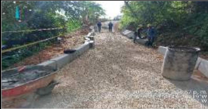
Descripción: Instalación de bordillo - Sector ortiz
