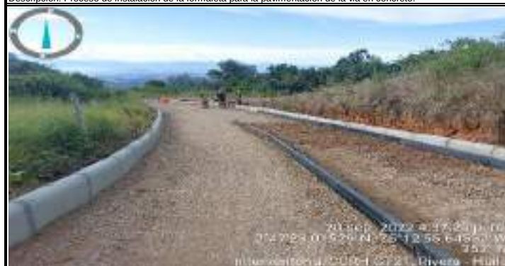
Descripción: Proceso de instalacion de la formaleta para la pavimentacion de la via en concreto.
