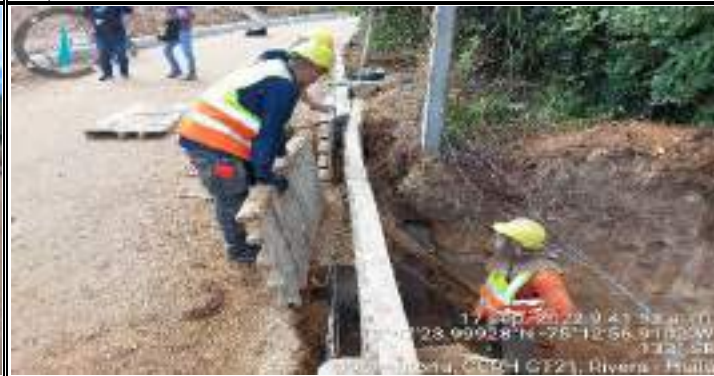
Descripción: Proceso de instalacion de formaleta y vaciado de concreto para guardaruedas.
