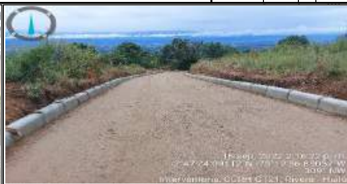
Descripción: Instalacion de bordillo.
