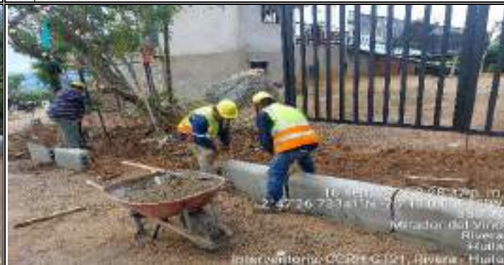
Descripción: Instalacion de bordillo.
