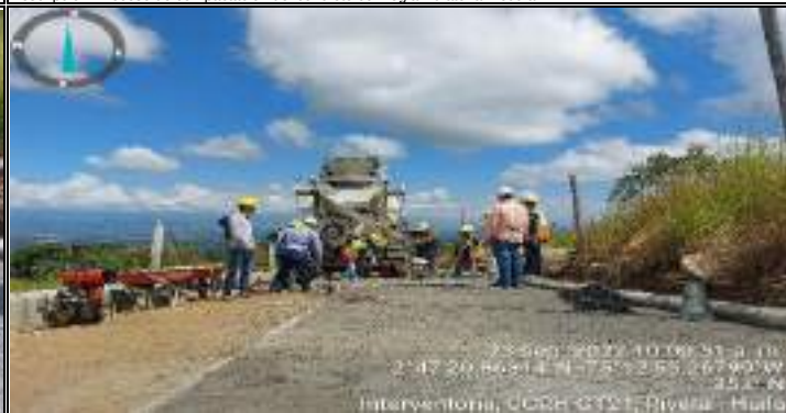
Descripción: Proceso de vaciado de concreto para pavimentación de una calzada de la vía en concreto.
