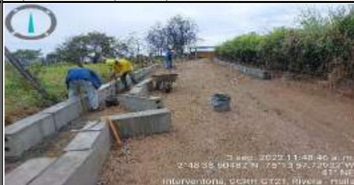
Descripción: Instalacion de bordillo - Sector ortiz
