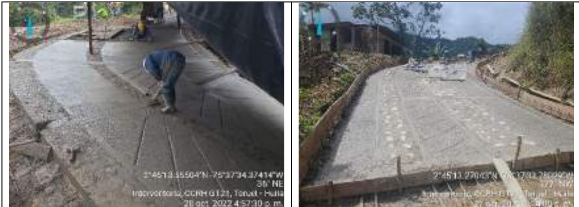
Ilustración 3. Tramo de vía construir mediante placa huella – El Paraíso – Tramo 1
