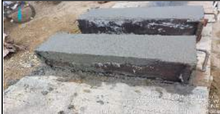
Descripción: Proceso de ensayos de testigos tipo viguetapara su posterior fallado.
