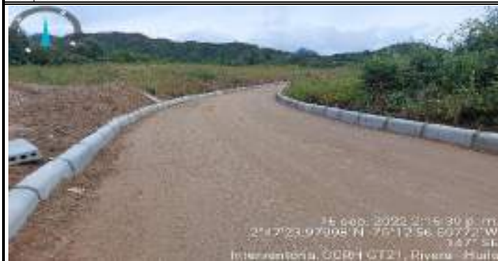
Descripción: Instalacion de bordillo.
