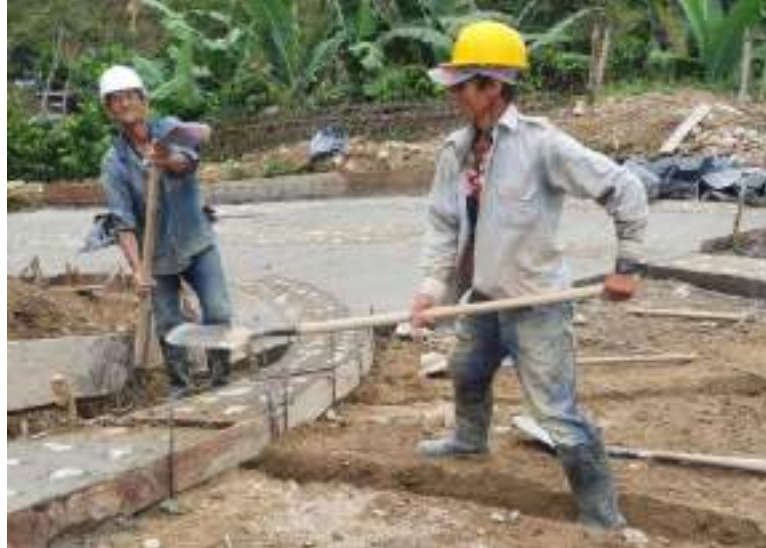
Ilustración 1. Excavación manual para cunetas, vigas riostras y bordillos.
