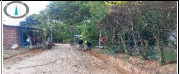
Descripción: Nivelacion de terreno para instalacion de bordillo - Sector ortiz
