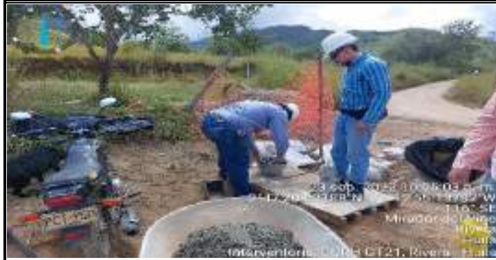
Descripción: Proceso de ensayos de asentamientos tipo cilindro.
