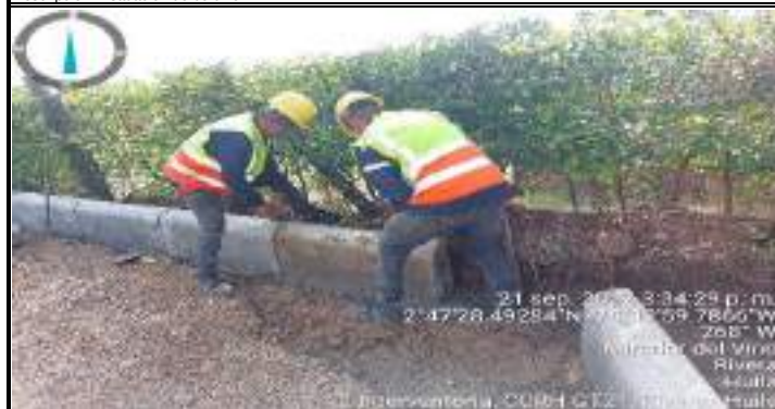
Descripción: Instalacion de bordillo.
