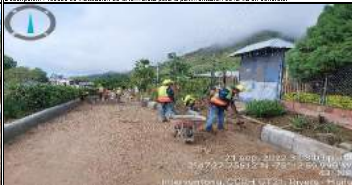
Descripción: Instalacion de bordillo.
