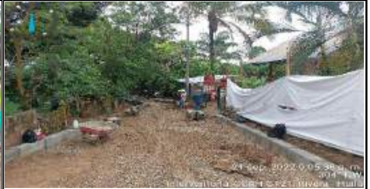
Descripción: Instalacion de bordillo - Sector ortiz
