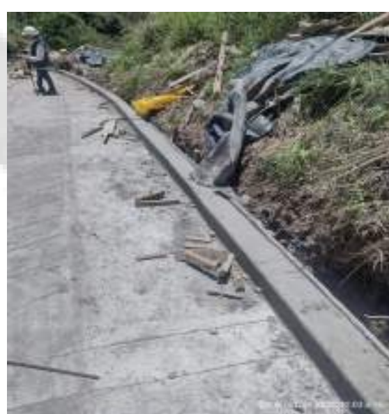
FUNDICION DE BORDILLOS EN CONCRETO CLASE "D"
