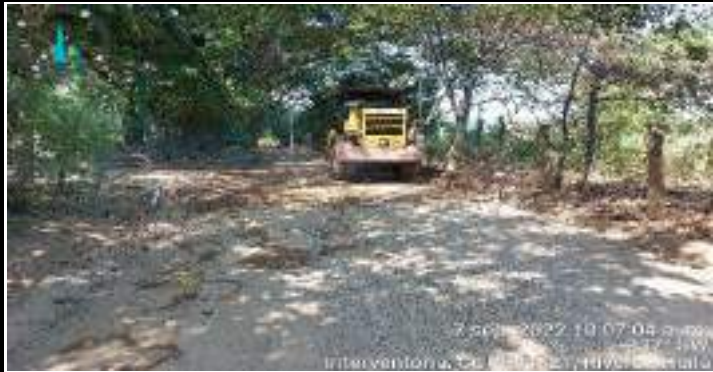
Descripción: Proceso de compactacion para la via - Sector ortiz
