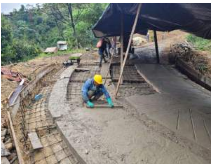
Ilustración 4. Fundición in situ de placa huella con concreto de 3000 psi.
