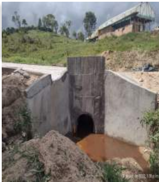
CONSTRUCCION OBRA TRANSVERSAL
