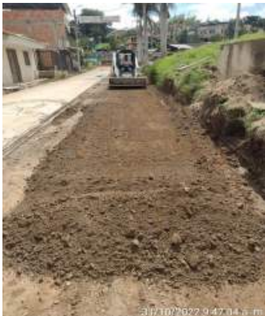
INSTALACION Y MEJORAMIENTO MECANICO DE SUB BASE GRANULAR - K 00+ K 0+040
