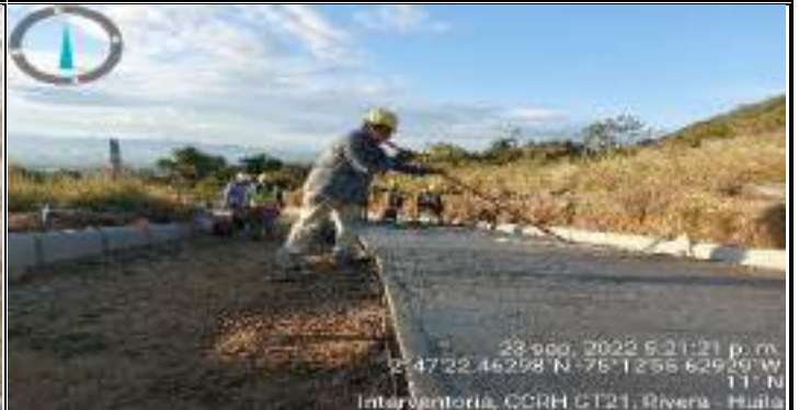
Descripción: Proceso de acabado con regla flota canal para la pavimentación de la vía.
