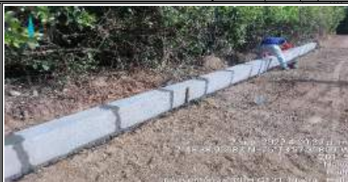
Descripción: Instalacion de bordillo - Sector ortiz
