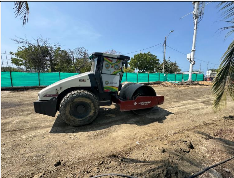
REGISTRO FOTOGRÁFICO EXCAVACION Y CONFORMACIÓN DE SUBRASANTE
