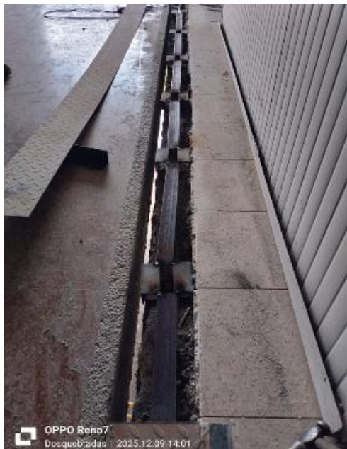
Reforzamiento junta de construcción con ángulo
