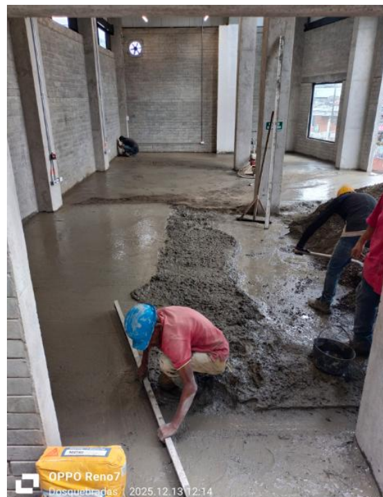
Fundición placa hangar en concreto C4000PSI
