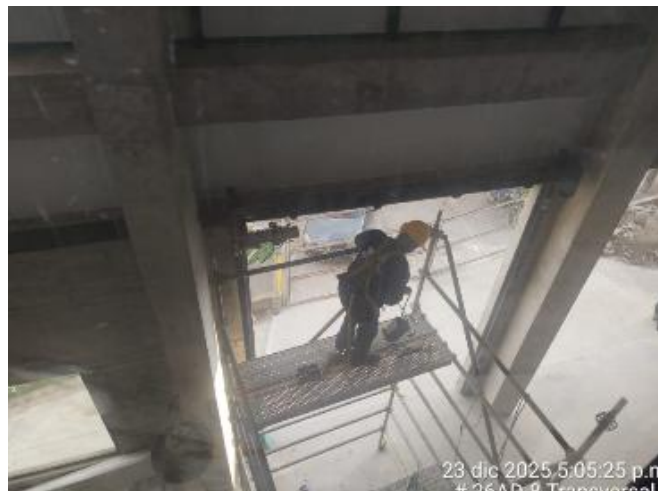
Montaje puertas mecanicas hangar
