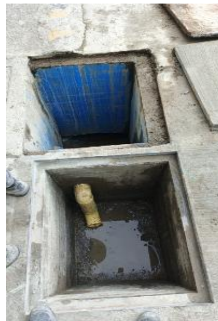
Resane y detalle trampa de grasas
