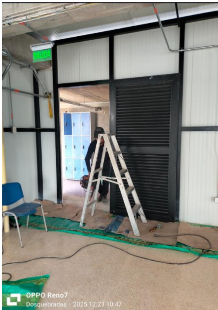
Instalación puertas metálicas aulas hangar
