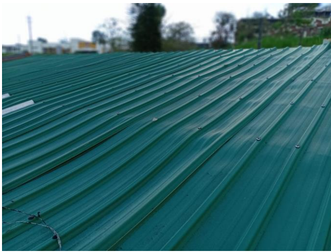
Foto 30 y 31: Cubierta área administrativa y laboratorio, ondulada, con deformaciones.
