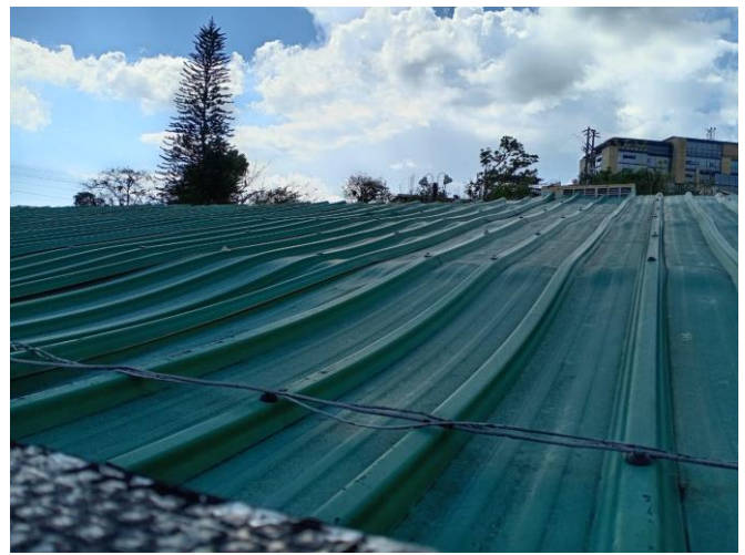
Foto 30 y 31: Cubierta área administrativa y laboratorio, ondulada, con deformaciones.
