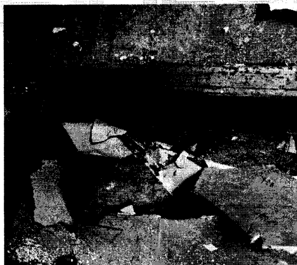
Imagen No 4 Desmonte de piso
