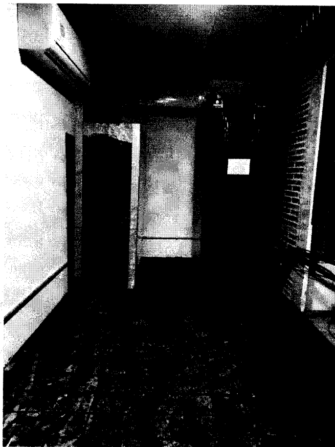
Imagen No 11 Instalacion de Aires acondicionados
