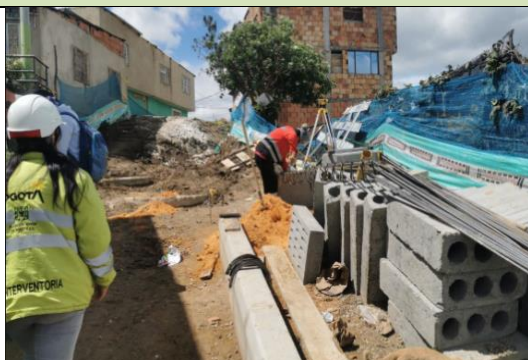
Fotografía N°9. Verificación de actividades en obra
