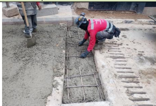
Fotografía N°12. Verificación de uso de dotación y EPP de trabajadores en frentes de obra
