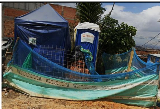
Fotografía N°7. Campamento y unidad sanitaria en frentes de obra.
