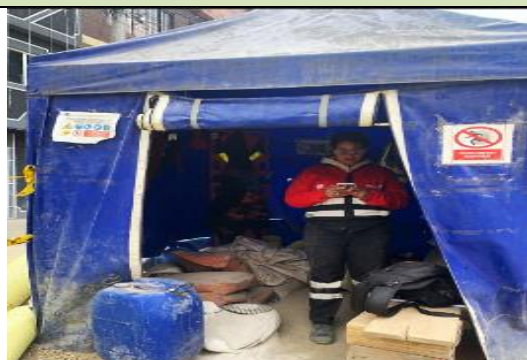
Fotografía N°10. Verificación de señalización en campamentos de frentes de obra
