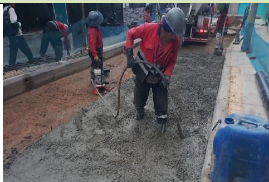
Fotografía N°11. Verificación de uso de EPP de trabajadores en actividades de fundida
