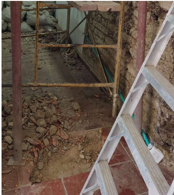
Demolición enchape cerámico.
