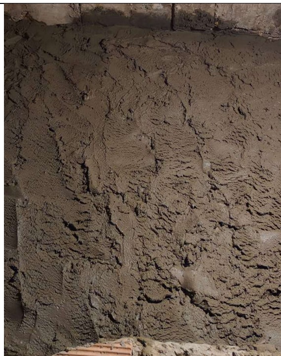
Pañete liso muros.
