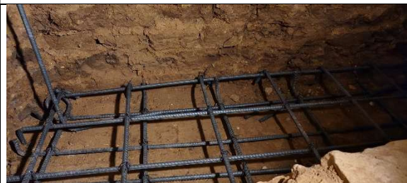
Acero de refuerzo.
