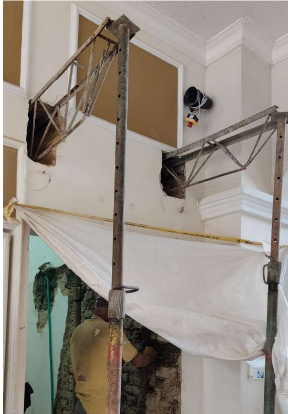
Demolición muro en adobe.
