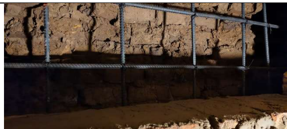
Acero de refuerzo.
