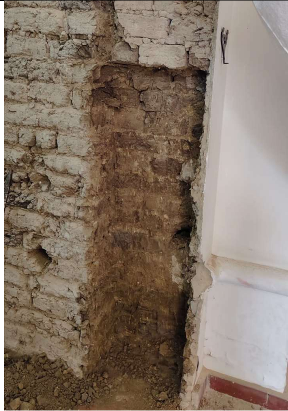
Demolición muro en adobe.
