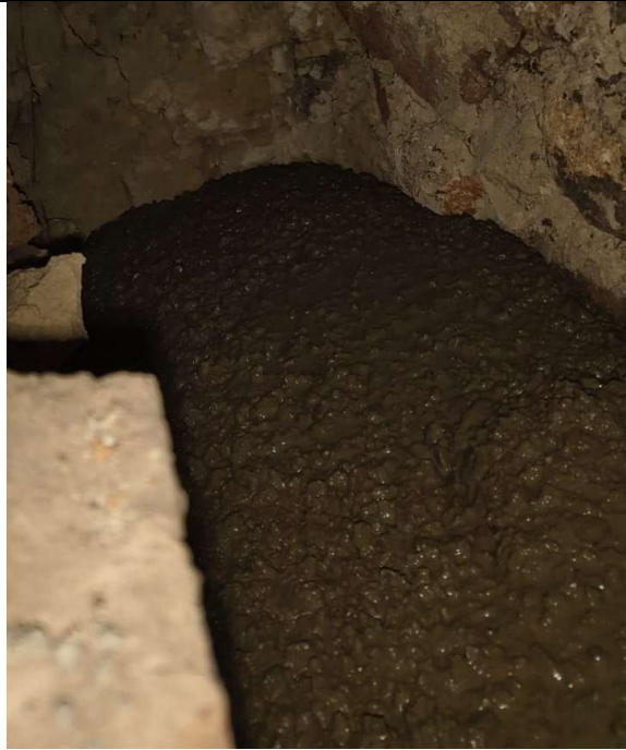
Concreto de zapatas.
