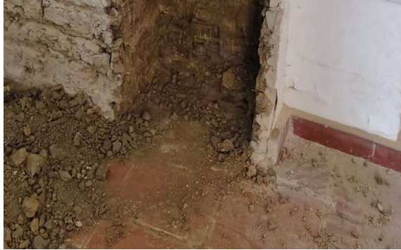
Demolición placas macizas
