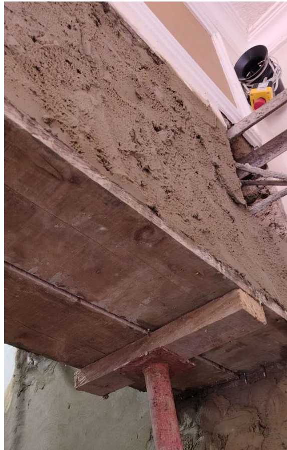
Concreto para viga de amarre.
