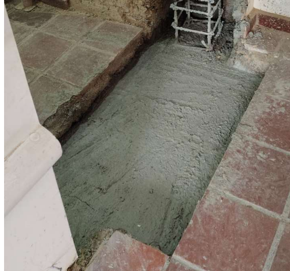
Demolición placas macizas.
