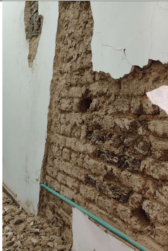
Demolición muro en adobe.
