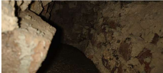
Concreto de zapatas.
