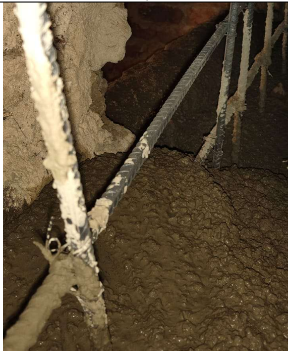
Muro de contención
