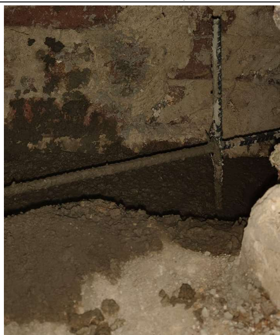
Muro de contención.
