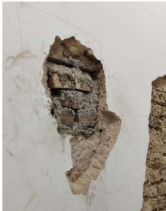
Muro ladrillo tolete.
