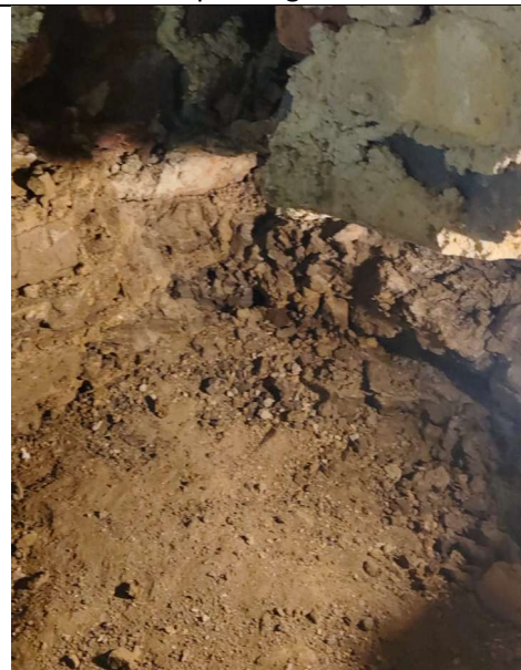
Relleno material compacto.
