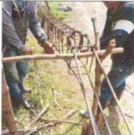
Colocación de acero de refuerzo
