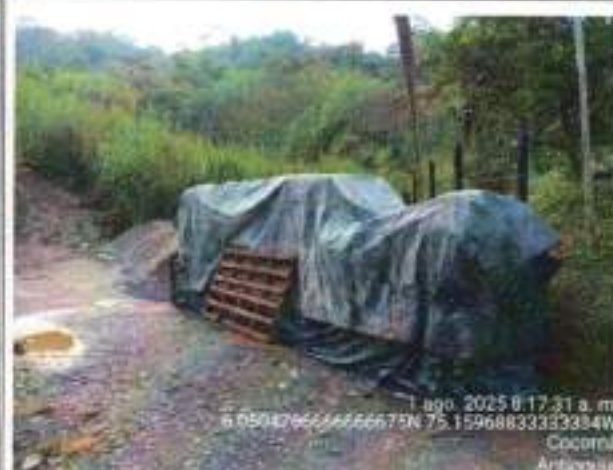
Foto No. 12: Almacenaje de materiales - cemento.
