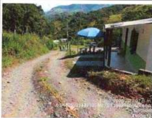
Foto No. 13: Toma de medidas para balance de obra.
