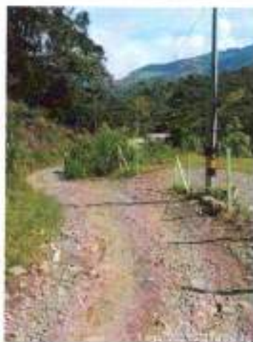
Foto No. 15: Toma de medidas para balance de obra.
