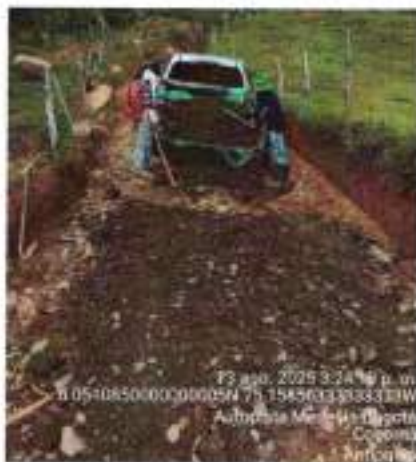
Foto No. 33: Conformación de vía y de cunetas.
