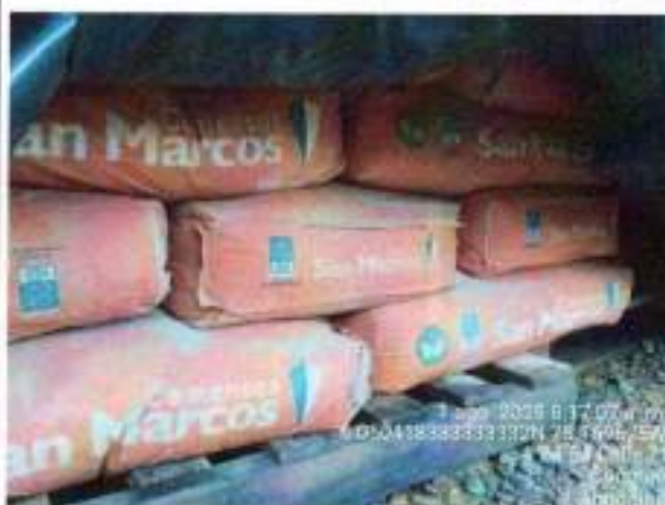
Foto No. 11: Acopio de materiales Cemento.
