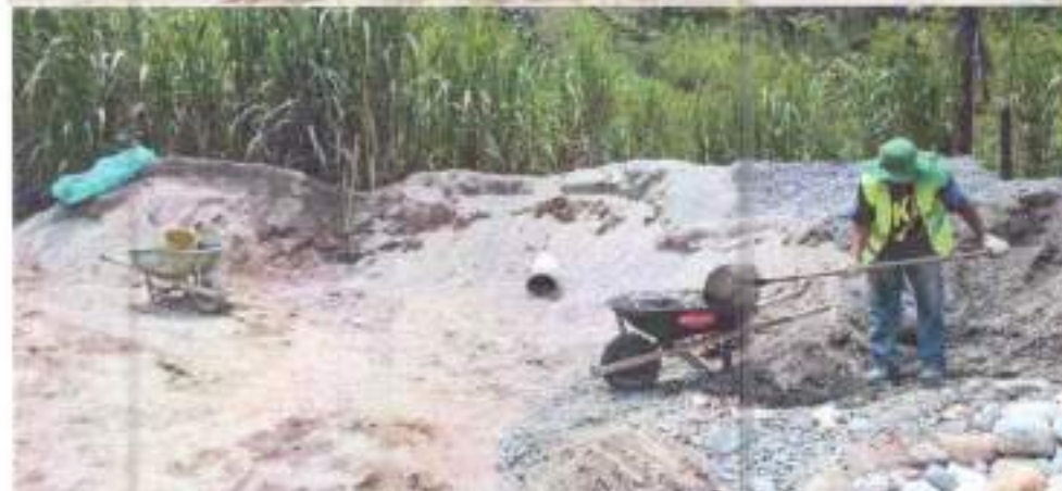
Conformación manual de vías y cunetas
