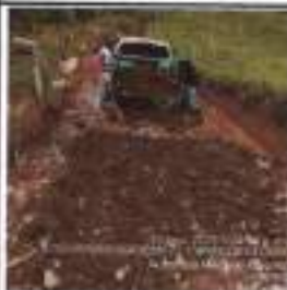
Descripción: Conformación de vía y de cunetas.
