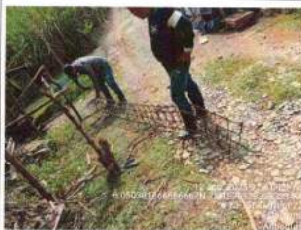
Foto No. 28: figuración de acero de refuerzo - vigas Rlostras.
