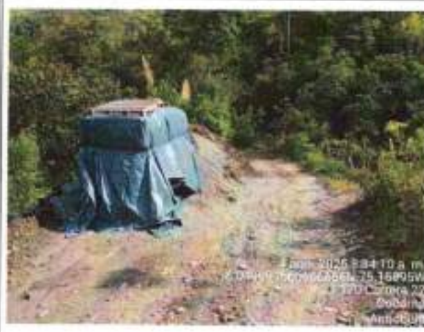
Foto No. 16: Acopio de materiales granulares y cemento para los diferentes puntos.
