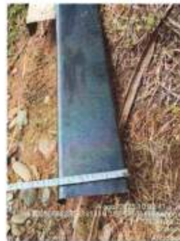
Foto No. 18: Revisión de formaletas metálicas, espesores mínimos.
