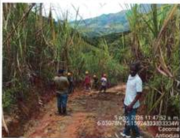
Foto No. 21: Conformación de vía y cunetas.
