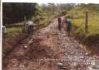
Descripción: Conformación de vía y de cunetas.
