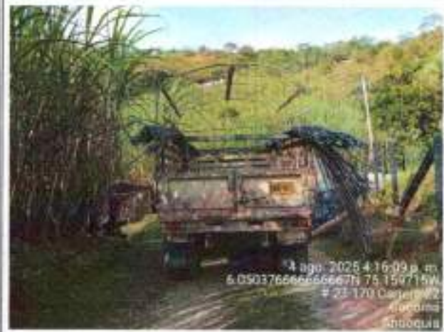
Foto No. 20: Llegada de acero de refuerzo.
