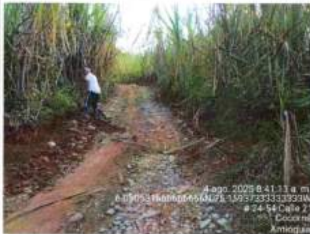
Foto No. 17: Conformación manual de cunetas.
