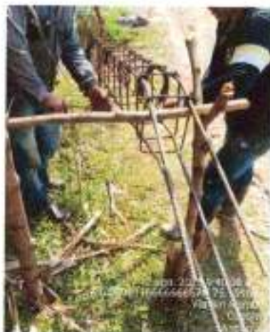
Foto No. 27: figuración de acero de refuerzo - vigas Rlostras.
