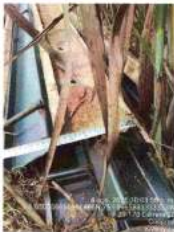
Foto No. 19: Revisión de formaletas metálicas, espesores mínimos.
