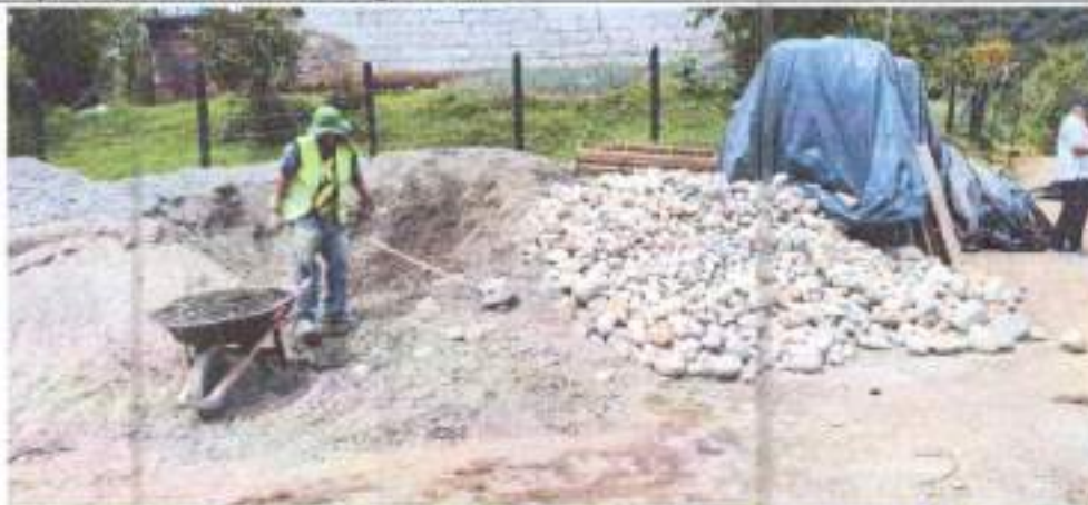
Ingreso y acopio de materiales granulares
