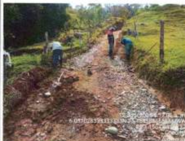
Foto No. 34: Conformación de vía y de cunetas.
