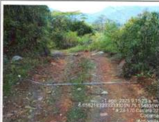
Foto No. 14: Toma de medidas para balance de obra.
