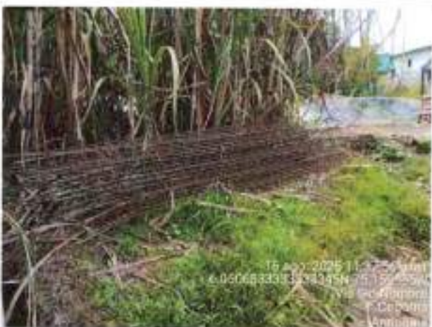
Foto No. 25: figuración de acero de refuerzo - vigas Rlostras.
