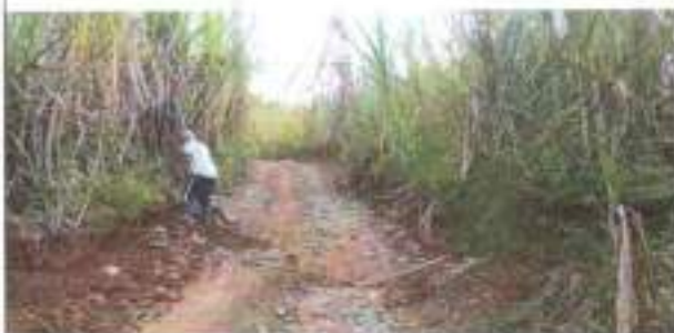
Conformación manual de vías y cunetas
