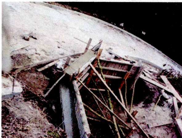
Concreto para placa huella de 21 mpa - (3000 psi). (incluye corte y sello de juntas).
