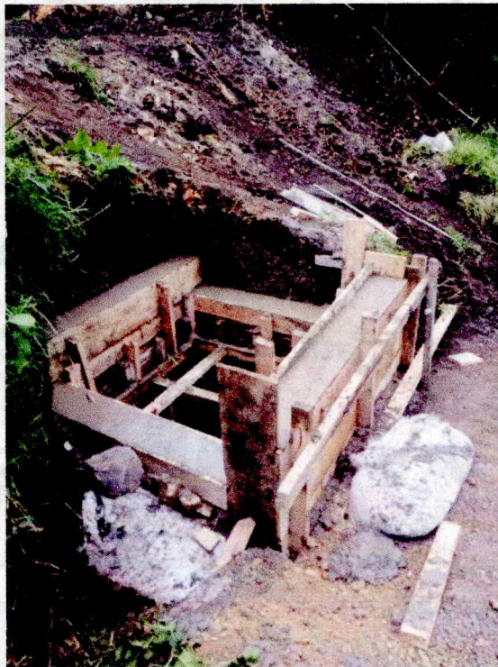
Construcción Alcantarilla
