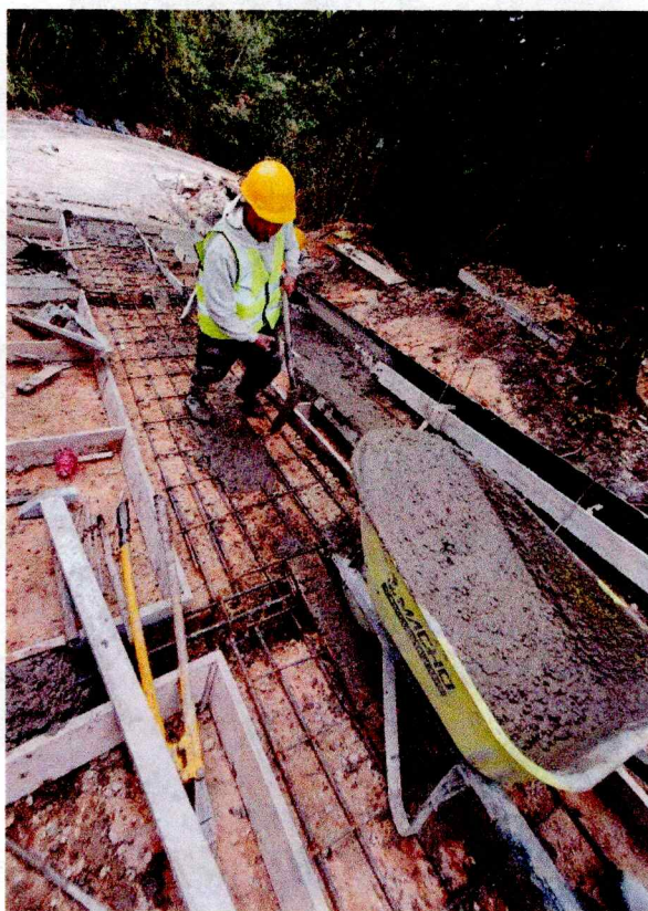
Concreto para placa huella de 21 mpa - (3000 psi). (incluye corte y sello de juntas).
