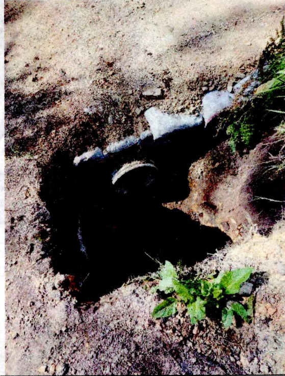
Instalación de tubería de 24”
