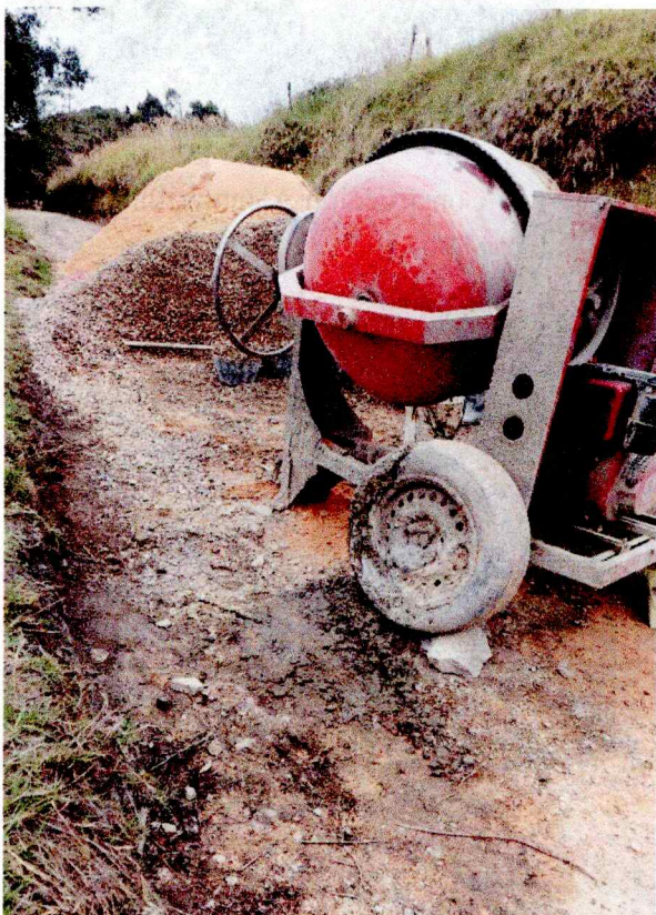
Concreto para placa huella de 21 mpa - (3000 psi). (incluye corte y sello de juntas).
