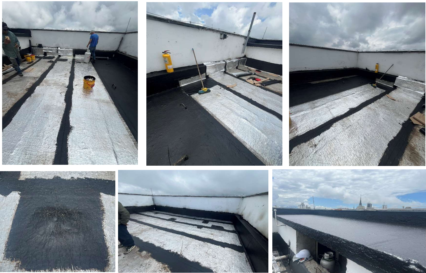
REPARACION EN UNIDADES SANITARIAS - BAÑOS EDIFICIO DIRECCION SECCIONAL Y TORRE JUZGADOS PENALES
