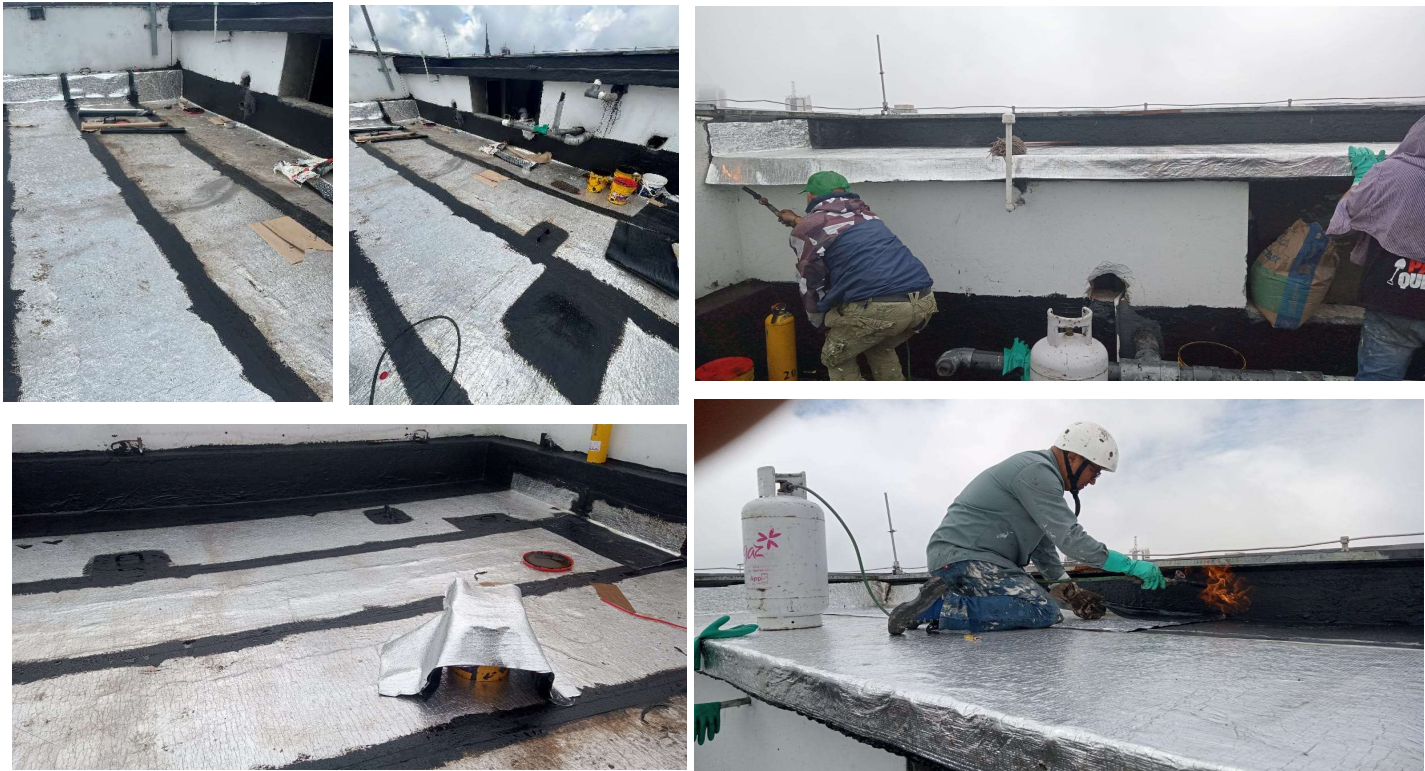
5- Aplicación de emulsión asfáltica para protección de manto asfáltico
