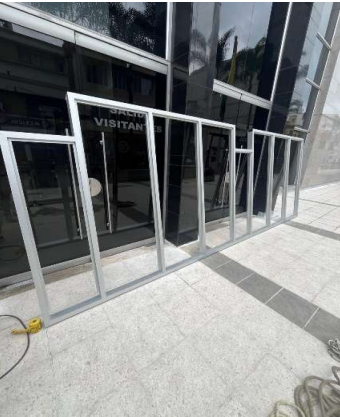
Suministro e instalación de pergóla para la entrada principal del palacio de justicia con el fin de evitar el ingreso de aguas lluvias hacia el interior del edificio
