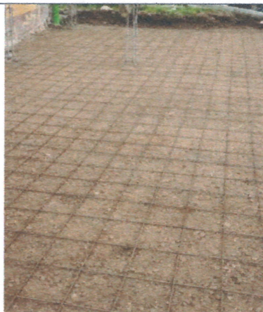
Material de afirmado y malla electrosoldada
