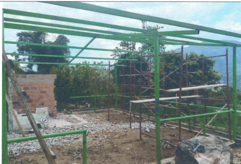
Suministro, instalación y pintura de perfiles metálicos, tubería redonda de 2" y 3"
