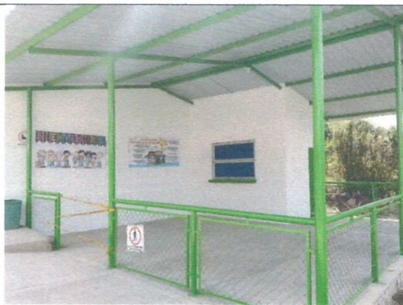
Placa en concreto y cerramiento en malla eslabonada.
