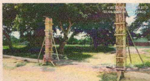
Fotografía 13. Columna 30*30 Portón Eje B
