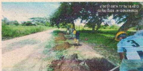
Fotografía 3. Excavación zapatas Eje B
