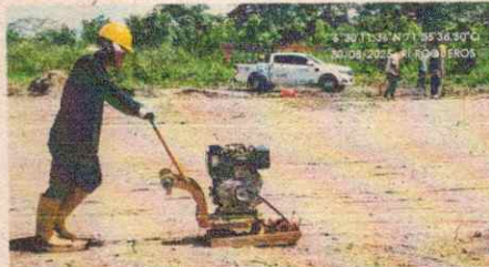
Fotografía 42. Relleno con sub base cancha múltiple
