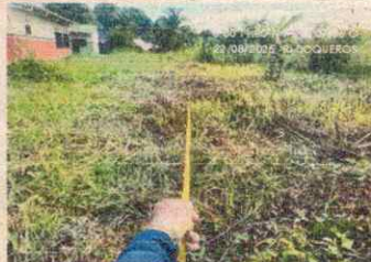
Fotografía 44. Descapote y nivelación cancha Múltiple
