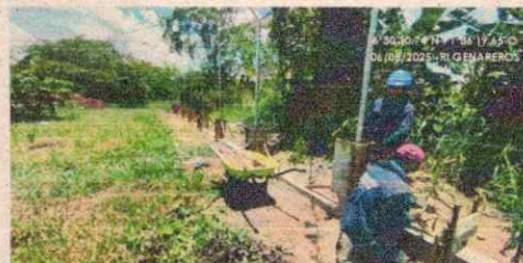
Fotografía 10. Columneta 20x20 Eje 1
