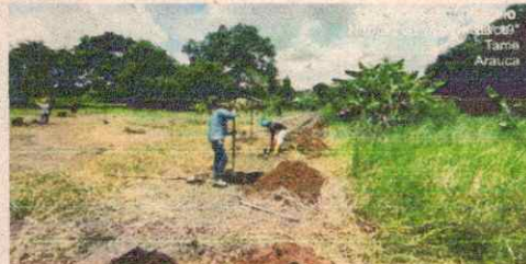
Fotografía 4. Excavación zapatas Eje 1
