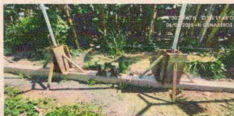
Fotografía 9. Columneta 20x20 Eje 1
