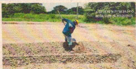
Fotografía 41. Relleno con sub base cancha múltiple
