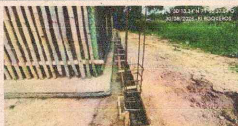
Fotografía 31. Viga de cimentación Eje 2
