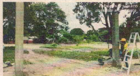
Fotografía 14. Columna 30*30 Portón Eje B
