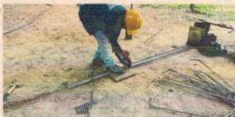
Fotografía 11. Acero de Refuerzo vigas de cimentación Eje 1
