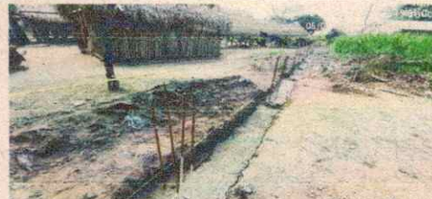
Fotografía 6. Solado viga de cimentación Eje 1
