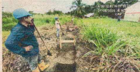
Fotografía 28. Excavación Manual zapatas Eje A
