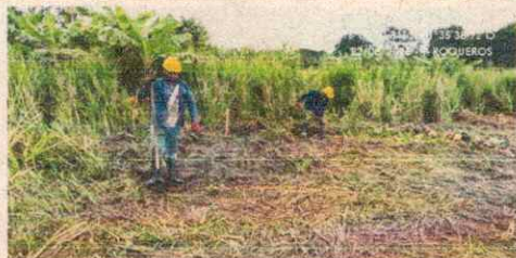
Fotografía 43. Descapote y nivelación cancha Múltiple
