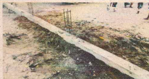
Fotografía 8. Viga de cimentación Eje 1
