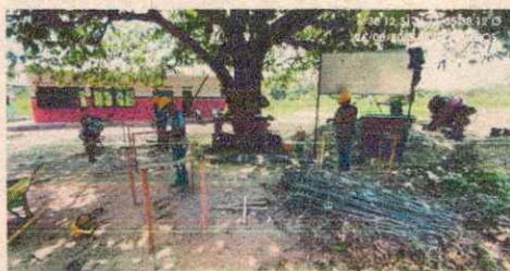
Fotografía 35. Acero de Refuerzo Columnetas Eje A
