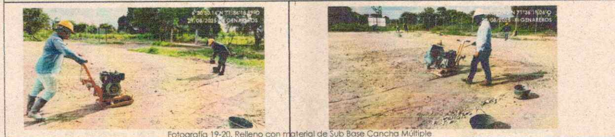
Fotografía 19-20. Relleno con material de Sub Base Cancha Múltiple
