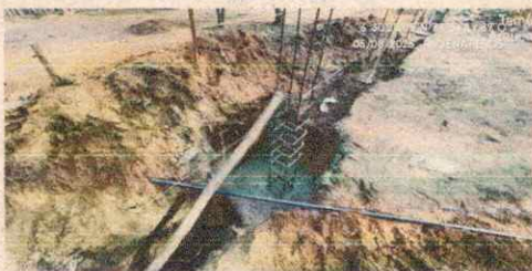
Fotografía 15. Zapata en concreto Portón Eje 1
