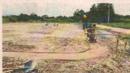
Fotografía 45-46 Relleno y compactación Material 4" zona de Cancha Múltiple.
