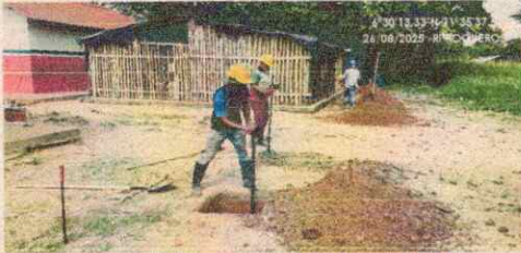
Fotografía 27. Excavación Manual zapatas Eje 2
