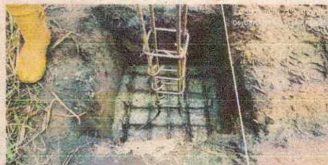
Fotografía 12. Acero de Refuerzo zapatas Eje 1
