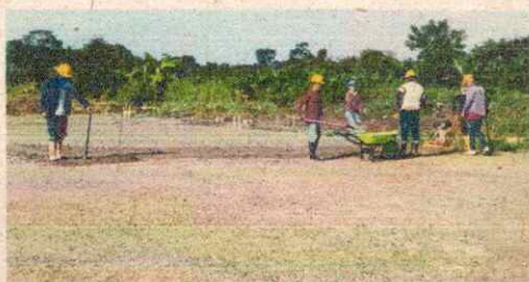
Fotografía 45-46 Relleno y compactación Material 4" zona de Cancha Múltiple.
