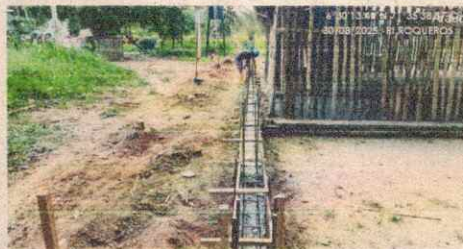
Fotografía 36. Acero de Refuerzo Columnetas Eje 2
