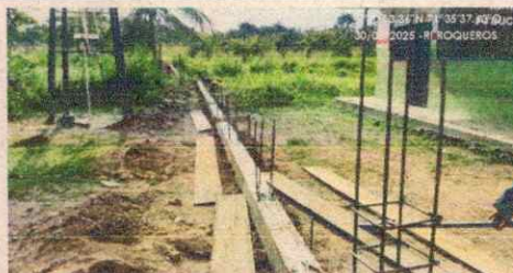
Fotografía 32. Viga de cimentación Eje 2
