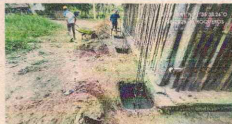
Fotografía 38. Zapatas en concreto eje 2
