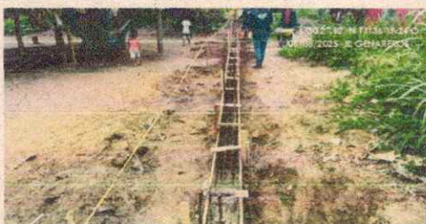
Fotografía 7. Viga de cimentación Eje A
