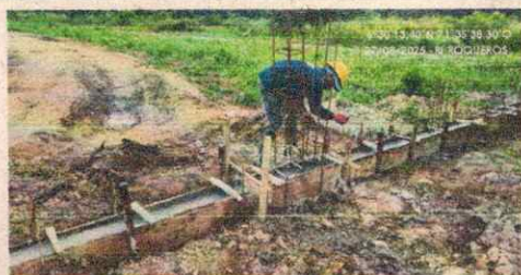
Fotografía 33. Columneta 20*20 Eje 2
