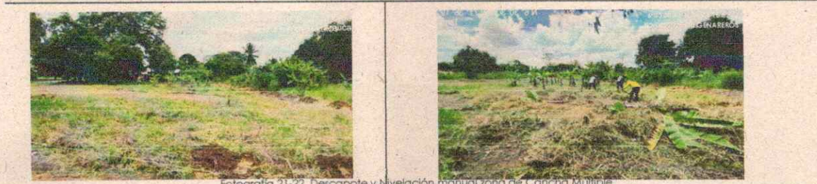
Fotografía 21-22. Descapote y Nivelación manual zona de Cancha Múltiple
