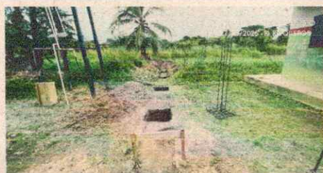
Fotografía 37. Zapatas en concreto eje 2
