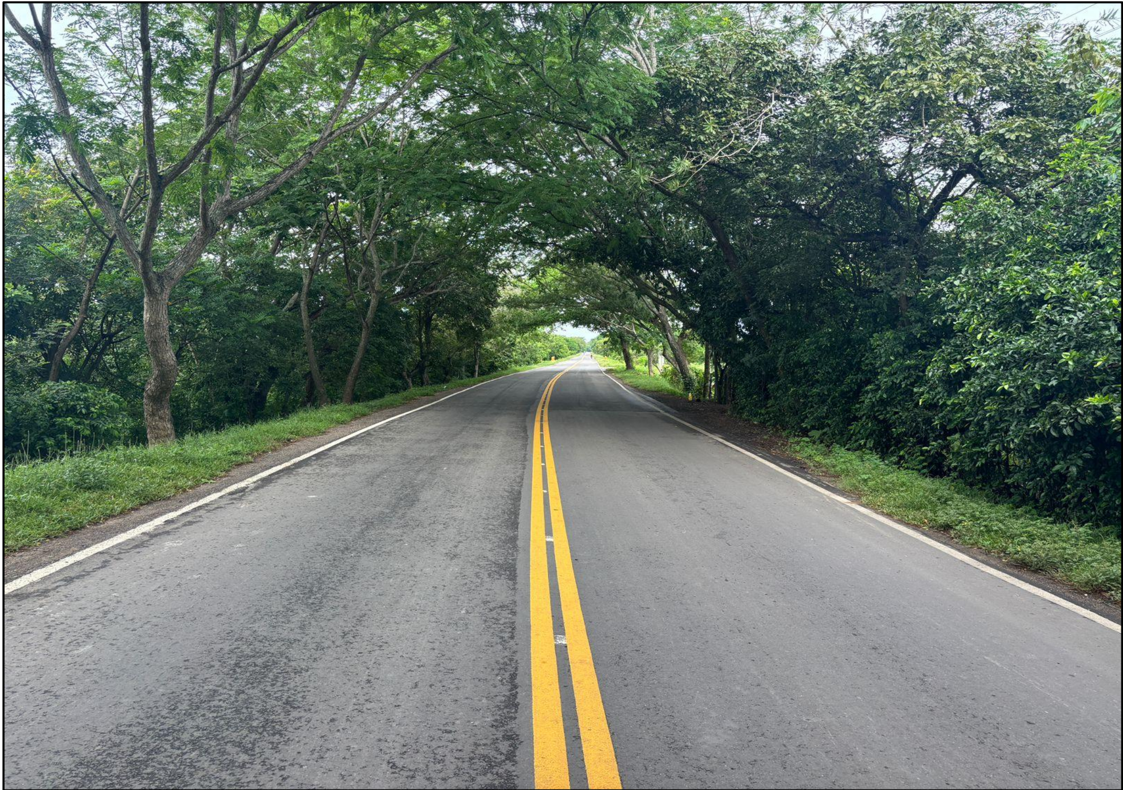
SENTIDO DE LA VÍA: EL BANCO - GUAMAL
