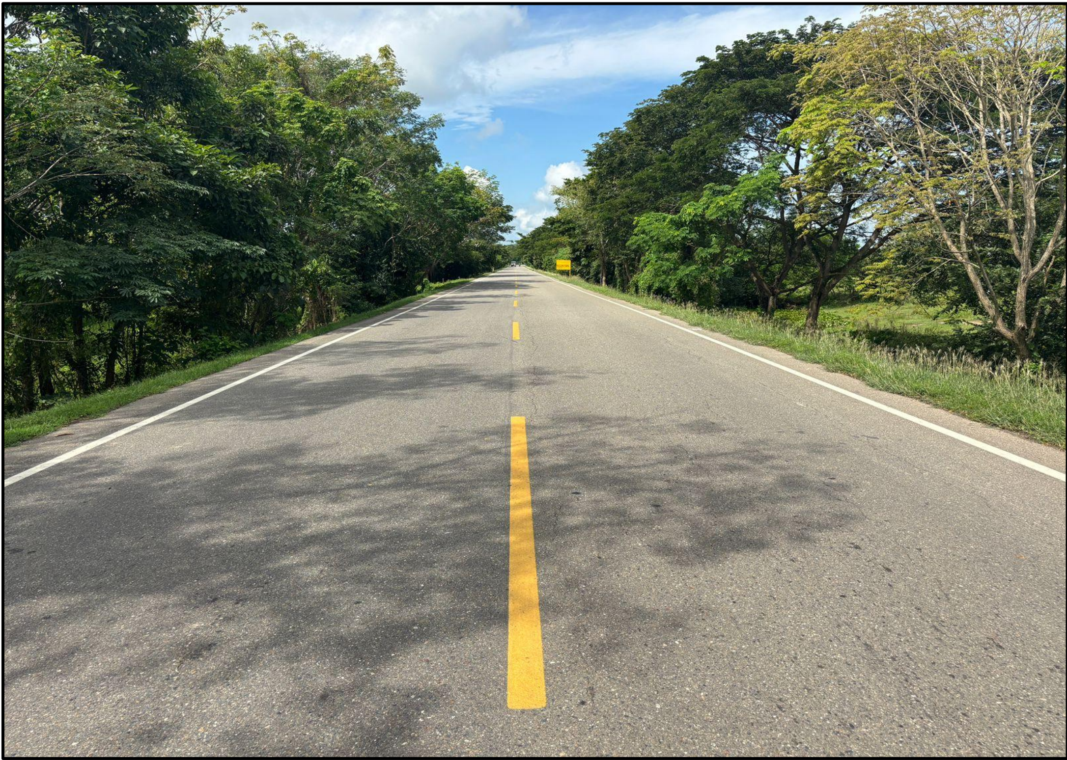
SENTIDO DE LA VÍA: EL BANCO - GUAMAL
