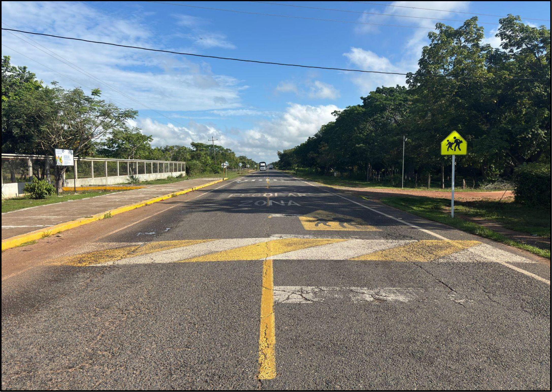
SENTIDO DE LA VÍA: EL BANCO - SAN JOSÉ
