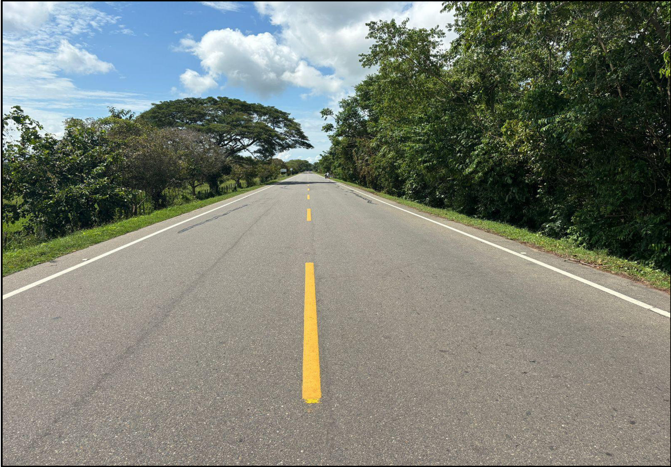
SENTIDO DE LA VÍA: EL BANCO - GUAMAL
