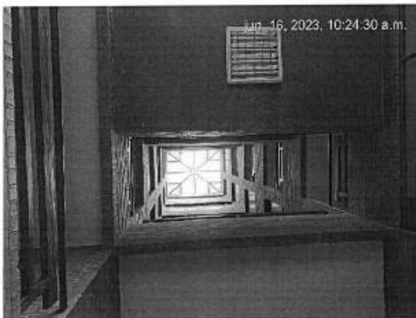
Ilustración No. 029 Sistema de iluminación en lámparas de tubo.
