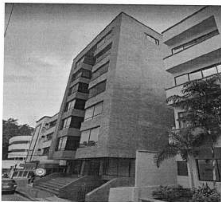
Ilustración No. 001 Sincelejo, Sucre. Fachada Principal
