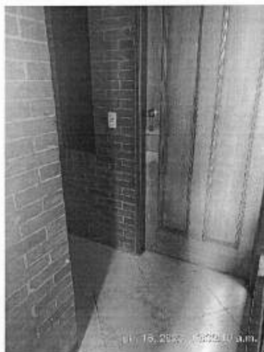
Ilustración No. 006 Entrada a oficinas y pasillos.
