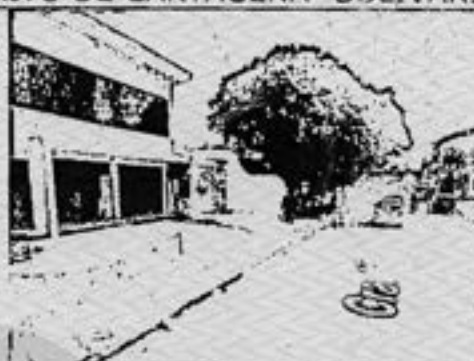
Detalles generales del Edificio T17
