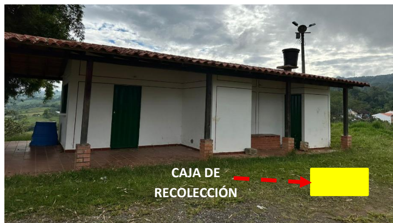
Registro Fotográfico Punto de Alcantarillado Disponible
