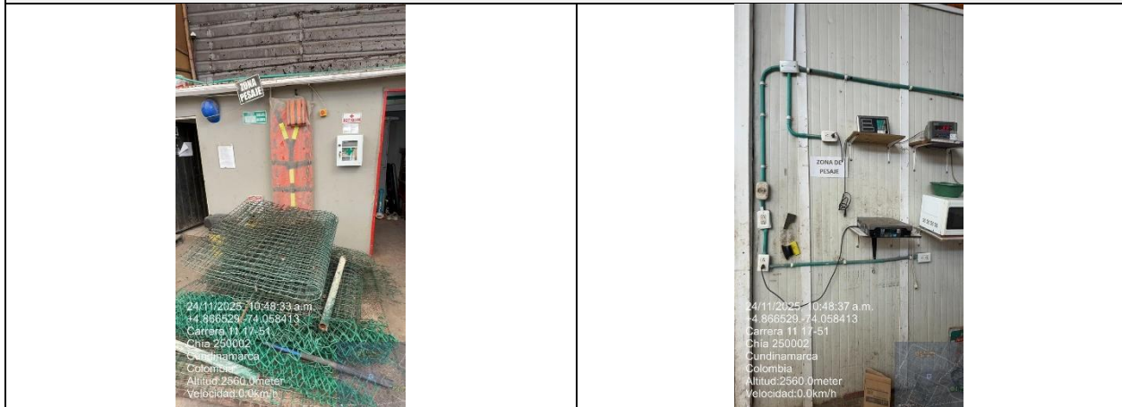
Iluminación y ventilación de la ECA.
