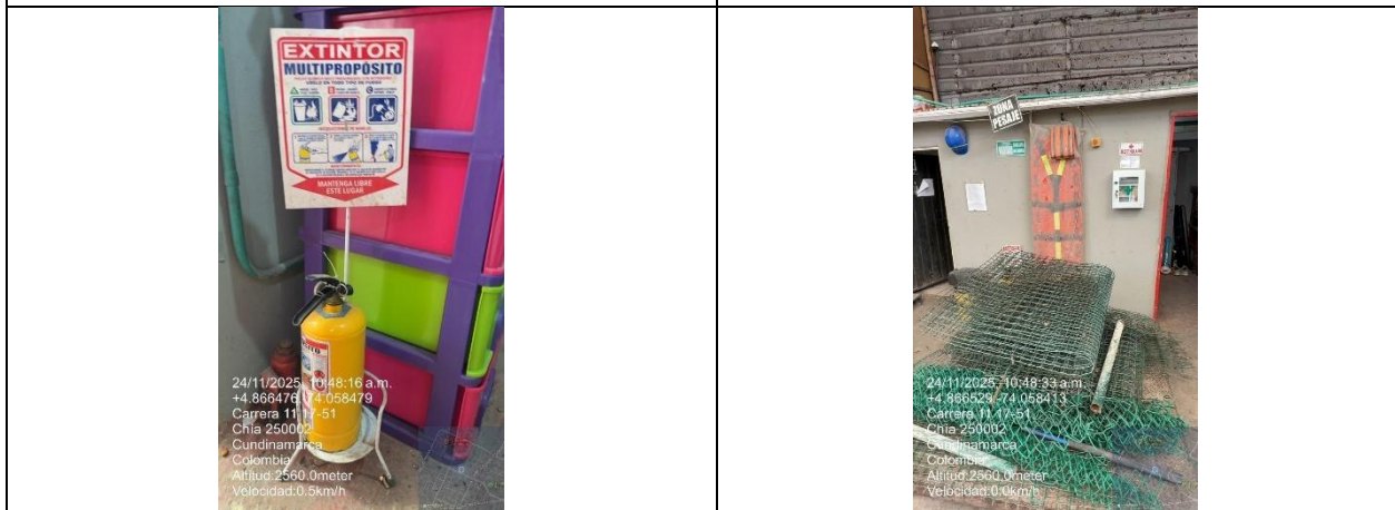
Extintor ubicado en la zona de pesaje.
