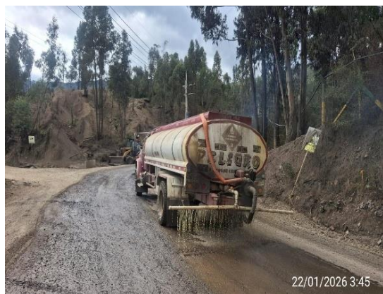
Fotografía 31. Riego de la vía por parte del contratista, mediante carro tanque.
