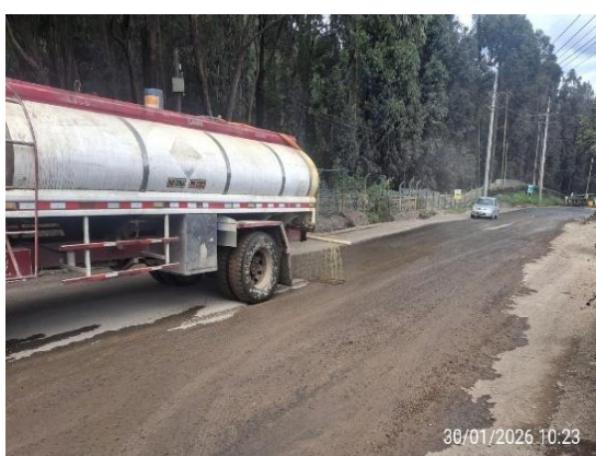
Fotografía 32. Riego de la vía por parte del contratista, mediante carro tanque.
