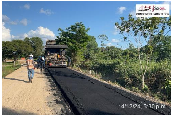
Figura 3. 14/12/2024. Imprimación y Aplicación de MDC-19, k4+840-k5+600 (Carril derecho) y k4+848 - k5+382 (carril izquierdo).
