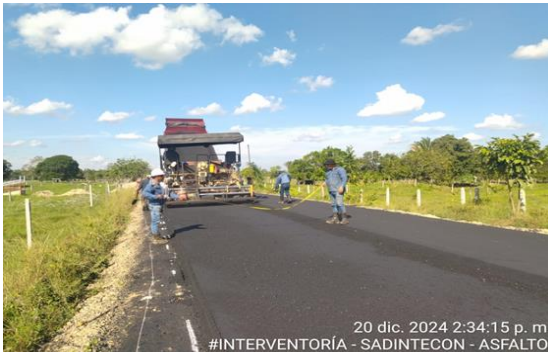
Figura 5. 20/12/2024. Imprimación y Aplicación de MDC-19, k5+382 - K5+656 (carril izquierdo).
