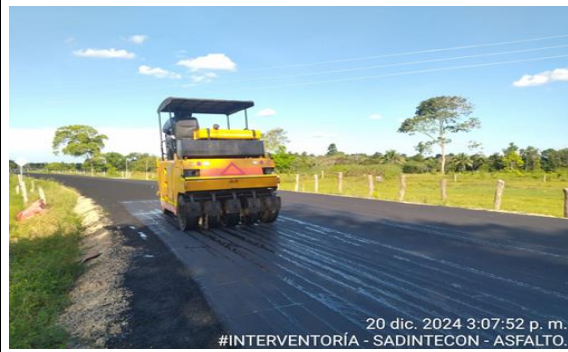
Figura 6. 20/12/2024 Imprimación y Aplicación de MDC-19, k5+382 - K5+656 (carril izquierdo).
