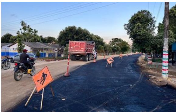
Figura 3. 12/12/2024. Riego de imprimación con emulsión asfáltica crl-57 (anteriormente crl-1) k0+000 - k0+180 Carril derecho e izquierdo.
