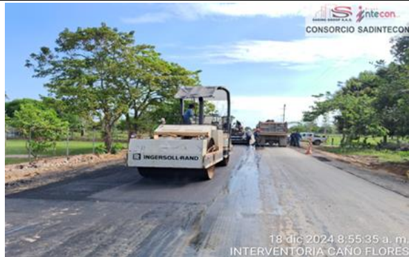
Figura 4. 18/12/2024. Mezcla densa en caliente tipo mdc-19 - compra de mezcla k0+000 - k0+180 Carril derecho e izquierdo.
