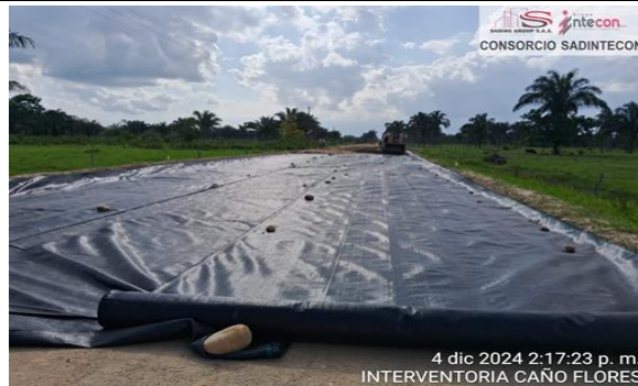
Figura 1. 4/12/2024 Instalación de Geotextil y Conformación de capa estabilizada con sales inorgánicas (k0+820-K1+230) Carril derecho y (k0+535-K1+220) Carril Izquierdo.
