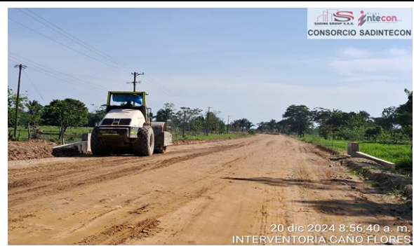
Figura 6. 20/12/2024. Instalación de Geotextil y Conformación de capa estabilizada con sales inorgánicas (k1+600-K1+985) Carril derecho e izquierdo y (k2+845-K3+015) Carril derecho e Izquierdo.
