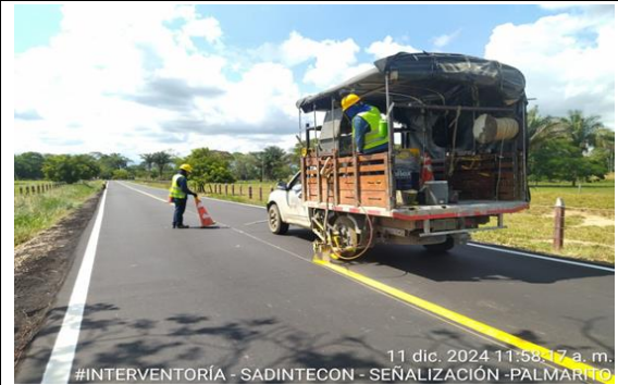
Figura 2. 11/12/2024. Demarcación horizontal k0+100 hasta k4+040.
