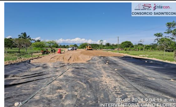
Figura 5. 20/12/2024. Instalación de Geotextil y Conformación de capa estabilizada con sales inorgánicas (k1+600-K1+985) Carril derecho e izquierdo y (k2+845-K3+015) Carril derecho e Izquierdo.
