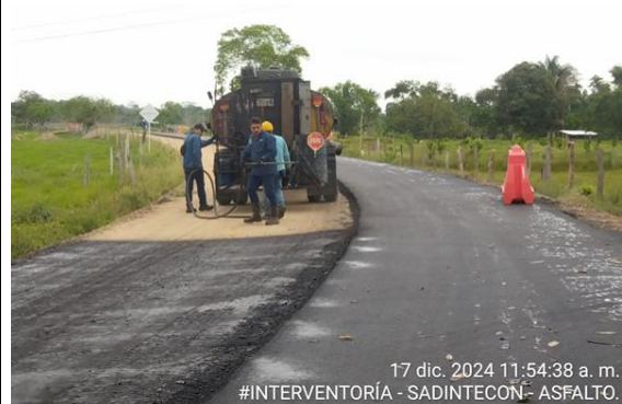
Figura 4. 17/12/2024. Imprimación y Aplicación de MDC-19, k4+840-k5+600 (Carril derecho) y k4+848 - k5+382 (carril izquierdo).
