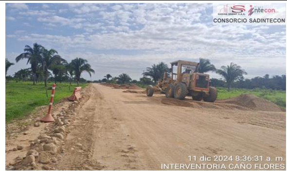
Figura 2. 11/12/2024 Instalación de Geotextil y Conformación de capa estabilizada con sales inorgánicas (K1+220 - k1+600) Carril derecho e Izquierdo.
