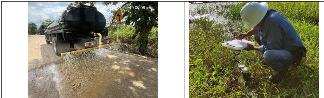
Humectación en obra y captación de aguas.
