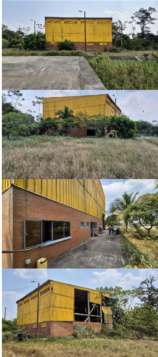
Fotografía No. 4. Exteriores del área de bodega del muelle
