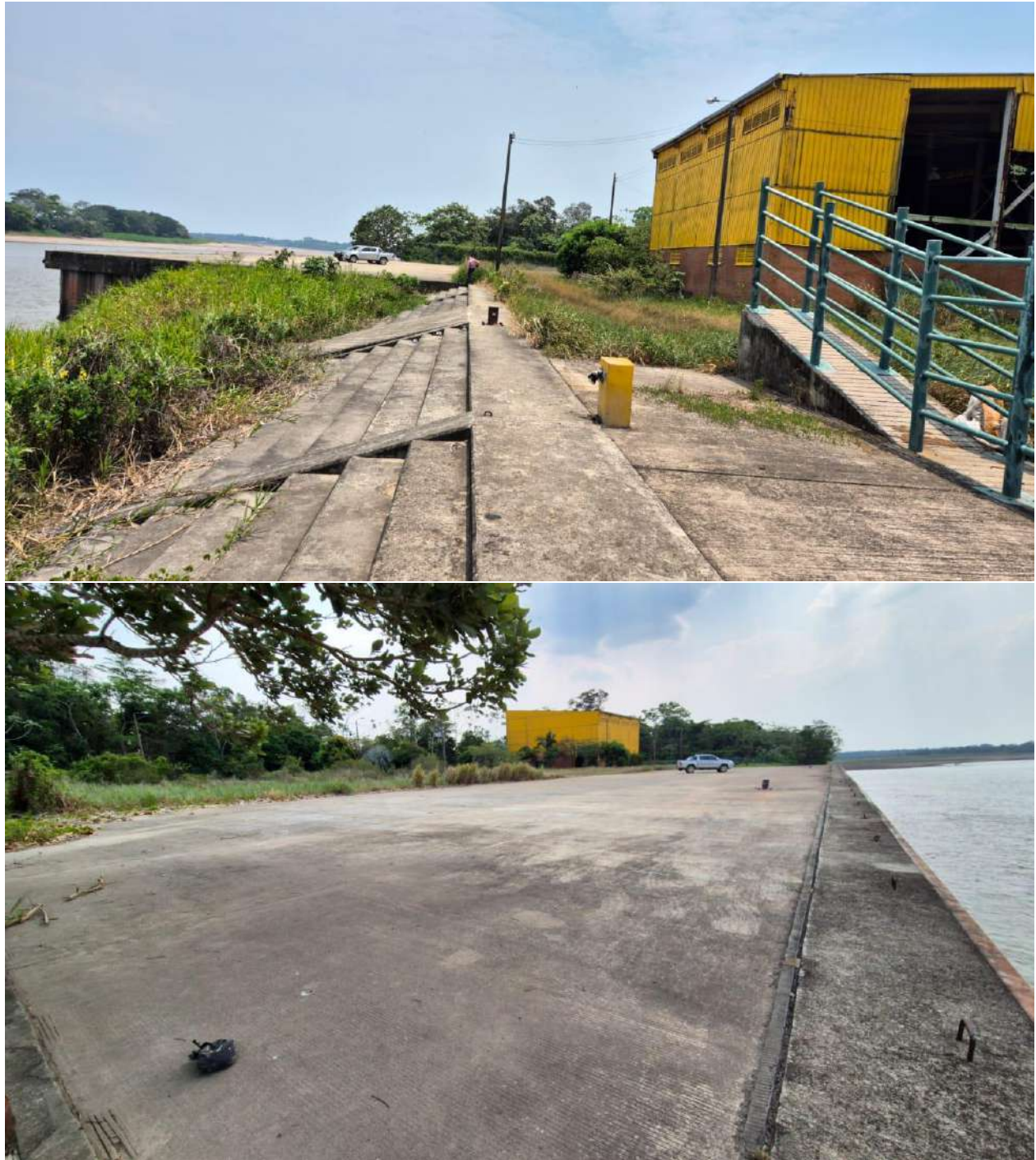
Fotografía No. 2. Vista General del Muelle La Banqueta – 5 de Marzo de 2024
