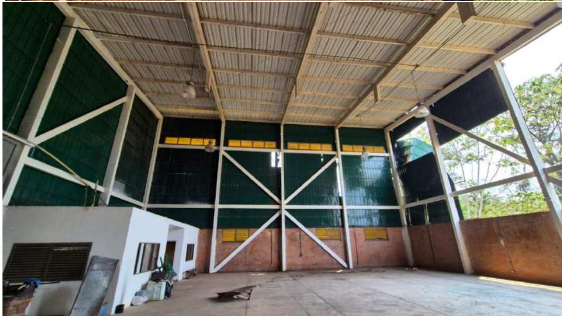
Fotografía No. 7. Estado general de la bodega del muelle
