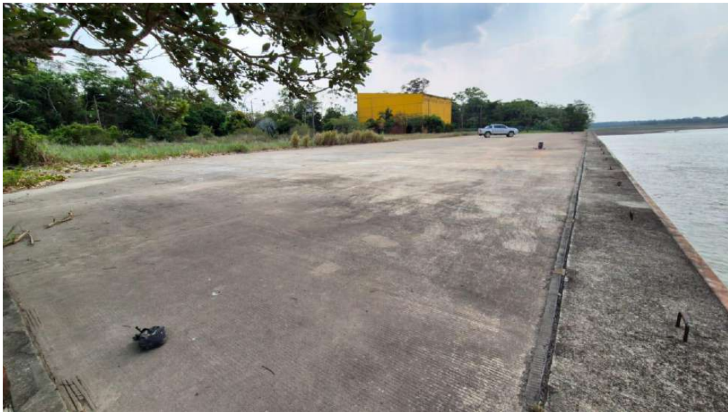
Fotografía No. 5. Infraestructura del muelle de carga. En concreto en buen estado, con amplia zona de descargue.
