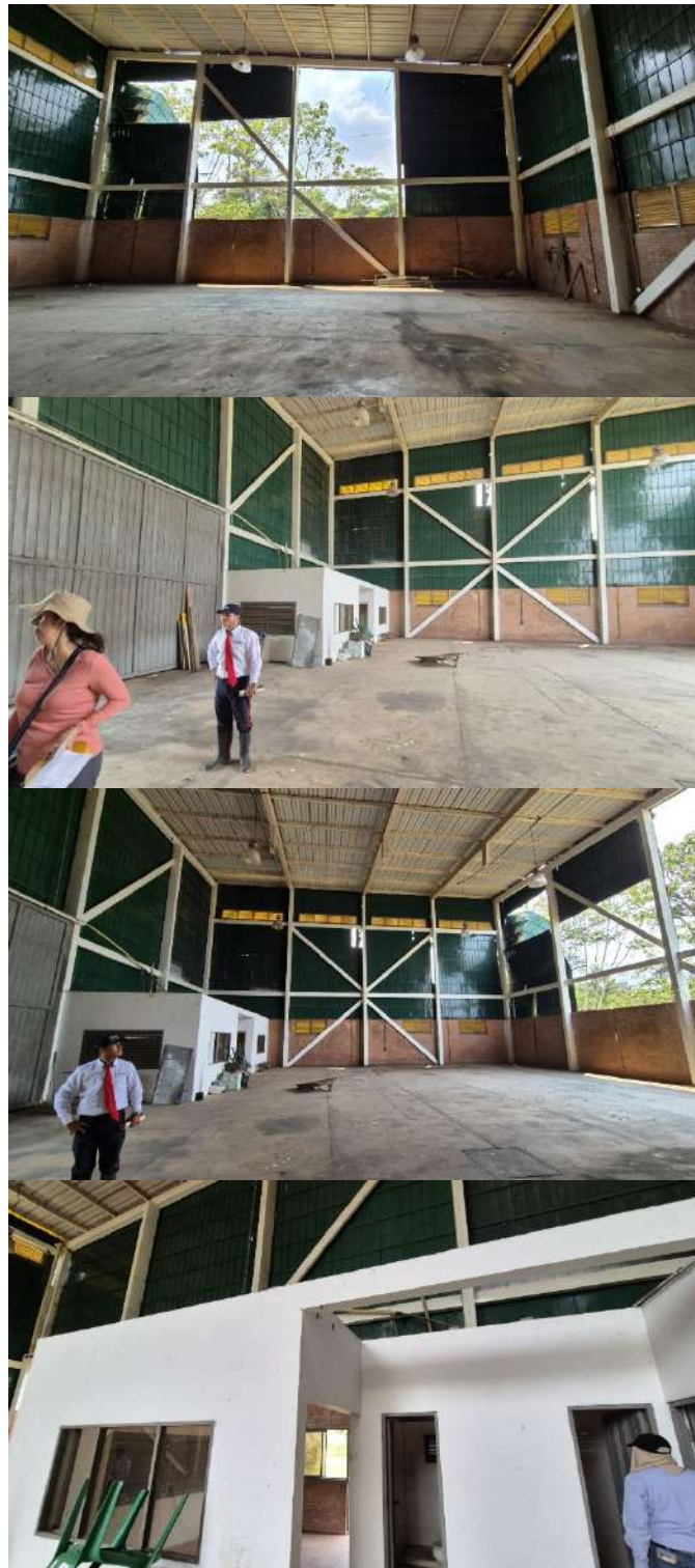
Fotografía No. 5. Interior del área de Bodega del muelle
