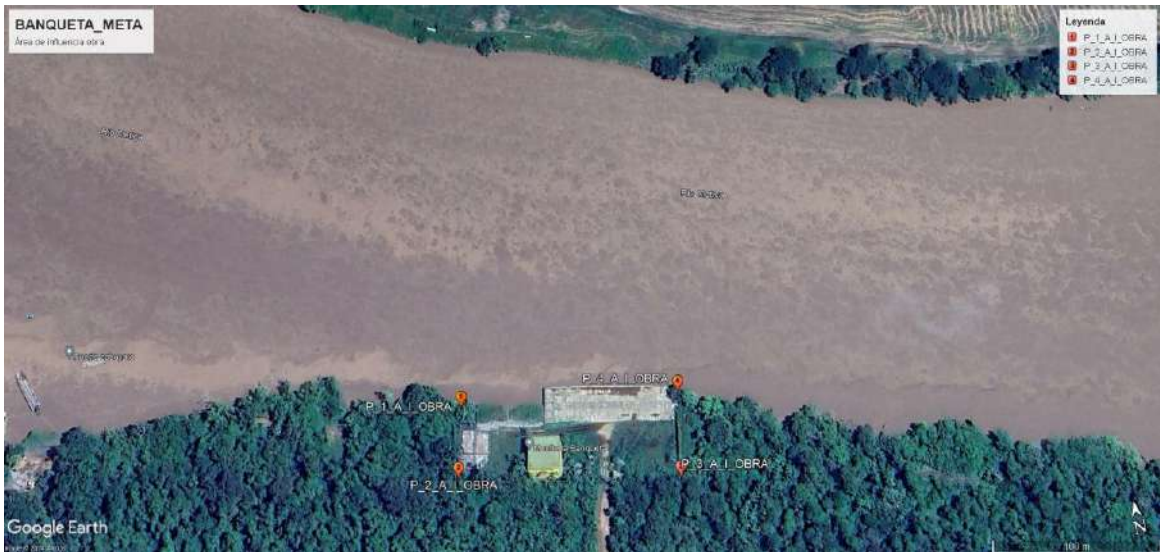
Imagen 1. Intervención Muelle la Banqueta
