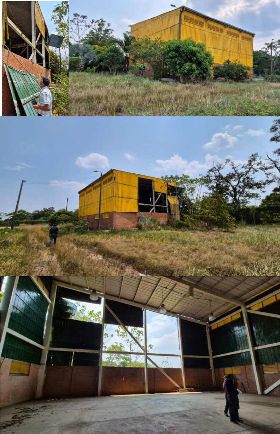
Fotografía No. 6. Estado general de la bodega del Muelle
