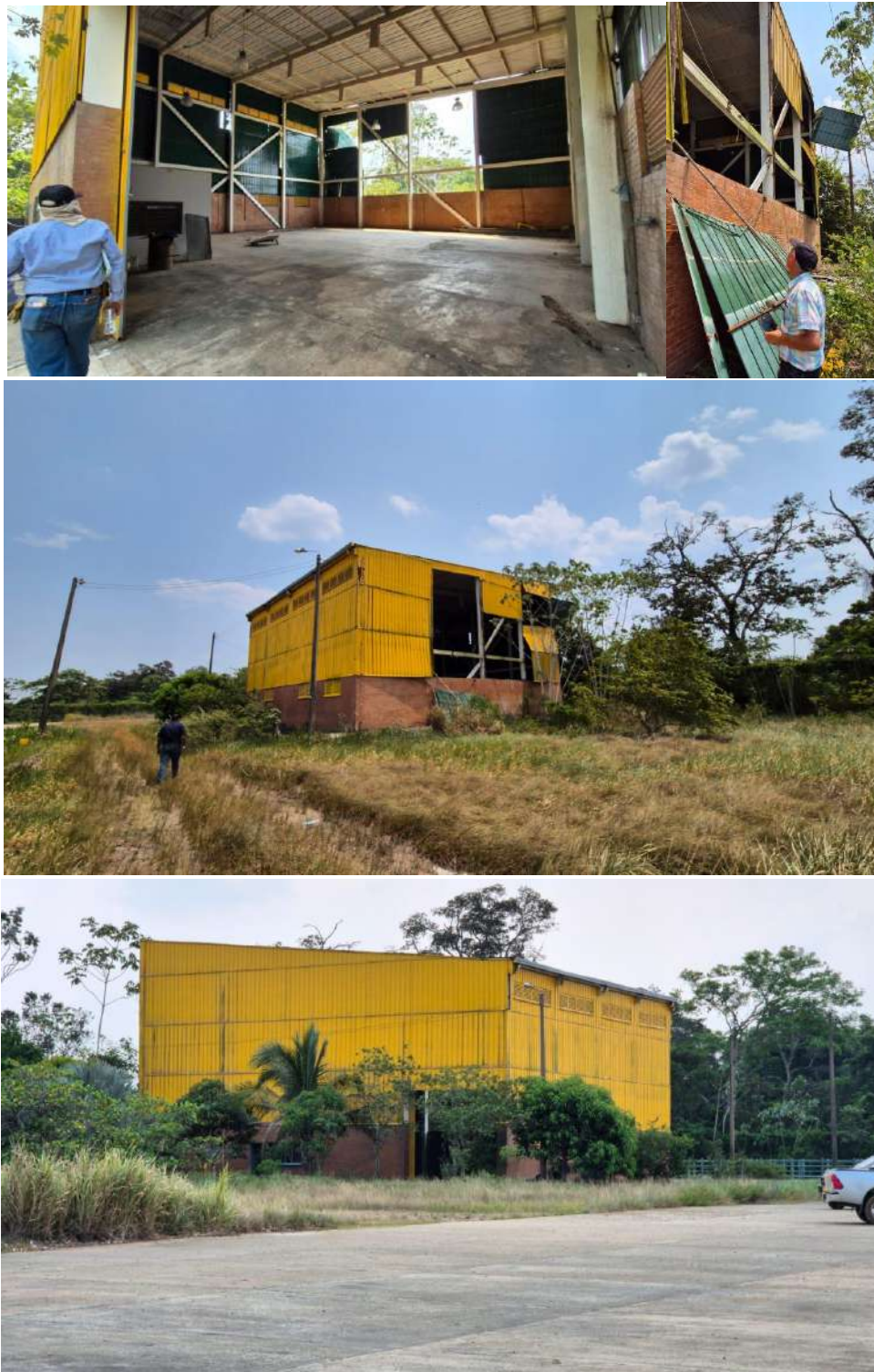
Fotografía No. 1. Estado General de la Bodega del muelle La Banqueta - 5 de marzo de 2024
