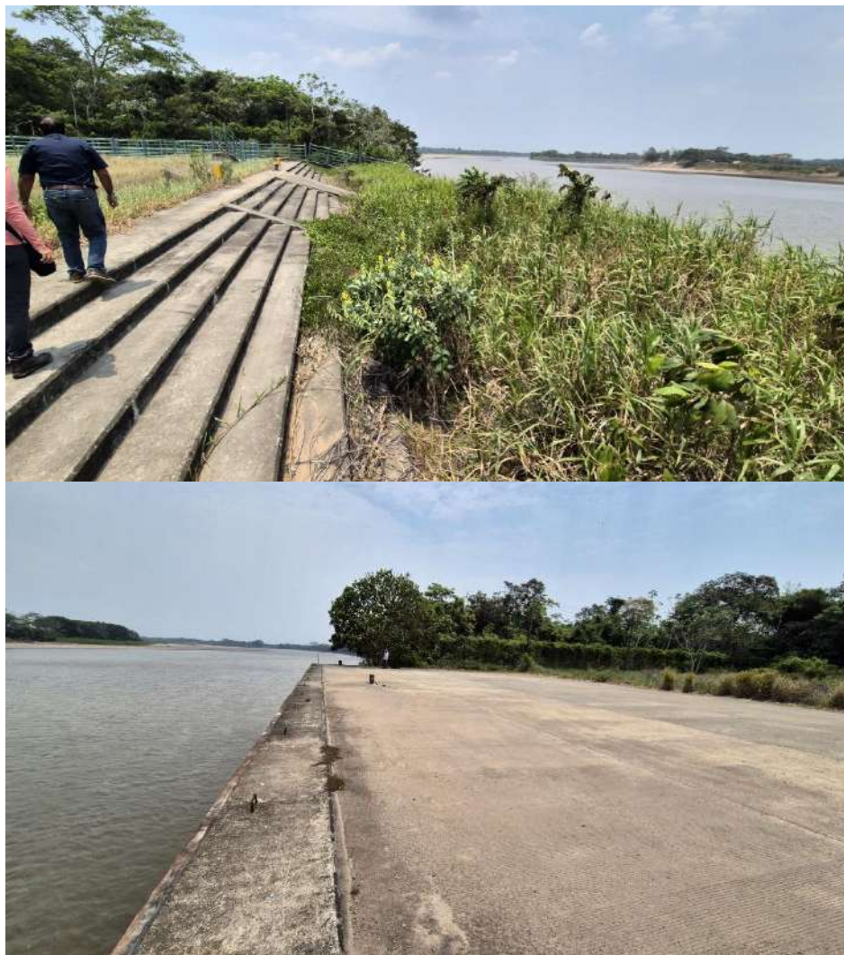
Fotografía No. 1. Sector del muelle en concreto y sedimentos sobre escalinatas
