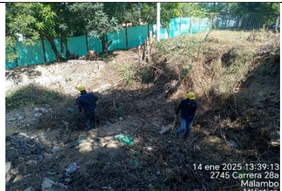
Fotografía No. 16 Rocería Tanque Semienterrado.
