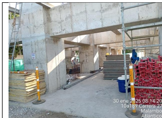
Fotografía No. 48 Frente de obra, sin actividad.
