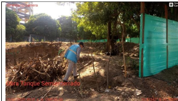
Fotografía No. 17 Rocería en tanque semienterrado.
