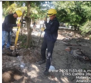
Fotografía No.6 Excavación para cerramiento.
