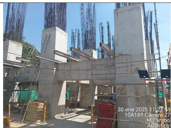
Fotografía No. 49 Frente de obra sin actividad
