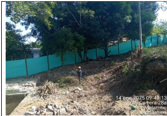
Fotografía No. 15 Rocería Tanque Semienterrado.
