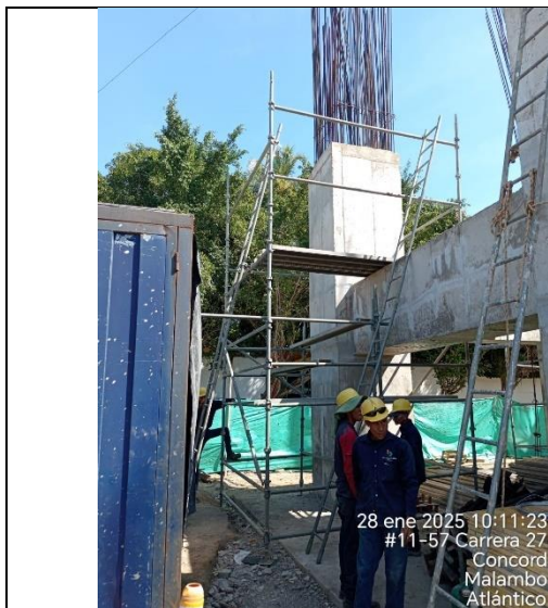
Fotografía No. 45 Instalación de andamios.
