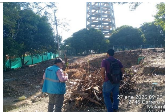
Fotografía No. 44 Frente del Tanque Semienterrado.
