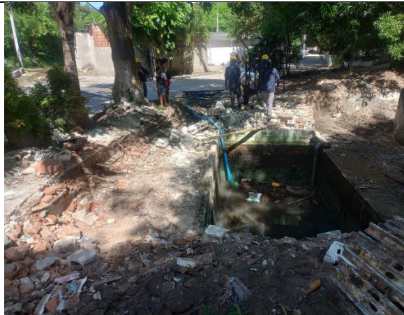
Fotografía No. 4 Desagüe de Pozo existente
