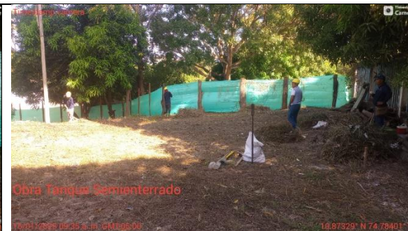
Fotografía No. 18 Rocería en tanque semienterrado
