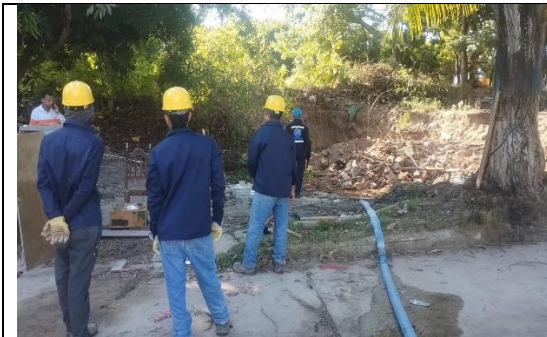
Fotografía No.5 Desagüe de Pozo existente.
