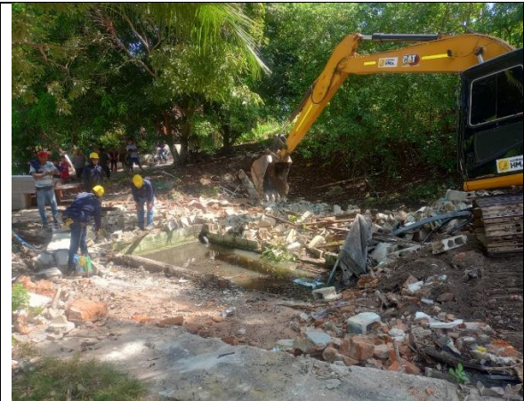
Fotografía No. 3. Demolición de estructura
