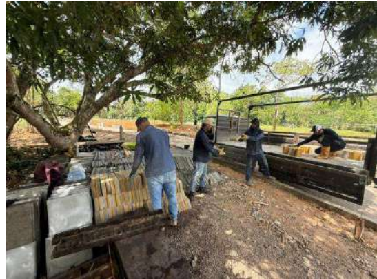
ACOMODO ADECUADO DE PREFABRICADOS
