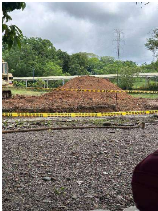
DELIMITACION DEL MATERIAL DE EXCAVACION
