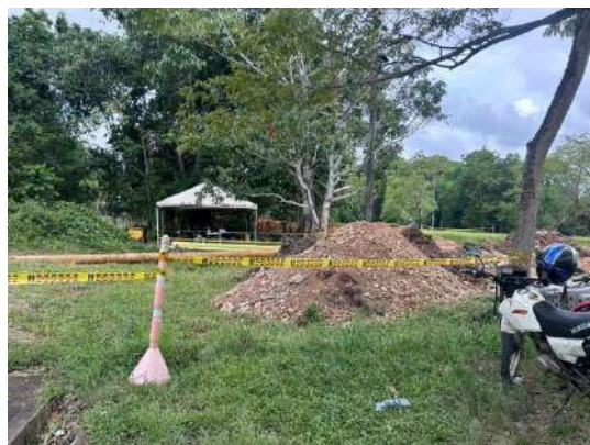
DELIMITACION DEL AREA DE TRABAJO
