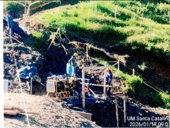
FOTOGRAFÍA Instalación de segunda máquina perforadora de drenes.
