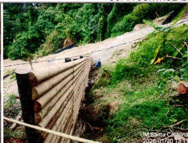
FOTOGRAFÍA Construcción de trincho parte baja del talud.
