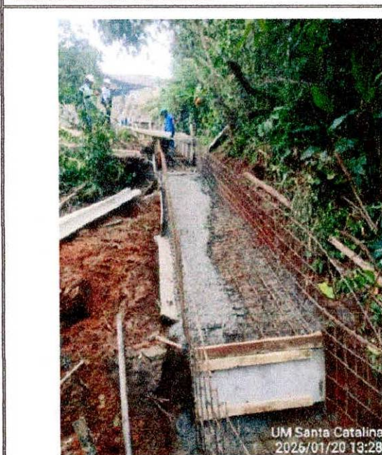
FOTOGRAFÍA Vaciado de losa de piso del canal parte baja.
