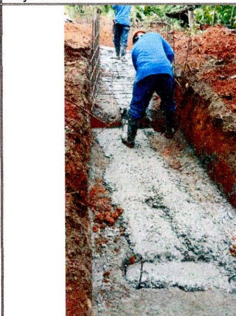
FOTOGRAFÍA Vaciado de solado de piso, llave de confinamiento y micropilotes.
