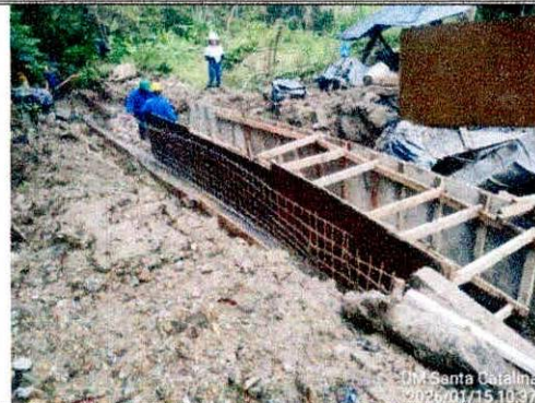
FOTOGRAFÍA Encofrado de muros del canal.
