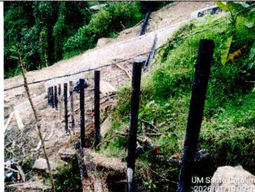
FOTOGRAFÍA Inicio construcción de trincho en la parte baja del talud.
