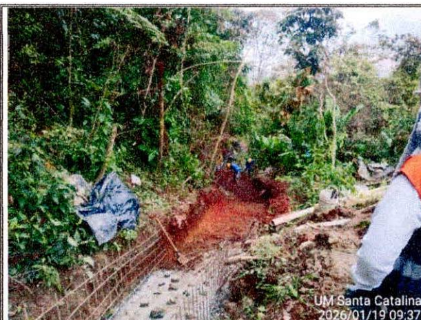
FOTOGRAFÍA Excavaciones para construcción de canal.
