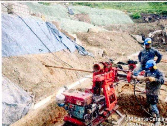
FOTOGRAFÍA Inicio de perforación de drenes.
