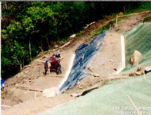
FOTOGRAFÍA Llegada de la primera maquina perforadora de drenes.
