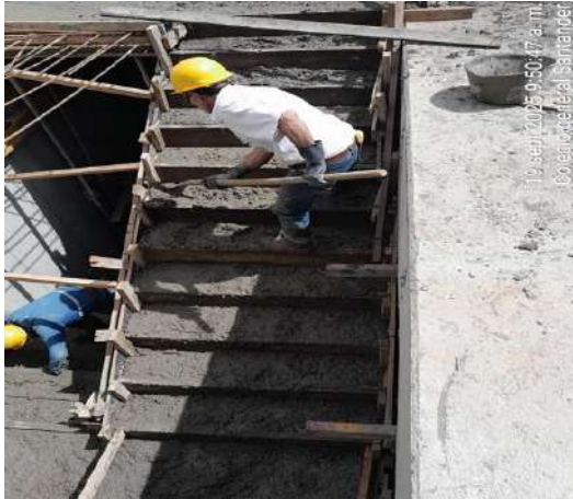
Ilustración 20: Concreto escaleras
