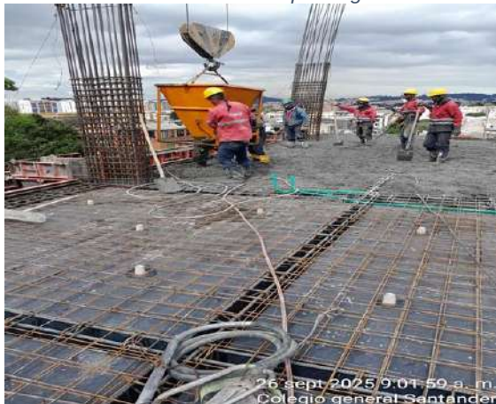
Ilustración 24: Concreto para placa de 5 nivel
