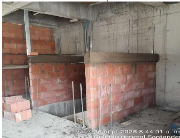
Ilustración 18: Mampostería muros del ascensor.
