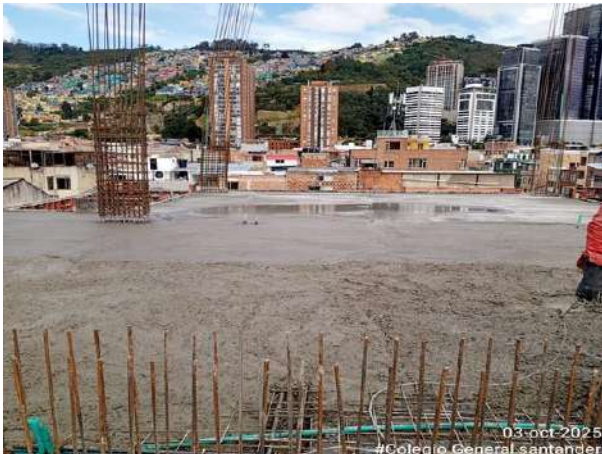
Ilustración 29: Concreto para 4to nivel costado oriental
