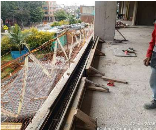
Ilustración 28: Viga de apoyo ventanería.
