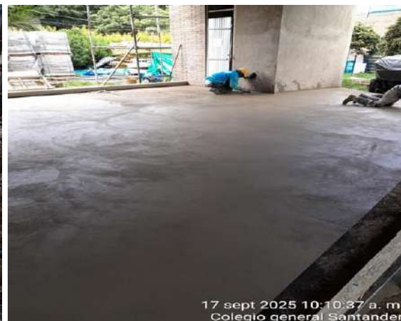
Ilustración 16: Adecuación aceros placa 3 nivel auditorio. Ilustración 17: Alistado de piso 1er Nivel Prim. infancia
