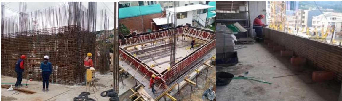
Ilustración 45: Suministro material acero, concreto y Gran Formato mampostería
