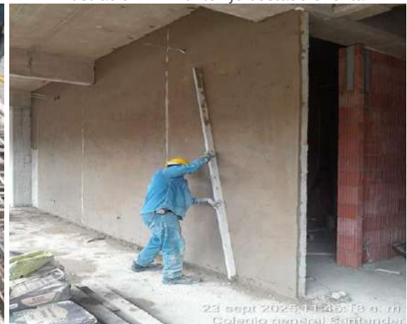
Ilustración 23: Actividades de pañete zona de aulas
