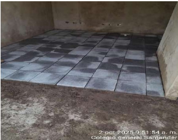
Ilustración 27: Instalación baldosa zona administrativa
