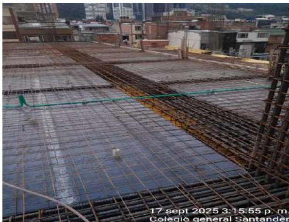
Ilustración 16: Adecuación aceros placa 3 nivel auditorio. Ilustración 17: Alistado de piso 1er Nivel Prim. infancia
