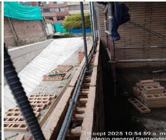
Ilustración 19: Construcción vigas canchadas
