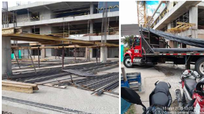
Ilustración 40: Suministro material acero para la obra
