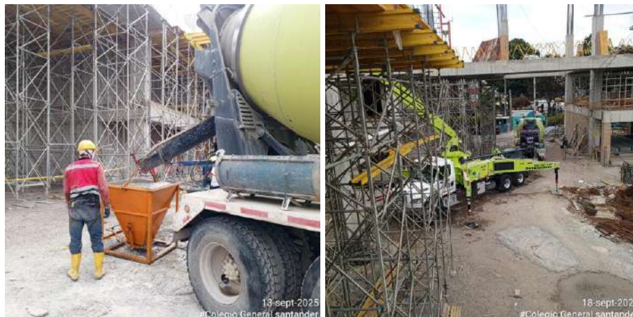
Ilustración 35: Vehículos transporte de concreto empresa Argos
