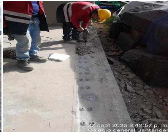
Ilustración 25: Perforación para anclajes de 5/8
