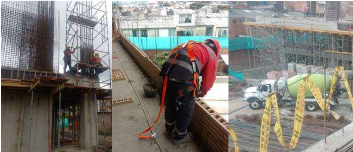
Ilustración 42: Trabajo En Alturas, Verificación y uso de EPCC, EPP y Dotación, Cinta peligro para señalización de vacíos
