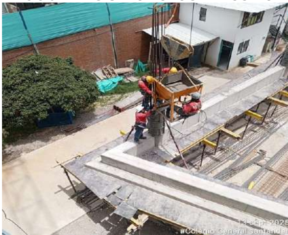
Ilustración 14: Suministro de concreto columnas ludot. Ilustración 15: Testereo pantallas 3er nivel PA 11-7/6
