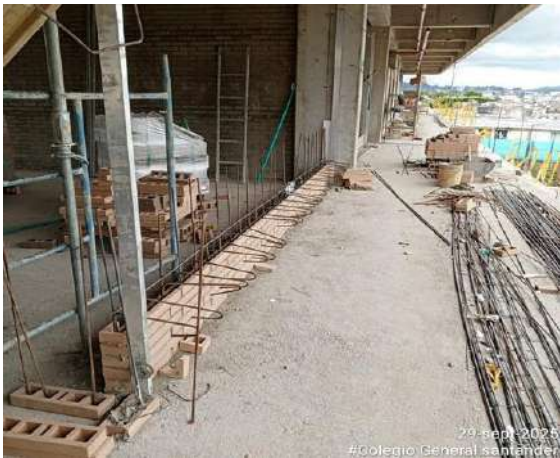
Ilustración 26: Acero bancas en concreto 3er nivel.
