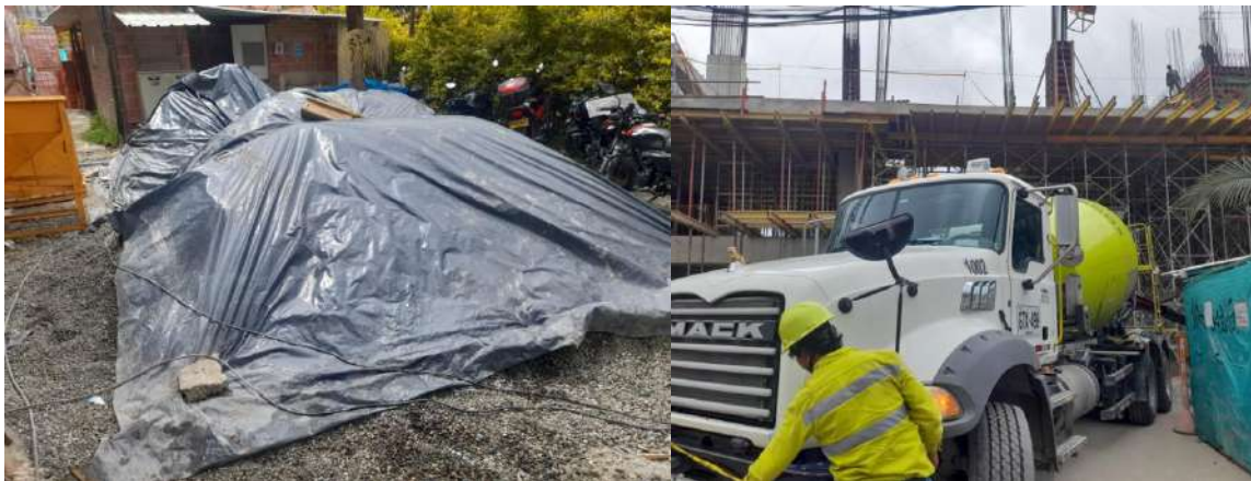
Ilustración 41: Materiales, suministros en obra
