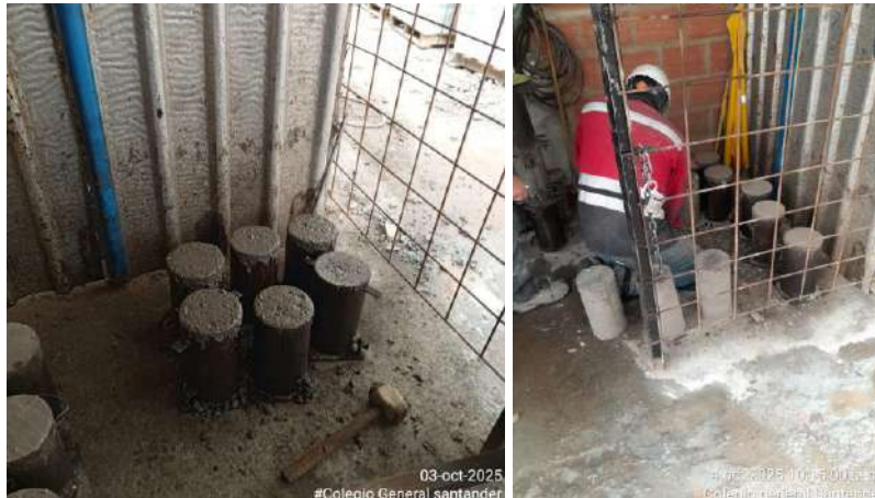
Ilustración 37: Toma muestra de cilindros para ensayo de compresión
