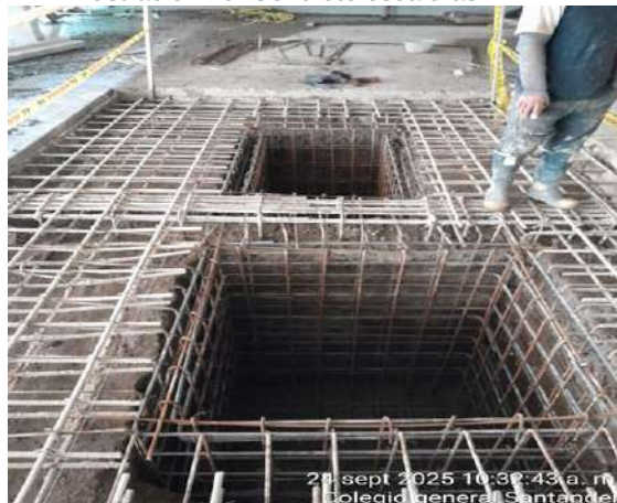
Ilustración 22: Acero de trampa de grasas sótano.
