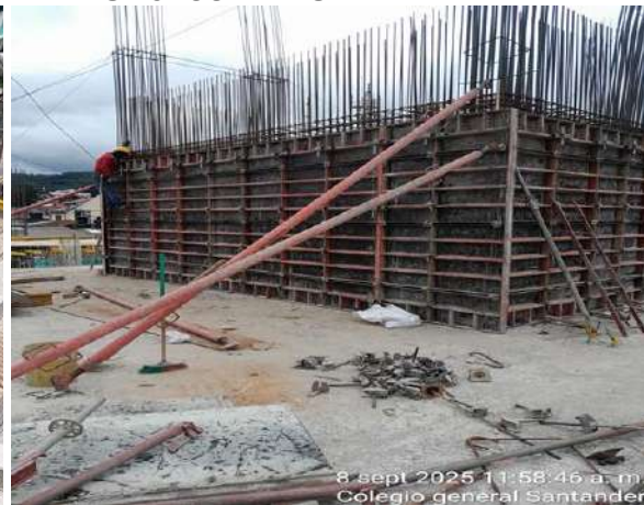
Ilustración 14: Suministro de concreto columnas ludot. Ilustración 15: Testereo pantallas 3er nivel PA 11-7/6
