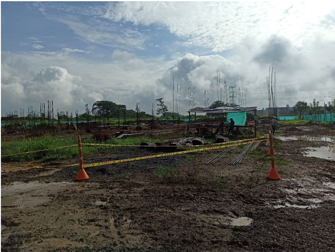
Inicio Obra de cimentación – Proyecto SENA Campus Jamundí
