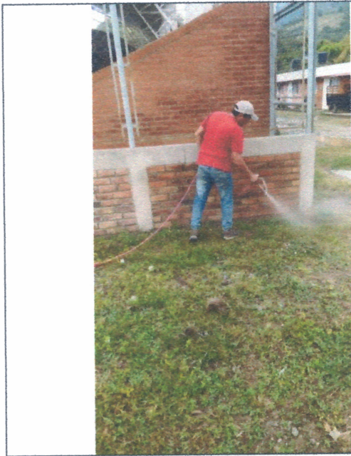
LAVADO DE MUROS ÁCIDO MURIÁTICO
