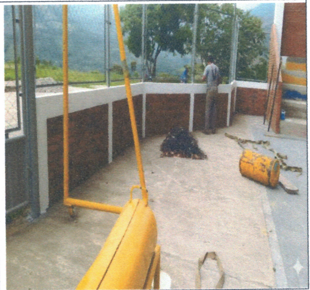
LAVADO DE MUROS ÁCIDO MURIÁTICO
