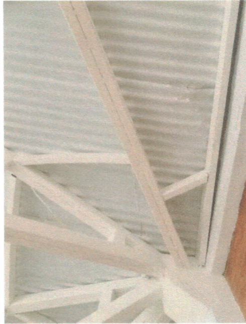
SUMINISTRO E INSTALACIÓN DE CUBIERTA GALVANIZADA TRAPEZOIDAL CAL. 30
