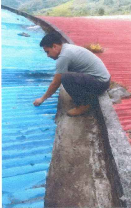
SUMINISTRO E INSTALACIÓN DE CUBIERTA GALVANIZADA TRAPEZOIDAL CAL. 30
