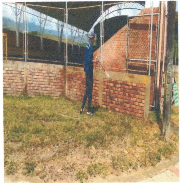
LAVADO DE MUROS ÁCIDO MURIÁTICO
