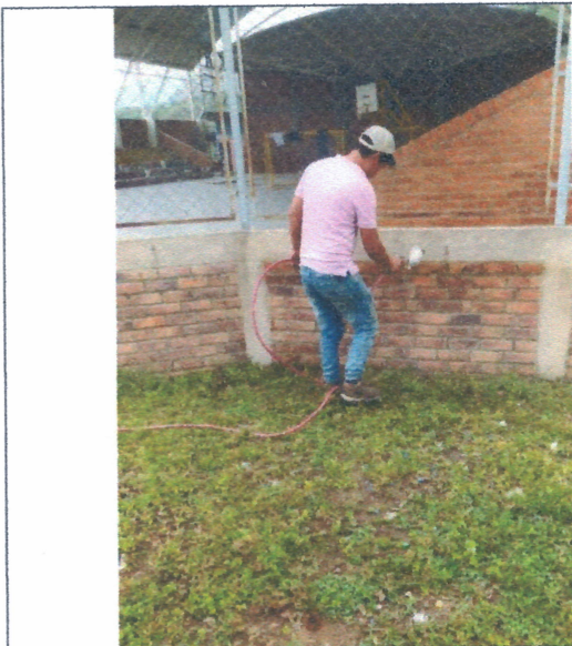
LAVADO DE MUROS ÁCIDO MURIÁTICO
