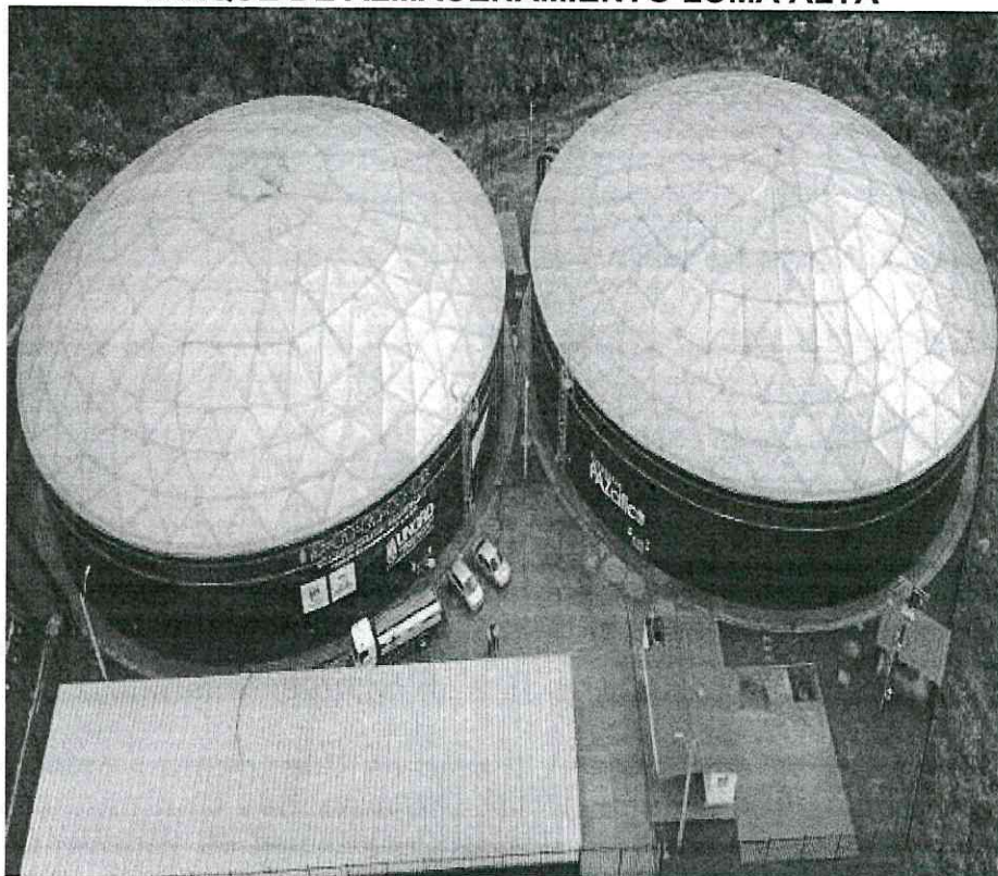
TANQUE DE ALMACENAMIENTO LOMA ALTA
