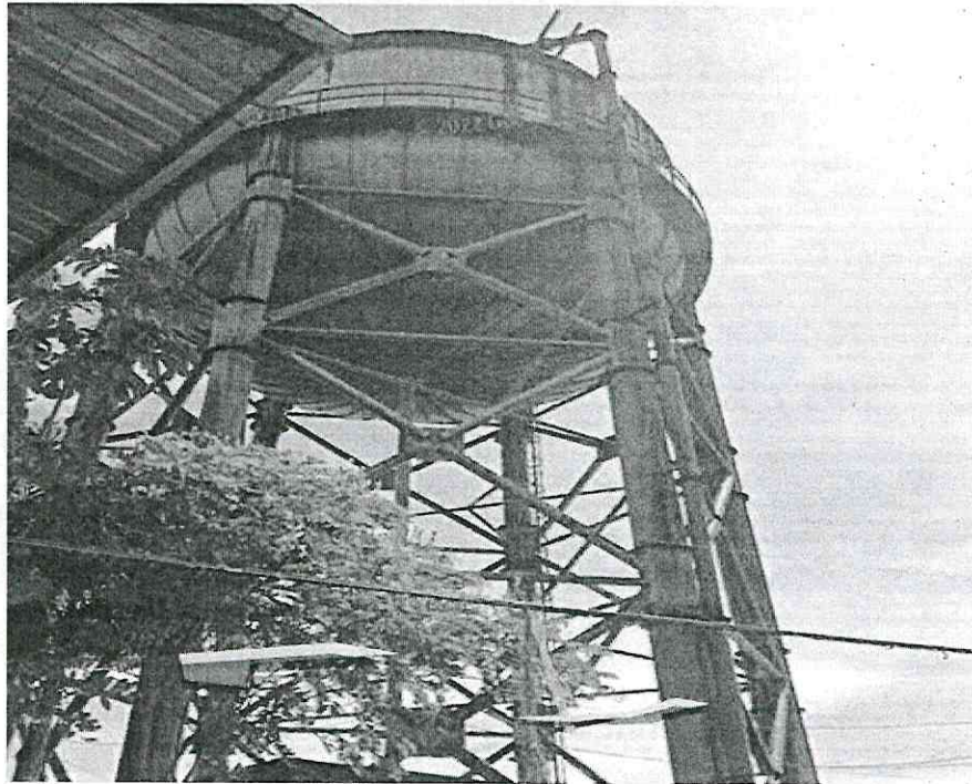
TANQUE DE ALMACENAMIENTO NAYITA
