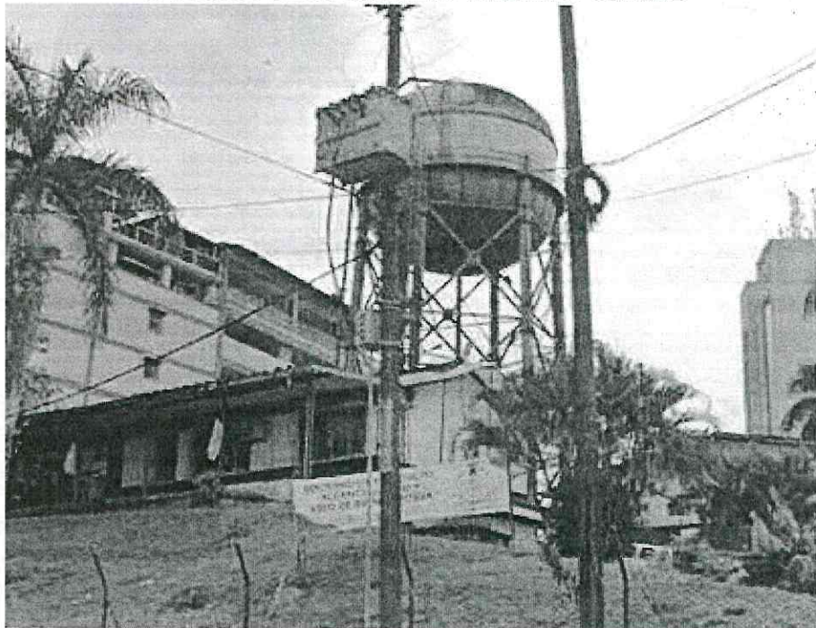
TANQUE DE ALMACENAMIENTO SAAAB
