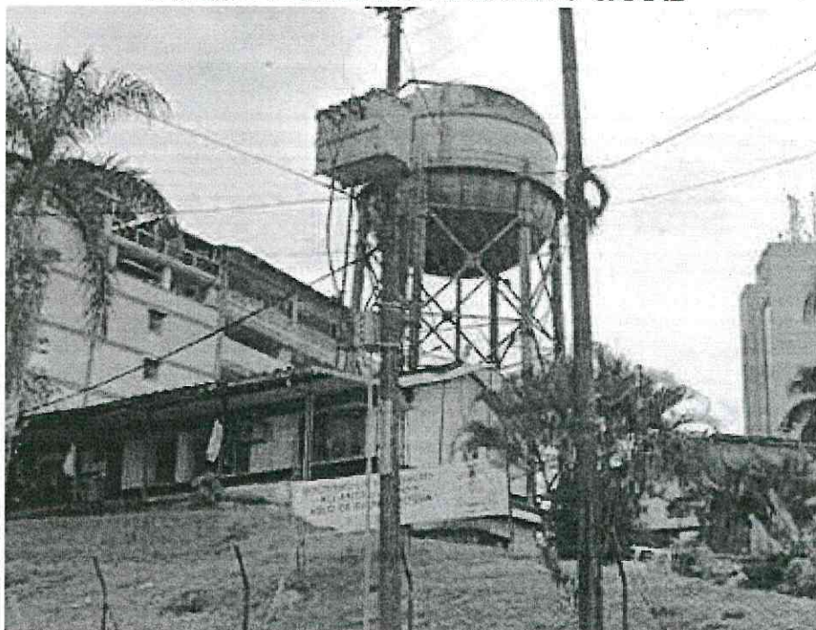
TANQUE DE ALMACENAMIENTO SAAAB
