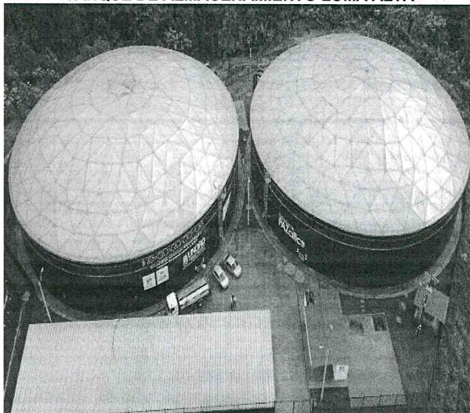
TANQUE DE ALMACENAMIENTO LOMA ALTA
