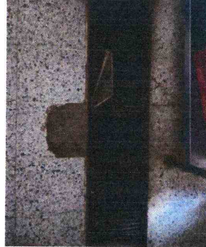
Reparación de pisos en granito pulido
