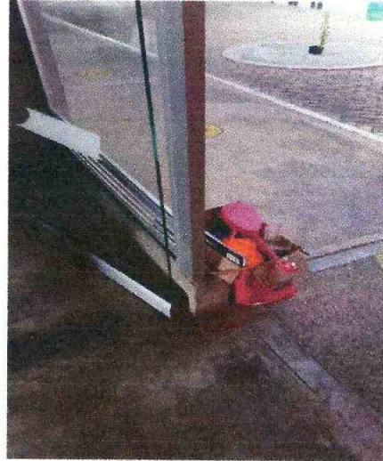
Mantenimientos de puertas en vidrio templado
