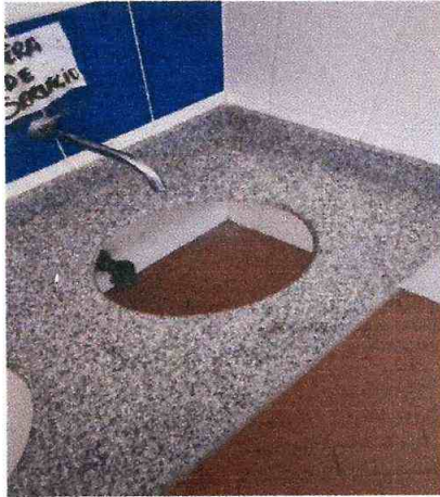
Reposición de lavamanos
