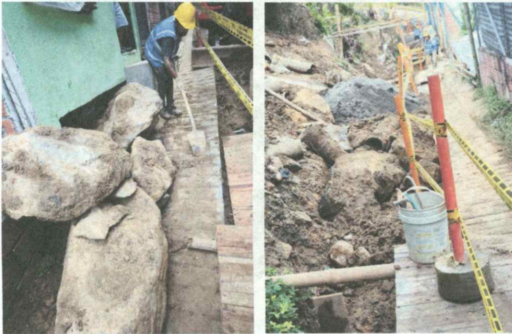
Fotos No. 9 y 10: rocas de gran tamaño extraídas de las excavaciones.
