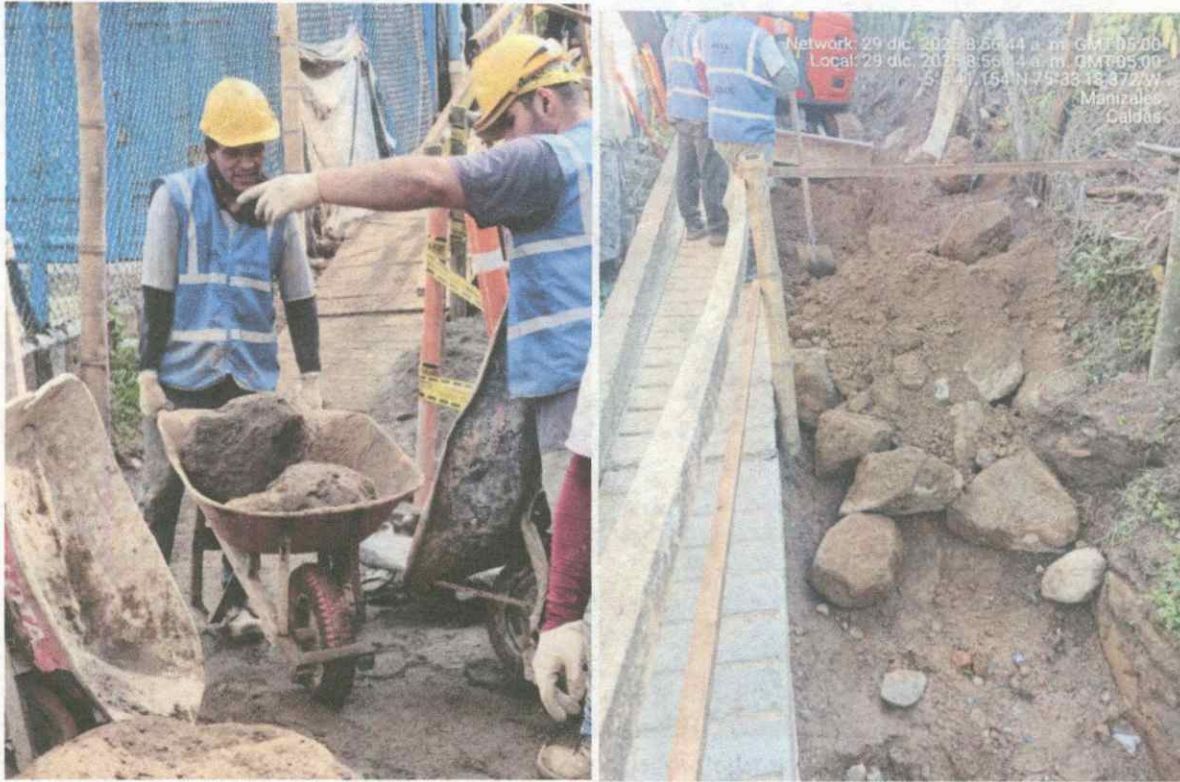
Fotos No. 11 y 12: Retiro de rocas de gran tamaño extraídas de las excavaciones.
