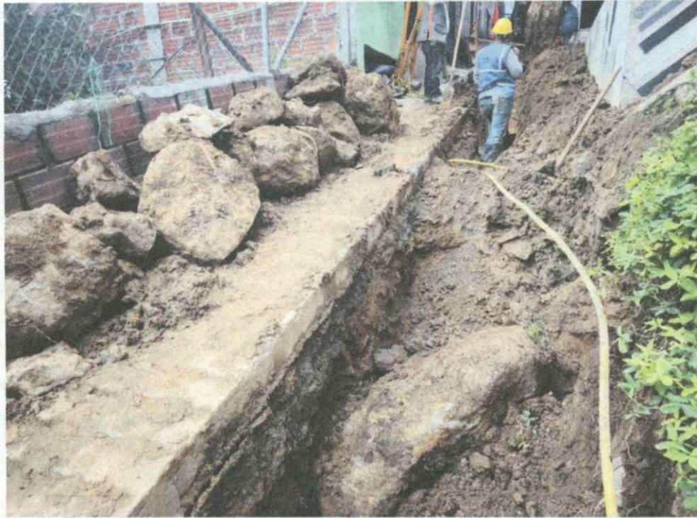
Foto No. 8: rocas de gran tamaño extraídas de las excavaciones, y otras dentro de la excavación pendientes por demolición.
