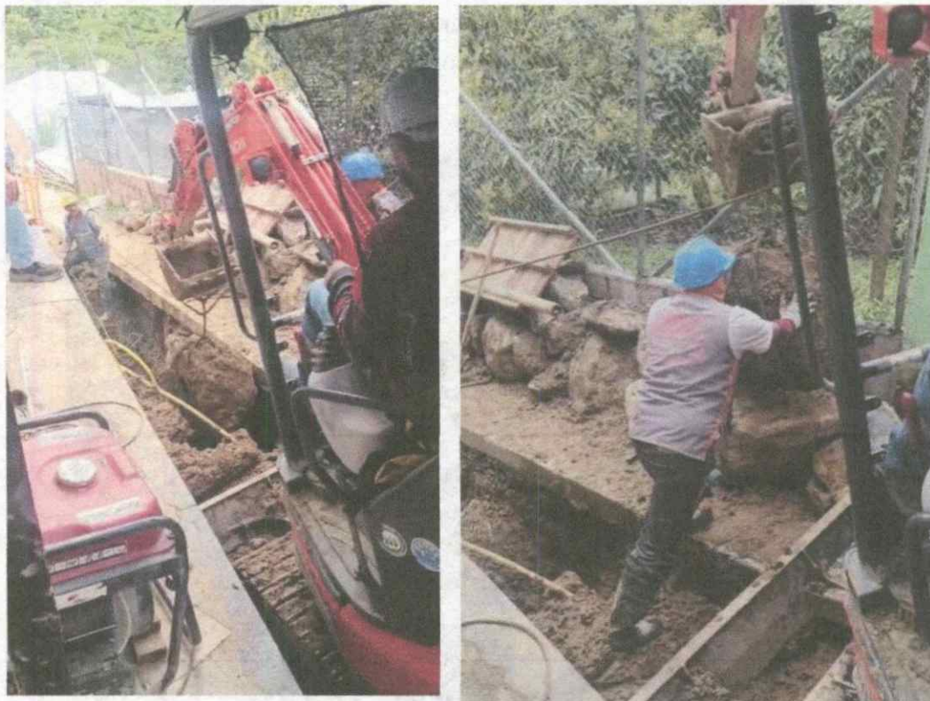
Fotos No. 13 y 14: Retiro de rocas de gran tamaño extraídas de las excavaciones.
