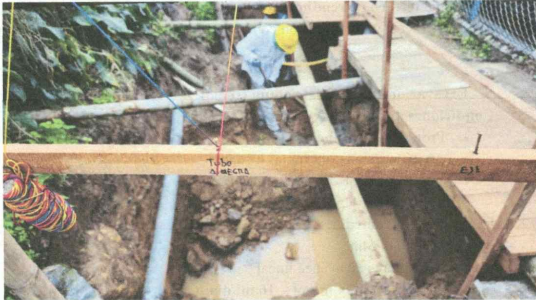
Foto No. 5: Se observa la excavación de la cámara con afectaciones a causa de las lluvias de la noche anterior.
