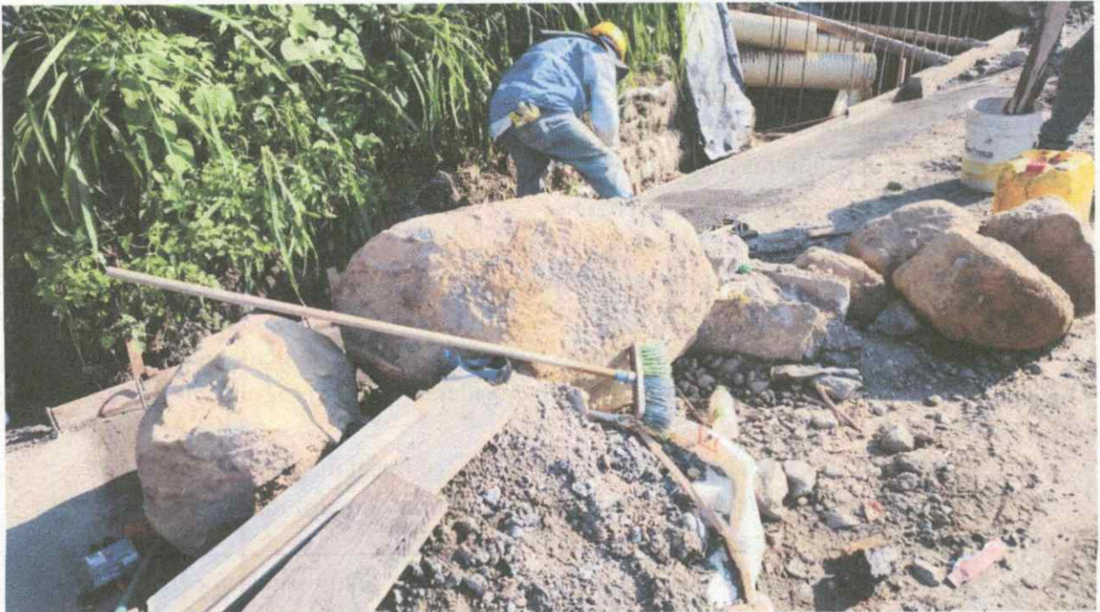
Foto No. 7: rocas de gran tamaño extraídas de las excavaciones.
