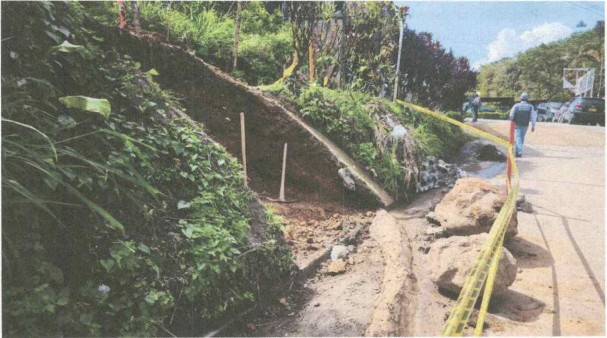
Foto No. 6: Esta foto es tomada el día 02 de diciembre, cuando apenas se les daba inicio a las excavaciones, encontrado ya, rocas de gran tamaño como se observa.
