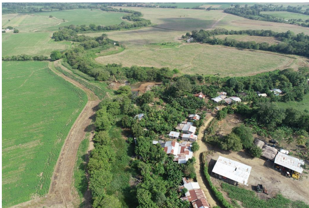
Fotografía 11. Limpieza de caño Bugre- Se observa maquinaria en campo
