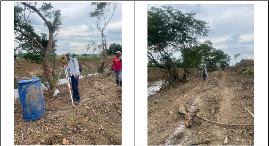
Fotografía 5. Localización, trazado y replanteo.
