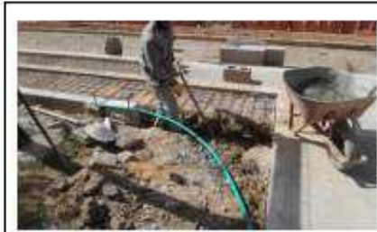
FOTO 39. Rabaje de cámara de telecomunicaciones en sector D1
