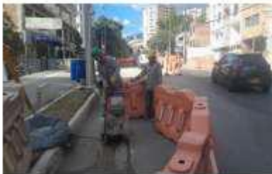
Foto 15. Corte de pavimento para excavación red de gas vector los Angeles
