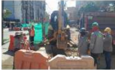
FOTO 33. Excavación para red de aguas lluvias sector Villas del Carmen
