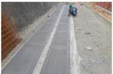
FOTO 19. Vaciado de andén entre calle 55 sur y CEB
