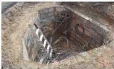
FOTO 40. Rabaje de cámara de telecomunicaciones en sector D1
