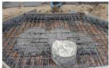
Foto 17. Vaciado de tapa losa cámara de telecomunicaciones sector calle 55 sur
