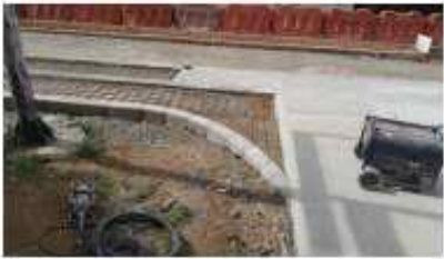
FOTO 44. Instalación bordillo en sector Savannah
