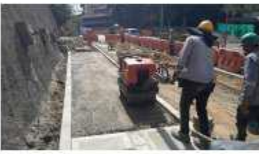
FOTO 36. Conformación de llenos para arden entre calle 55 sur y CES
