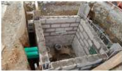
FOTO 43. Adecuación cámara de telecomunicaciones en calle 55 sur
