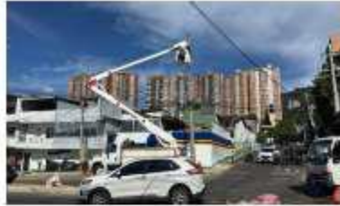
FOTO 34. Traslado de cámara y poste en calle 60 sur con cra 43 A
