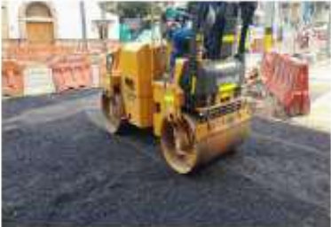
FOTO 41. Adecuación de acceso en pavimento provisional parqueadero D1
