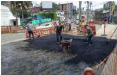
FOTO 42. Adecuación de acceso en pavimento provisional parqueadero D1
