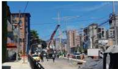
FOTO 35. Traslado de cámara y poste en calle 60 sur con cra 43 A
