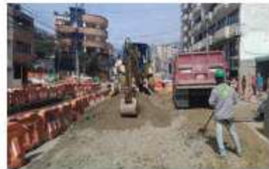
FOTO 37. Nivelación calzada occidental entre calle 56 sur y calle 55 sur
