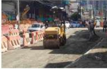
FOTO 38. Compactación en revelesión de calzada occidental entre calle 56 sur y calle 55 sur
