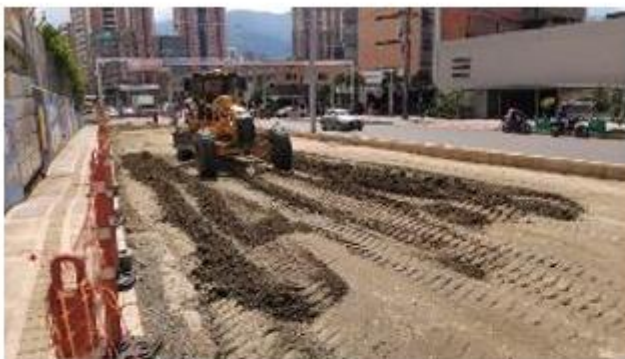
FOTO 59. Cereo y nivelación de base granular en sector Hogar Nazareth
