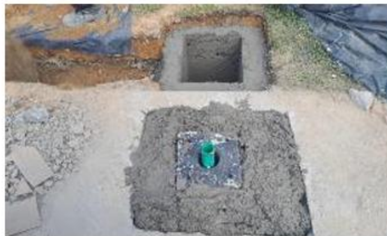
Foto 2: Construcción de dados para semáforos en calle 60 sur
