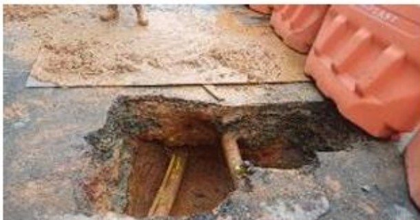
FOTO 31. Conexión empalme red de gas en sector D1
