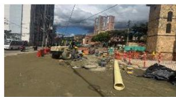
FOTO 100. Construcción de aguas lluvias en sector Villas del Carmen
