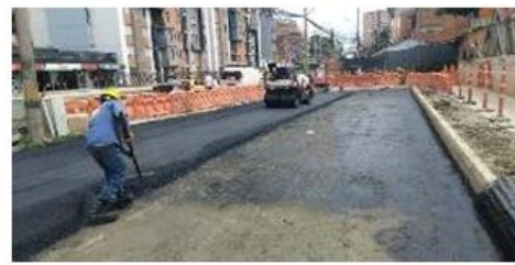
FOTO 104. Instalación de mezcla asfáltica en sector parroquia Nuestra Señora del Carmen
