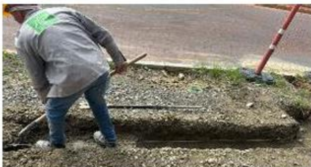
FOTO 85. Excavación para instalación de bordillos en paradero de bus sector Casa Blanca
