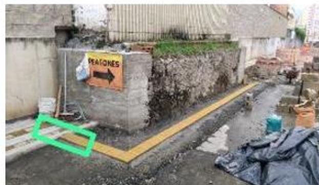
FOTO 98. Construcción de andén en sector San Antonio
