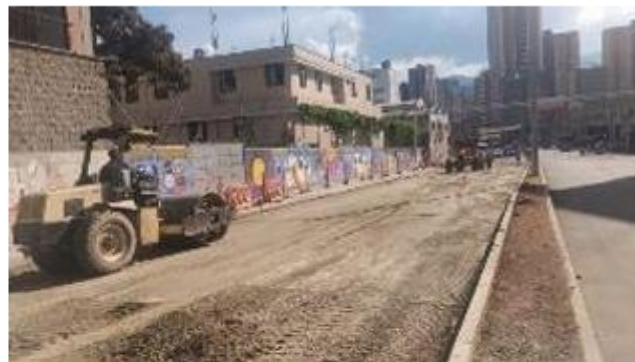
FOTO 60. Compactación de base granular en sector Hogar Nazareth
