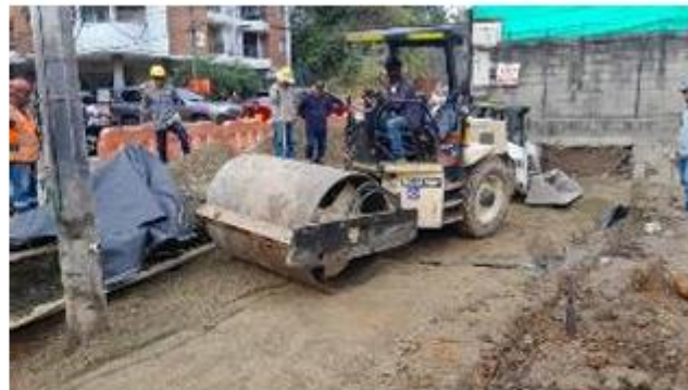
FOTO 48. Compactación para conformación de vía en base granular cra 43 A entre calles 56 sur y 55 sur
