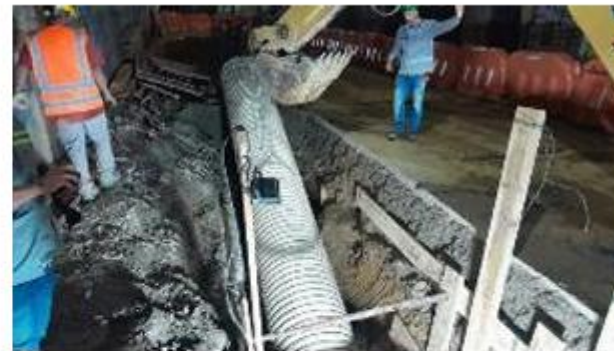
FOTO 66. Construcción de red combinada en calle 61 sur
