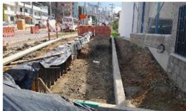
FOTO 84. Construcción de andén sector Filam
