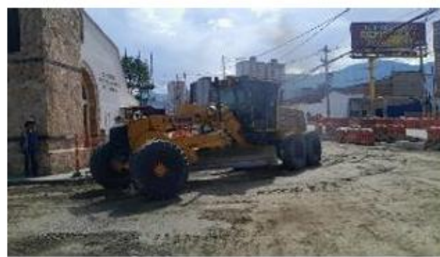
FOTO 82. Cereo y nivelación de base granular en sector Villas del Carmen
