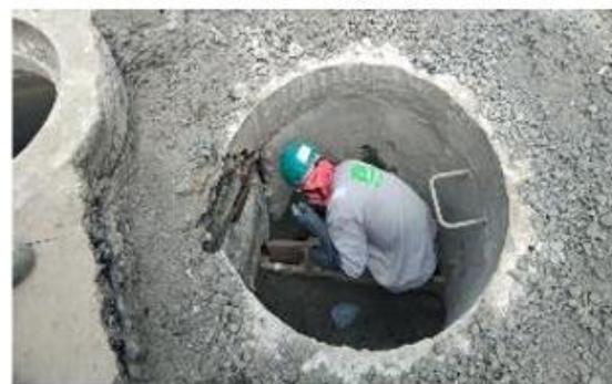
FOTO 20. Construcción MH en sector Nuestra Señora del Carmen
