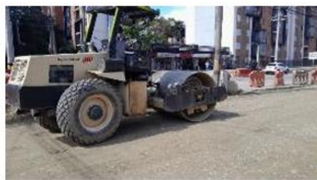
FOTO 80. Compactación de base granular en sector Villas del Carmen
