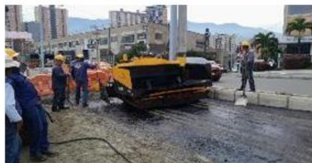
FOTO 73. Instalación de primera capa de pavimento sector Hogar Nazareth
