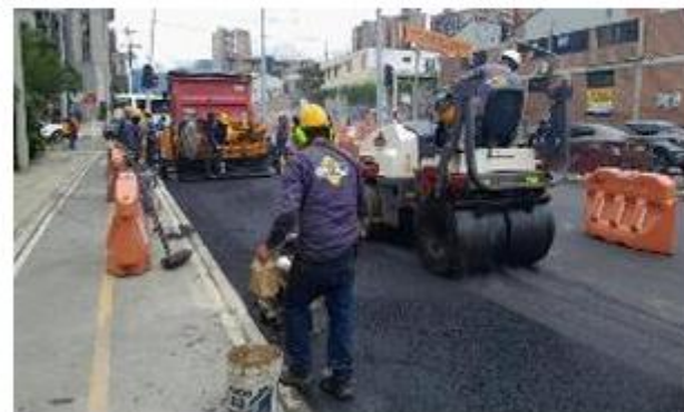
FOTO 69. Instalación de segunda capa de pavimento en sector Caseritas
