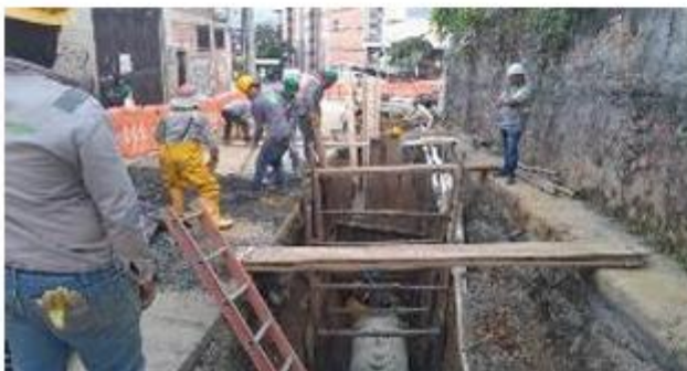
FOTO 93. Construcción de ampliación red de aguas combinadas en calle 61 sur
