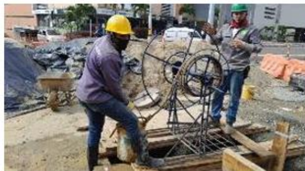
FOTO 64. Excavación para expansión de red combinada en calle 61 sur
