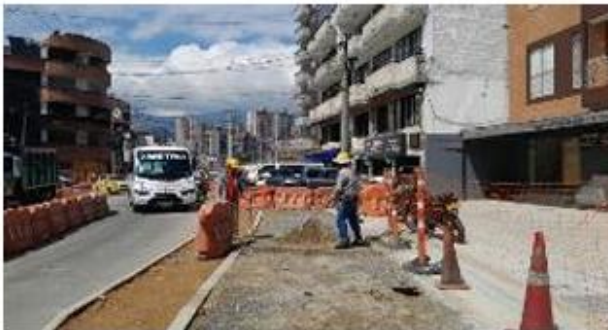
FOTO 45. Conformación de llenos en ciclorruta calle 55 sur
