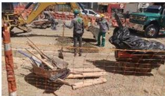
Foto 17: Excavación para red eléctrica sector Nuestra Señora del Carmen
