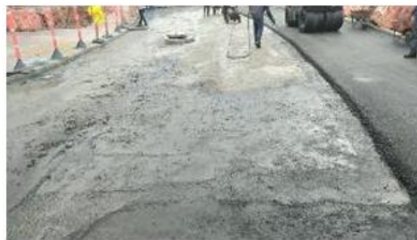
FOTO 101. Instalación de mezcla asfáltica en sector parroquia Nuestra Señora del Carmen
