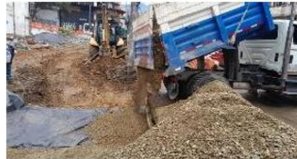
FOTO 46. Lleno para conformación de via en base granular cra 43 A entre calles 56 sur y 55 sur
