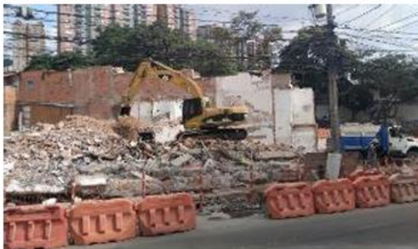
Foto 12: Demolición en edificio cristal ID 14
