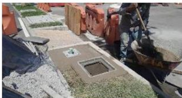
FOTO 27. Construcción de dados semaforización calle 60 sur
