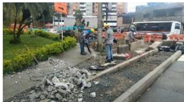
FOTO 86. Demolición de andén existente en calle 55 sur
