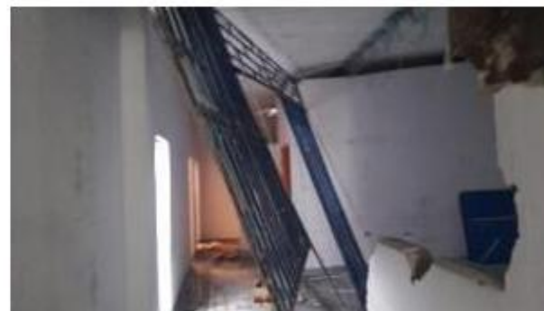
FOTO 96. Desmonte y demolición ID 87
