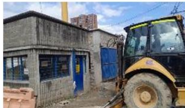
FOTO 34. Demolición caseta existente Filam
