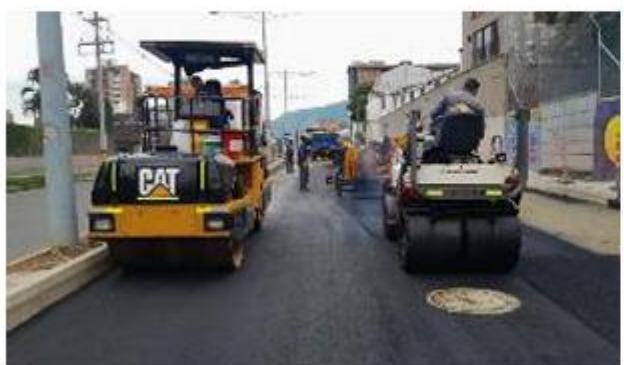
FOTO 75. Instalación de primera capa de pavimento sector Hogar Nazareth
