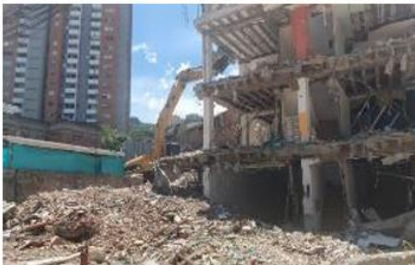
Foto 11: Demolición ID 14 Edificio cristal
