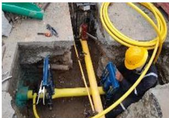
FOTO 25: Conexiones empalmes red de gas calle 57 sur
