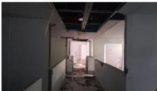
FOTO 97. Desmonte y demolición ID 87
