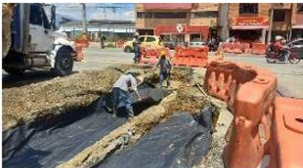
FOTO 53. Instalación de geotextil existente en cruce cra 43A x Calle 58 sur sector Villas del Carmen
