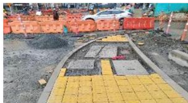
FOTO 54. Construcción de anden en sector Parroquia Nuestra Señora del Carmen
