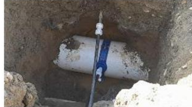
FOTO 44. Traslado de acometidas de acueducto a red nueva sector Espacio Óptimo
