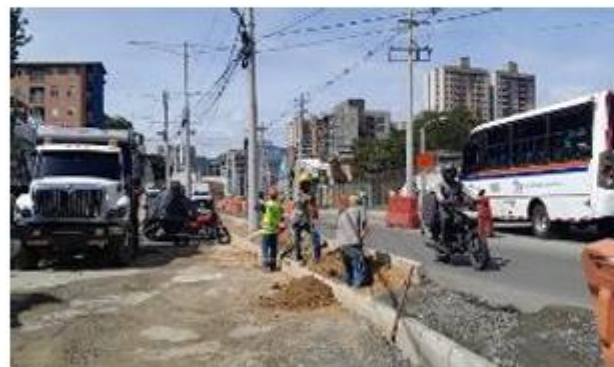
FOTO 57. Construcción de caja de media tensión separador central sector Villas del Carmen
