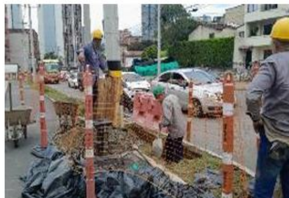
FOTO 26. Construcción de dados para semaforización calle 60 sur
