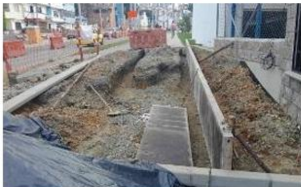
FOTO 61. Construcción de andén en sector portería filam
