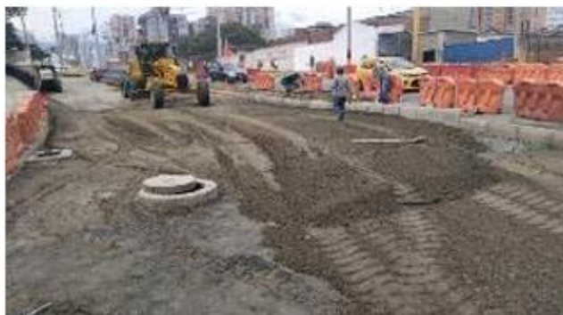
FOTO 79. Cereo y nivelación de base granular en sector Villas del Carmen
