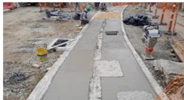
FOTO 56. Construcción de anden en sector Parroquia Nuestra Señora del Carmen
