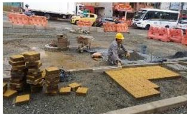
FOTO 38. Construcción de anden sector Parroquia Nuestra Señora del Carmen
