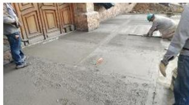
FOTO 78. Construcción de andén en sector Parroquia Nuestra Señora del Carmen
