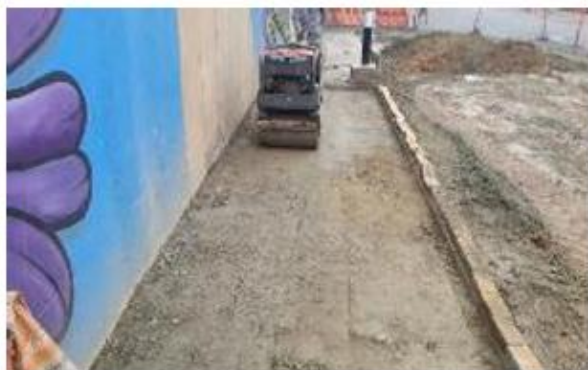
FOTO 37. Construcción de anden en sector Hogar Nazareth
