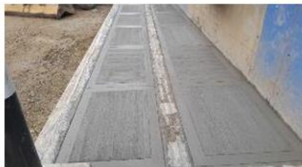
FOTO 36. Construcción de anden en Hogar Nazareth
