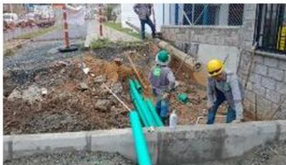
FOTO 35. Instalación redes de telecomunicaciones sector Filam y bordillo sector Filam
