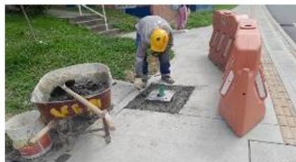
FOTO 28. Construcción de dados semáforos Calle 60 sur
