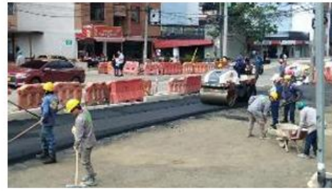
FOTO 102. Instalación de mezcla asfáltica en sector parroquia Nuestra Señora del Carmen
