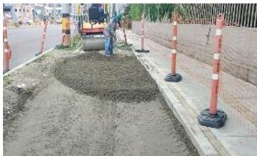
Foto 6: Instalación de Base granular en ciclorruta
