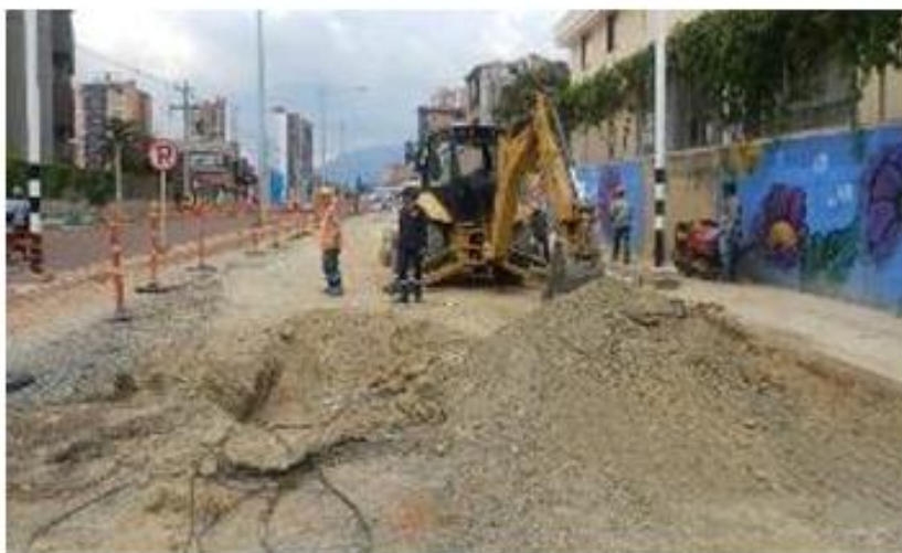
Foto 13: Excavación sector Hogar Nazareth
