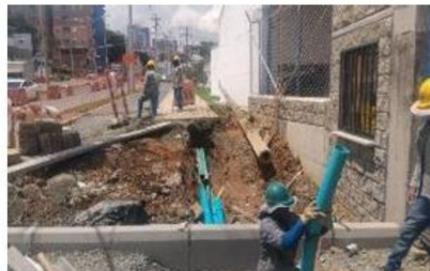
FOTO 62. Instalación canalización de redes de telecomunicaciones
