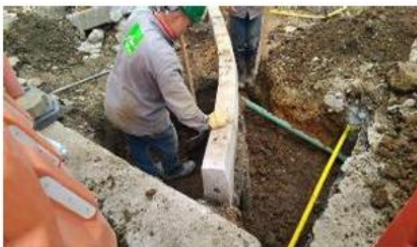
FOTO 39: Construcción Andenes sector Villas del Carmen
