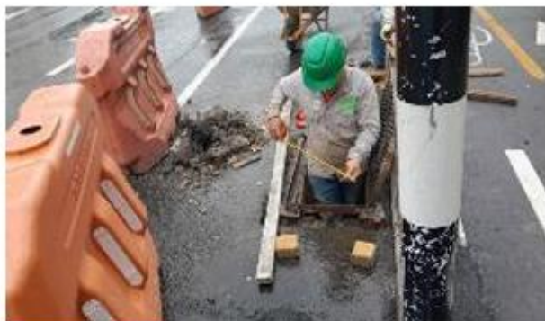
FOTO 29. Construcción de sumidero en sector caseritas
