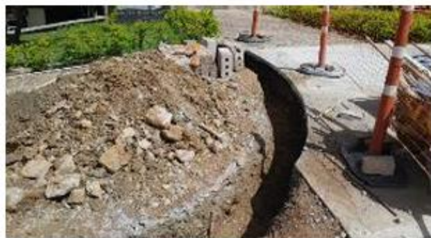
FOTO 49. Conformación de andén y urbanismo en calle 55 sur
