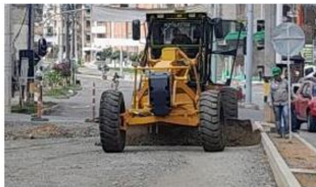
FOTO 58. Cereo y nivelación de base granular en sector Hogar Nazareth
