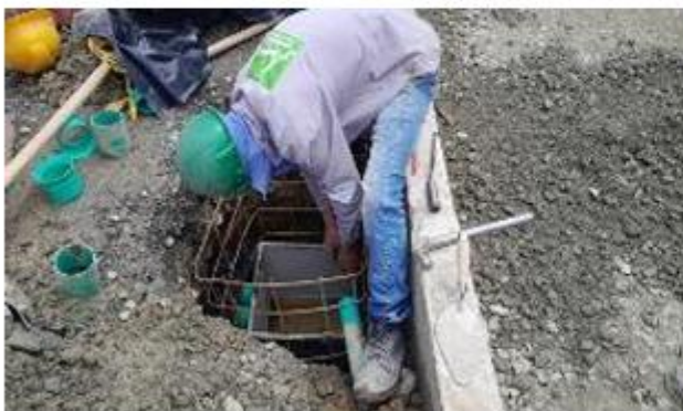
FOTO 81. Construcción de caja eléctrica sector Villas del Carmen
