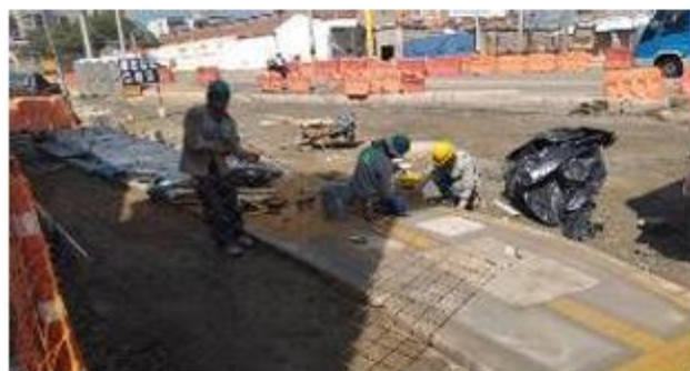
FOTO 55. Construcción de anden en sector Parroquia Nuestra Señora del Carmen
