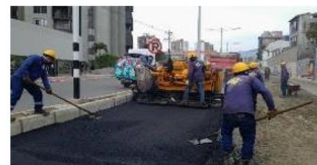
FOTO 74. Instalación de primera capa de pavimento sector Hogar Nazareth
