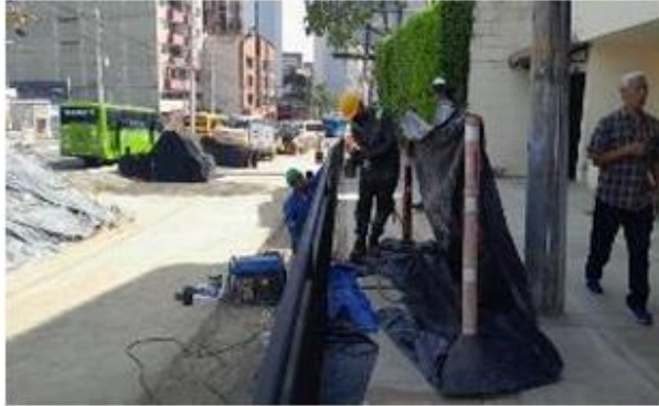
FOTO 41. Aplicación de pintura en pasamanos sector San Antonio 2
