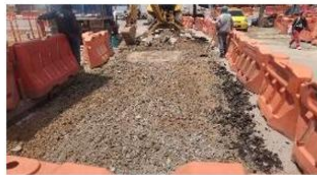
FOTO 52. Demolición de carpeta existente en cruce cra 43A x Calle 58 sur sector Villas del Carmen
