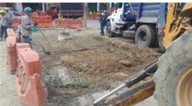
FOTO 51. Conformación de estructura de vía en cruce cra 43A x Calle 58 sur sector Villas del Carmen
