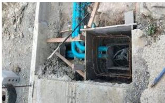
FOTO 21. Construcción caja para telecomunicaciones sector Nuestra Señora del Carmen
