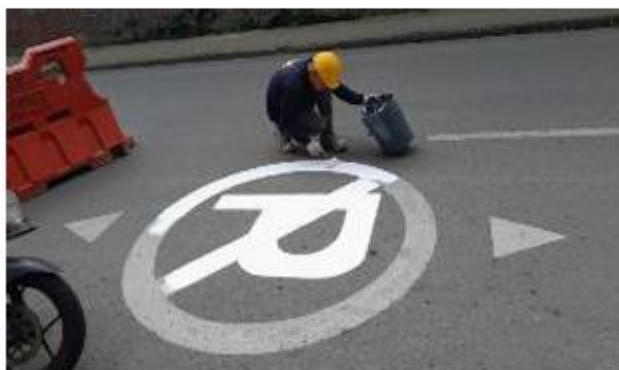
FOTO 63. Señalización horizontal para PMT
