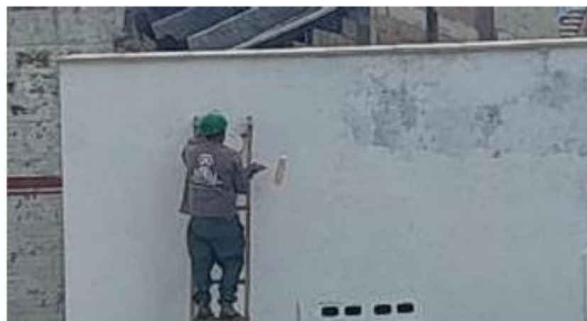
Foto 8: Aplicación de pintura muro colindante filam con zona verde cra 43A
