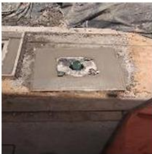
Foto 7: Construcción de pedestales semáforos Calle 60 sur
