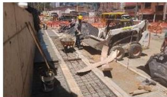
Foto 18: Construcción Andenes sector Nuestra Señora del Carmen
