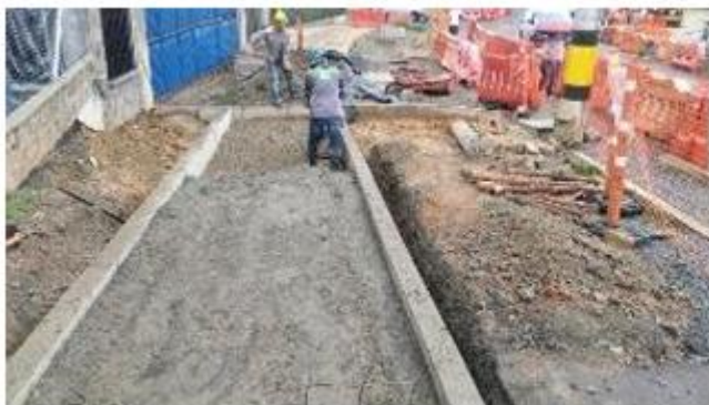
FOTO 83. Construcción de andén sector Filam
