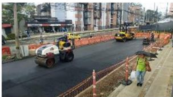
FOTO 99. Pavimentación sector Villas del Carmen primera capa
