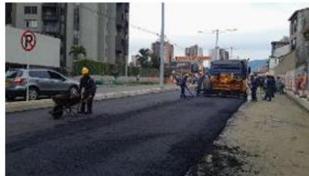
FOTO 72. Instalación de primera capa de pavimento sector Hogar Nazareth
