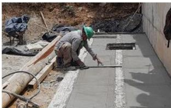
FOTO 19. Construcción de andén en sector Nuestra Señora del Carmen
