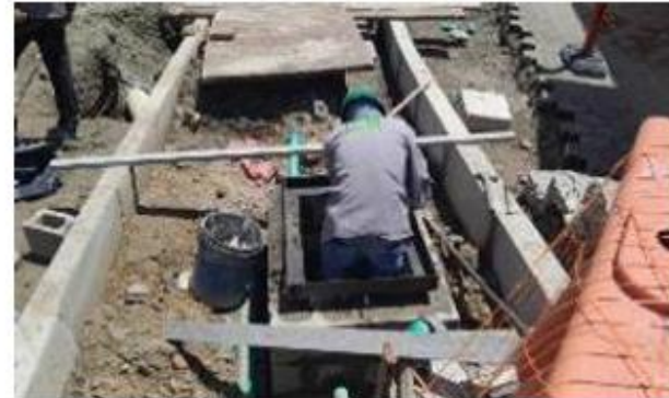
FOTO 42. Construcción caja para telecomunicaciones sector Villas del Carmen
