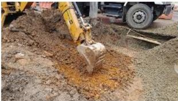
FOTO 47. Excavación para conformación de vía en base granular cra 43 A entre calles 56 sur y 55 sur
