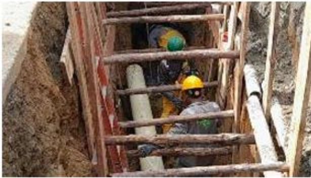
FOTO 65. Construcción de red combinada en calle 61 sur
