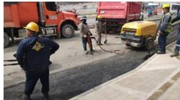
FOTO 68. Instalación de pavimento en brecha acueducto sector Espacio Óptimo
