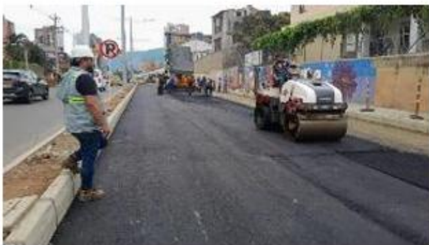
FOTO 71. Instalación de primera capa de pavimento sector Hogar Nazareth
