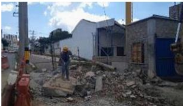
FOTO 33. Limpieza de escombros en portería filam
