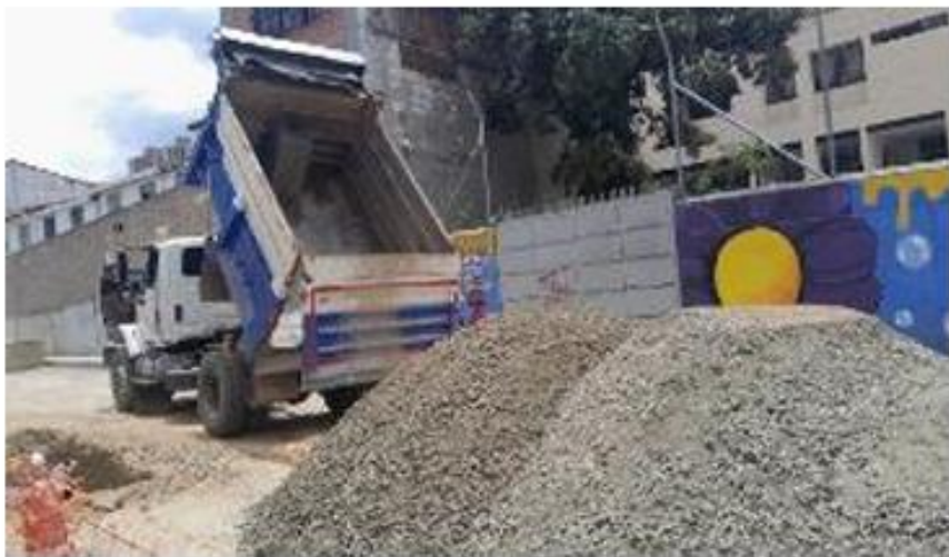
Foto 14: Base granular para conformación de vía en Hogar Nazareth
