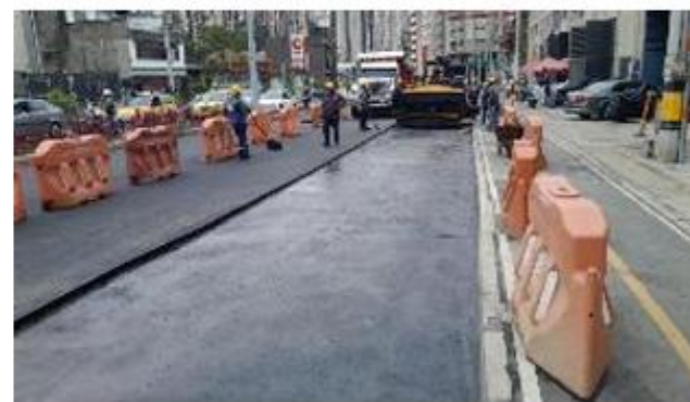
FOTO 70. Instalación segunda capa de pavimento sector Casertias
