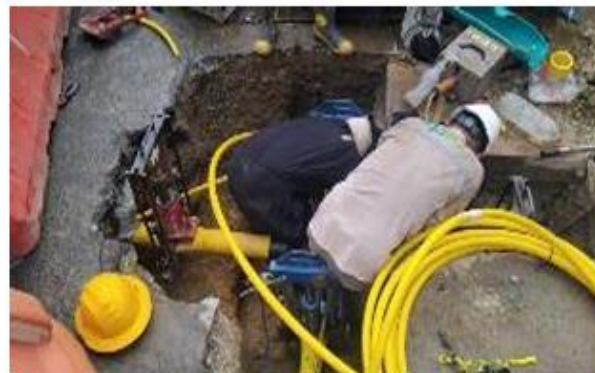
FOTO 24. Conexiones empalmes red de gas calle 57 sur
