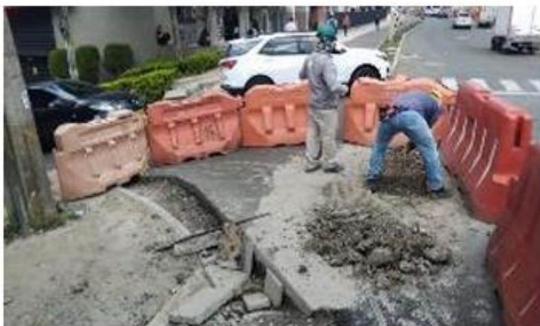
Foto 1: Excavación para acometidas red de gas calle 57 sur
