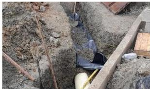
FOTO 40. Construcción red de aguas lluvias en sector Villas del Carmen
