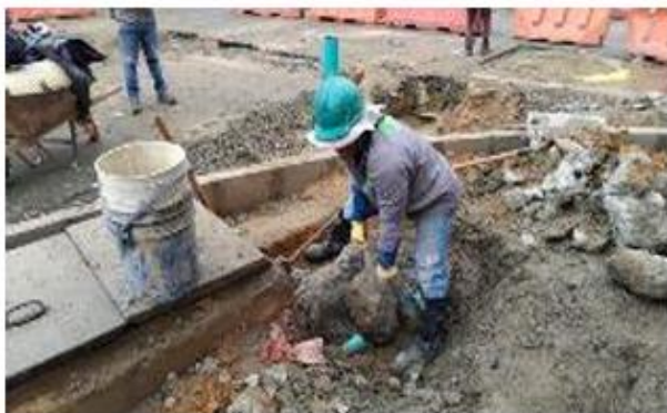
FOTO 23. Nivelación de terreno para construcción de andén en calle 55 sur
