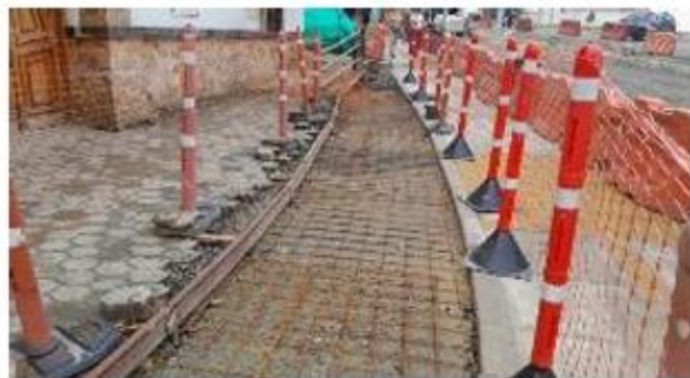
FOTO 77. Construcción de andén en sector Parroquia Nuestra Señora del Carmen
