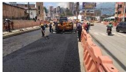
FOTO 103. Instalación de mezcla asfáltica en sector parroquia Nuestra Señora del Carmen
