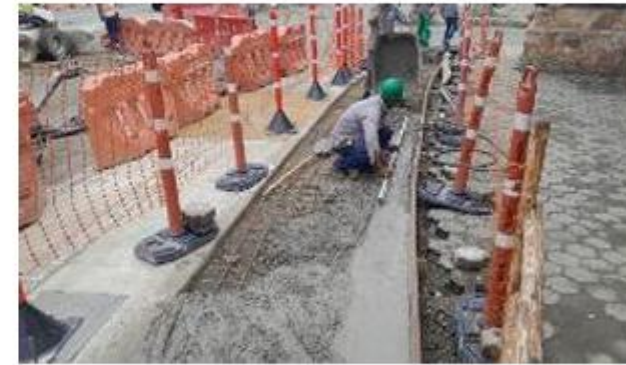
FOTO 76. Construcción de andén en sector Parroquia Nuestra Señora del Carmen
