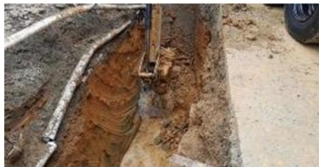
FOTO 92. Construcción de ampliación red de aguas combinadas en calle 61 sur
