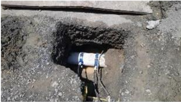
FOTO 43. Traslado de acometidas de acueducto a red nueva sector Espacio Óptimo
