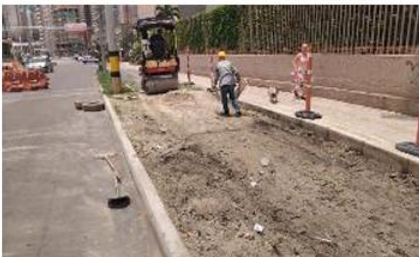
Foto 5: Excavación para continuación de ciclorruta sector casa blanca
