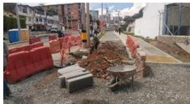
FOTO 94. Construcción de urbanismo sector Filam
