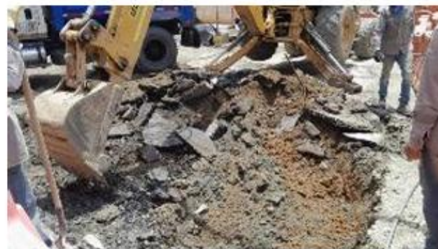
FOTO 50. Demolición de carpeta existente en cruce cra 43A x Calle 58 sur sector Villas del Carmen
