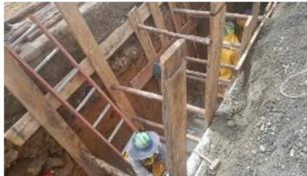
FOTO 67. Construcción de red combinada en calle 61 sur
