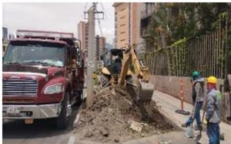
Foto 4: Excavación para continuación de ciclorruta sector casa blanca
