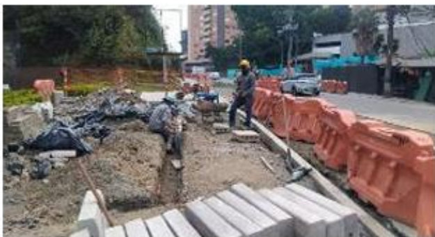
FOTO 87. Instalación de Bordillos en calle 55 sur
