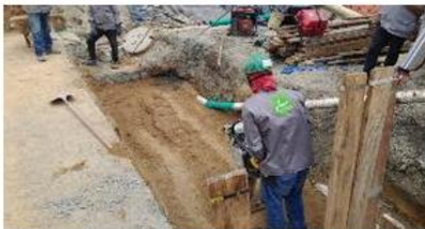
FOTO 91. Llenos en ampliación de aguas combinadas en calle 61 sur
