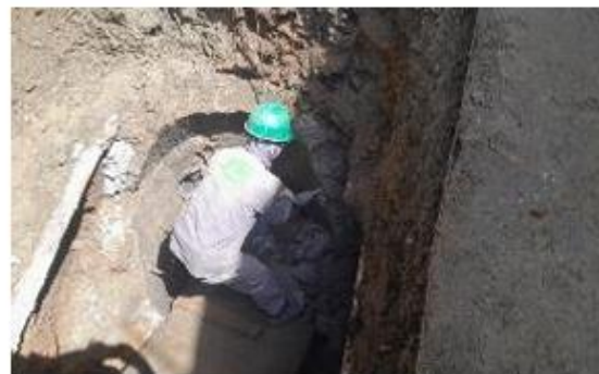
Foto 12: Demolición MH existente en calle 61 sur para ampliación de aguas combinadas
