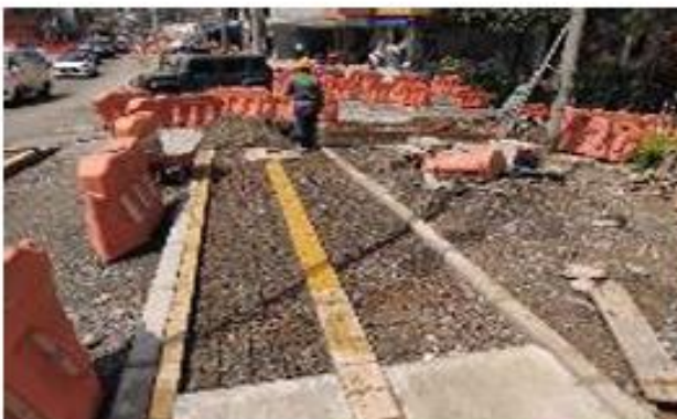
Foto 3: Construcción en calle 55 sur
