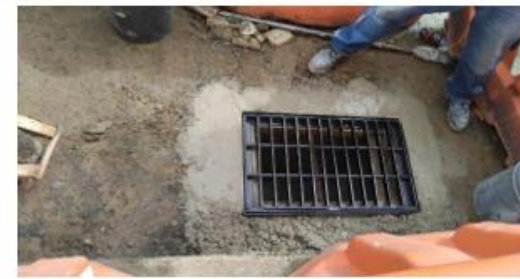
FOTO 76. Construcción de Sumidero en Calle 58 sur
