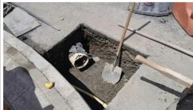
FOTO 30. Construcción de sumideros en calle 58 sur sector Parroquia Nuestra Señora del Carmen
