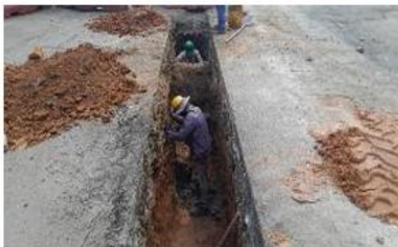
FOTO 23. Construcción de redes hidrosanitarias sector Filam
