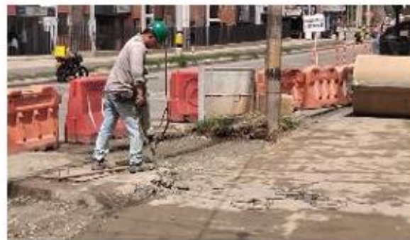
Foto 6: Construcción de rampa para desvío vehicular calle 57 sur provisional
