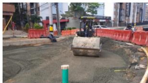
FOTO 72. Lleno en base granular sector calle 55 x cra 43A
