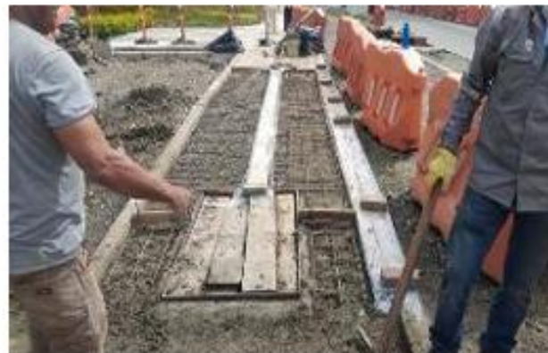
Foto 2: Construcción de anden en sector calle 55 sur
