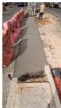
Foto 9: Construcción desvío provisional en sector Espacio Óptimo
