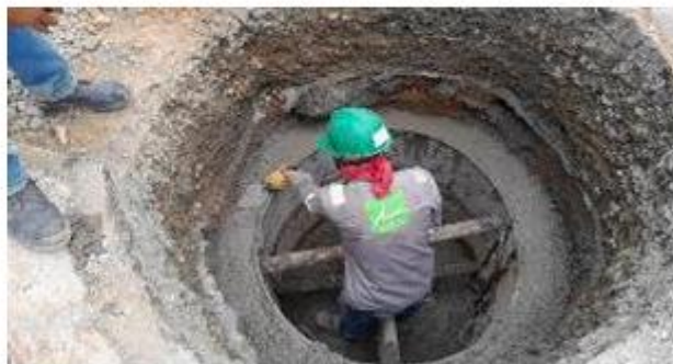
FOTO 46. Construcción Mh en sector filam
