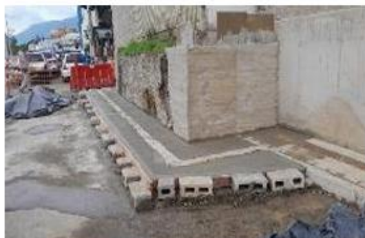
Foto 15: Construcción de zapata para muro de contención ID 6
