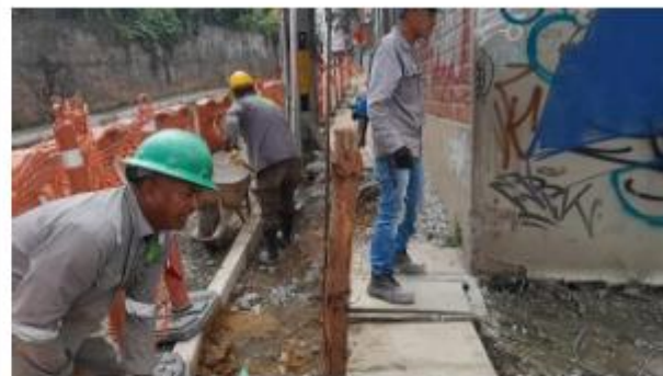
FOTO 78. Construcción y adecuación de andén en la Cra 43 A x Calle 61 sur
