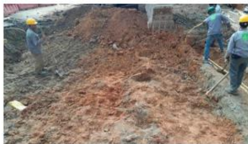
FOTO 69. Excavación para conformación de vía sector de filam
