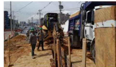
FOTO 66. Construcción de alcantarillado en flam
