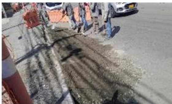
Foto 5: Construcción de rampa de accesos provisional para Ur. Villas del laguito
