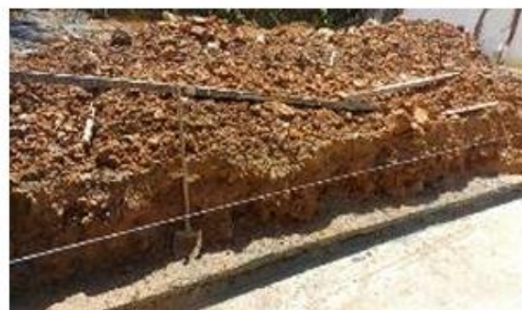
Foto 16. Construcción de zapata para muro de contención ID 6
