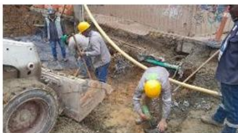
FOTO 51. Construcción de acometida para aguas lluvias en parroquia Nuestra Señora del Carmen
