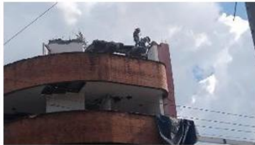
FOTO 63. Demolición en Edificio las Chachas
