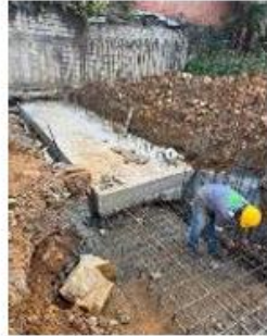
FOTO 61. Construcción de muro de contención en Predio ID 6
