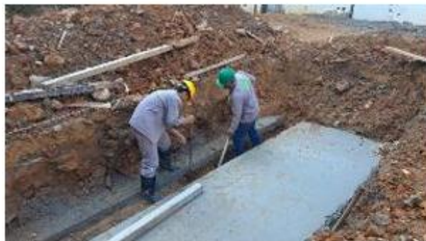
Foto 17: Construcción de zapata para muro de contención ID 6
