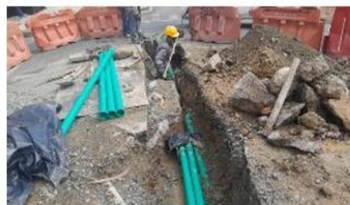
FOTO 48. Paso redes eléctricas calle 58 sur
