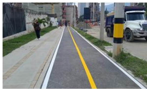
FOTO 82. Aplicación pintura plástico en frío en ciclorutas
