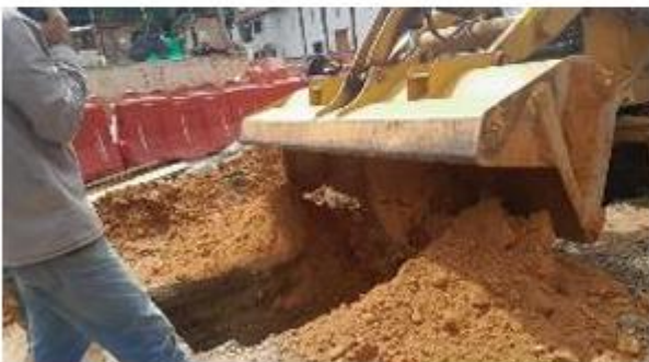
FOTO 45. Construcción de redes hidrosanitarias sector filam
