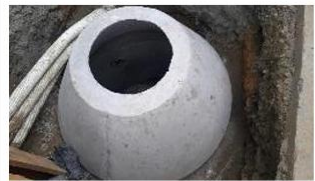
FOTO 34. Construcción de Mh en ampliación de red de aguas combinadas calle 61 sur
