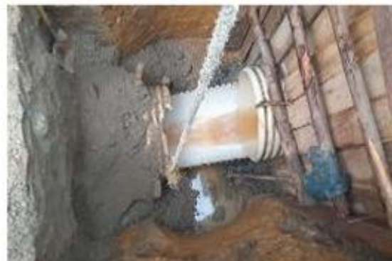
Foto 10: Construcción de ampliación red de aguas combinadas calle 61 sur
