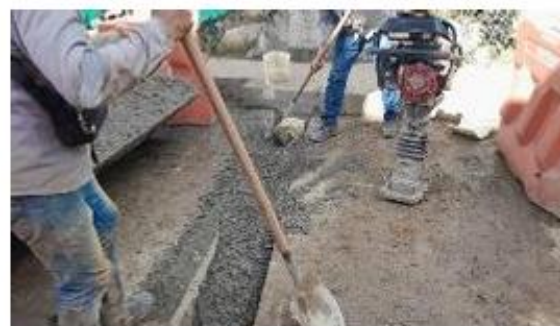
Foto 8: Construcción de sumideros en calle 58 sur
