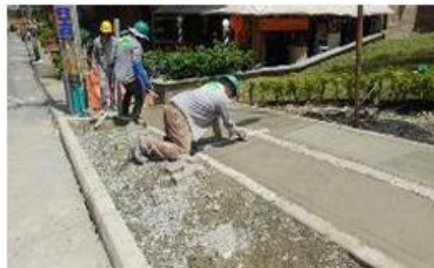
Foto 4: Construcción de anden en calle 55 sur
