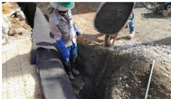
FOTO 77. Construcción de Filtro tipo geodren en Cra 43 A x Calle 61 sur
