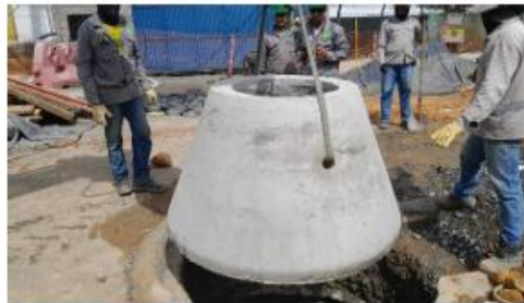
FOTO 65. Construcción de MH sector D1
