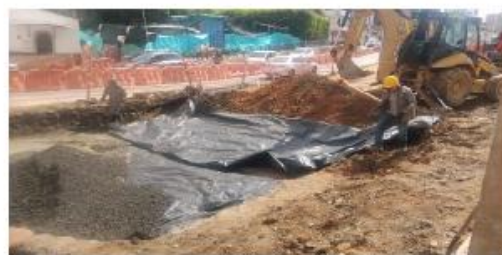
FOTO 73. Excavación para conformación de vía en sector filam
