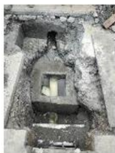
FOTO 51. Construcción de acometida para aguas lluvias en parroquia Nuestra Señora del Carmen
