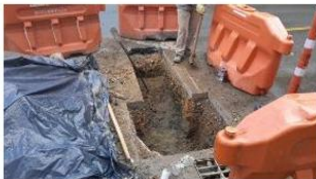
FOTO 29. Construcción de sumideros en calle 58 sur
