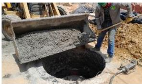
FOTO 47. Construcción Mh en sector filam
