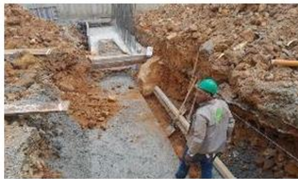
FOTO 42. Construcción de zapata en muro de contención ID 6
