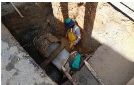
Foto 13: Construcción de ampliación red de aguas combinadas calle 61 sur
