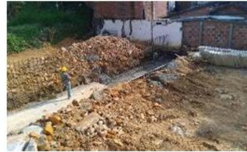
FOTO 62. Construcción de zapata en muro de contención ID 6
