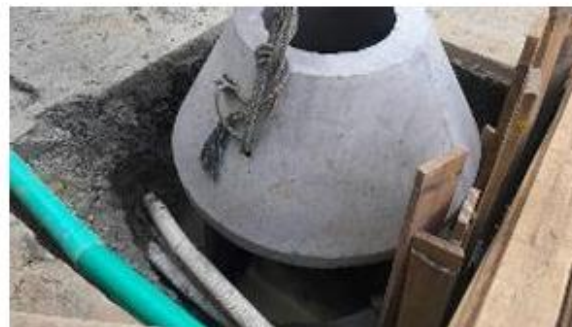
FOTO 36. Construcción de Mh en ampliación de red de aguas combinadas calle 61 sur
