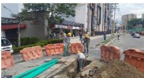
FOTO 49. Canalización de redes eléctricas en calle 57 sur
