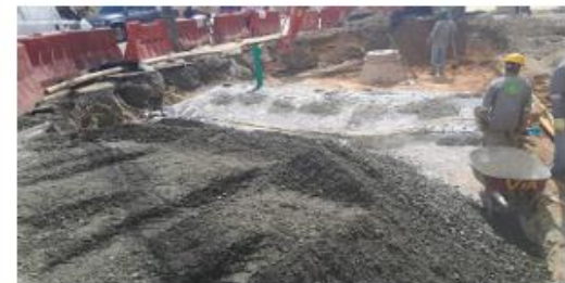
FOTO 74. Lleno en base granular sector calle 55 x cra 43A
