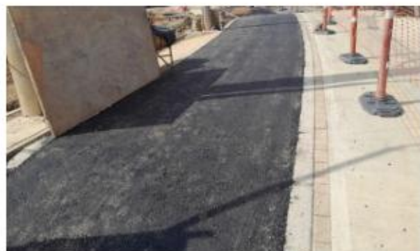
FOTO 81. Instalación de mezcla asfáltica para ciclorutas sector filam
