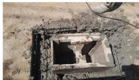
FOTO 50. Construcción de sumideros en calle 58 sur
