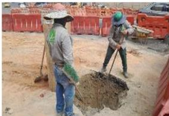
FOTO 25: Construcción Mh en sector filam
