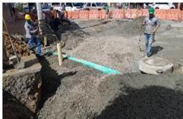
FOTO 37. Adecuación de vía para instalación de pavimento cra 43A con calle 61
