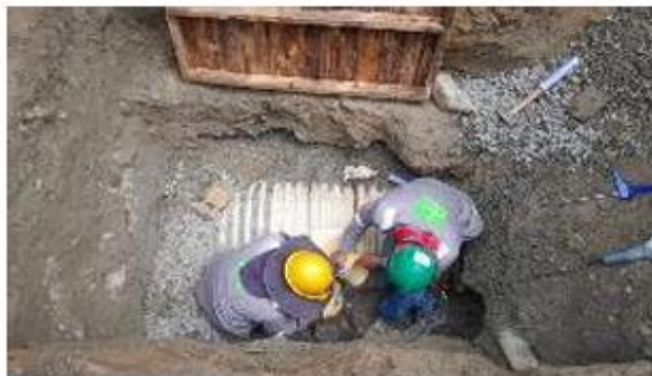
FOTO 35. Construcción de ampliación red aguas combinadas en calle 61 sur
