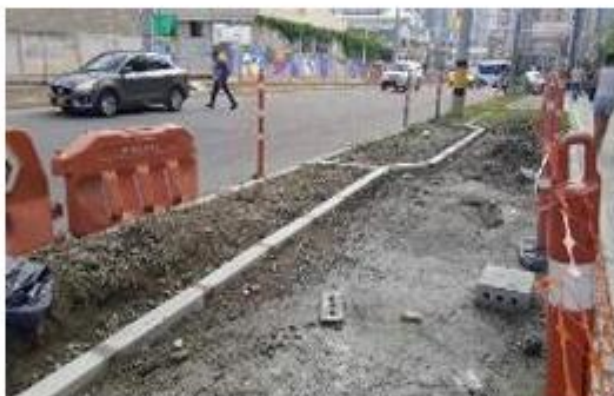
Foto 1: Instalación de bordillos en paradero de bus sector casa blanca
