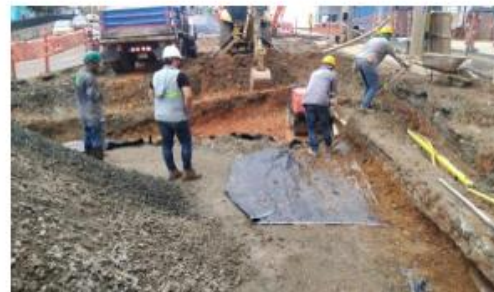
FOTO 70. Excavación para conformación de vía en sector filam
