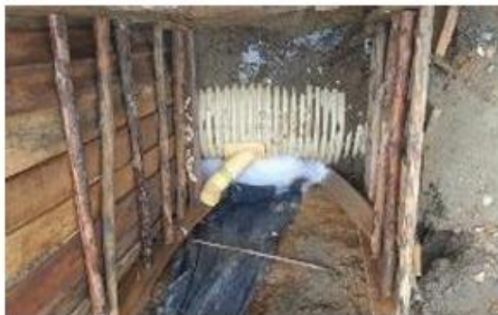
Foto 11: Construcción de ampliación red de aguas combinadas calle 61 sur
