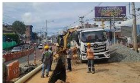
FOTO 22. Construcción de redes hidrosanitarias sector Filam
