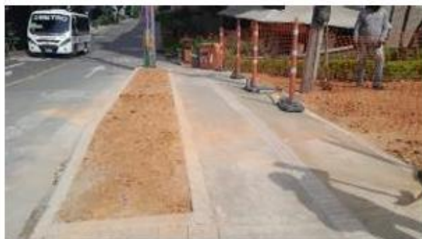
FOTO 27. Adecuación Jardineras en sector calle 55 sur
