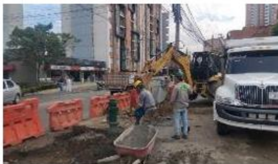
Foto 7: Demolición de carpeta asfáltica existe para conformación de desvío provisional en calle 57 sur
