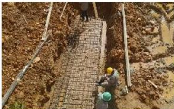
FOTO 41. Construcción de zapata en muro de contención ID 6
