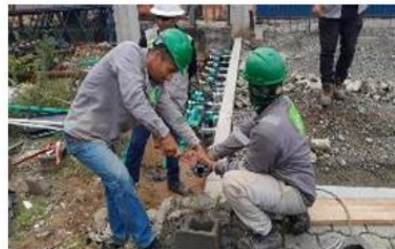
Foto 14: Adecuación acometidas de acueducto en sector Filam
