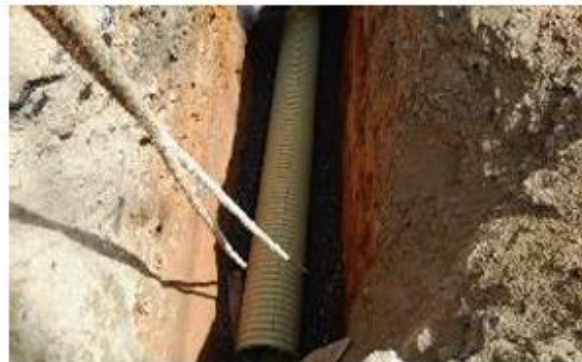
FOTO 24. Construcción de redes hidrosanitarias sector Filam
