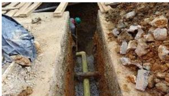
FOTO 39: Adecuación acometidas existentes en ampliación de red aguas combinadas en calle 61 sur
