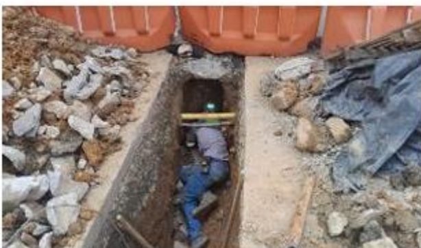
FOTO 33. Construcción de ampliación red aguas combinadas en calle 61 sur
