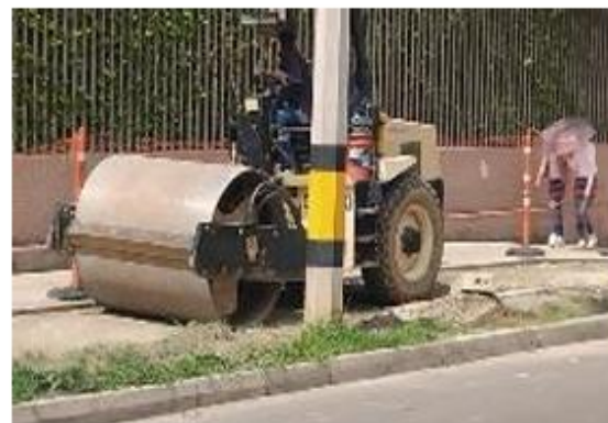
FOTO 26. Compactación de base granular en ciclo ruta sector casa blanca
