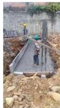
FOTO 40. Construcción de zapata en muro de contención ID 6
