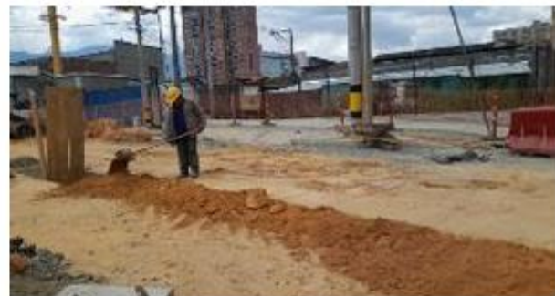
FOTO 44. Construcción de redes hidrosanitarias sector filam
