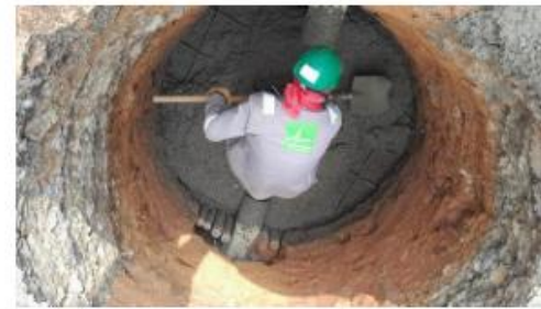
FOTO 64. Construcción de MH sector D1
