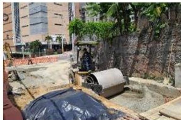
FOTO 38. Llenos en base granular para estructura de pavimento Calle 61 sur
