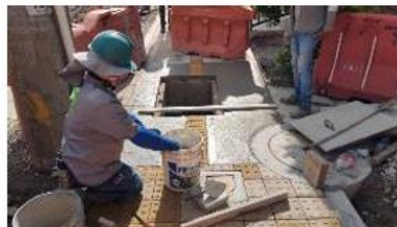
FOTO 28. Construcción de andén en calle 57 sur
