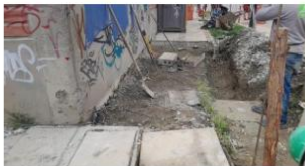
FOTO 79. Construcción y adecuación de andén en la Cra 43 A x Calle 61 sur
