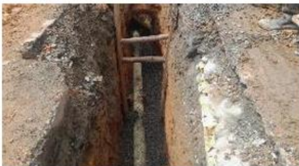
FOTO 43. Construcción de redes hidrosanitarias sector filam
