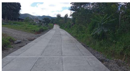
Placa huella terminada Ambaló
