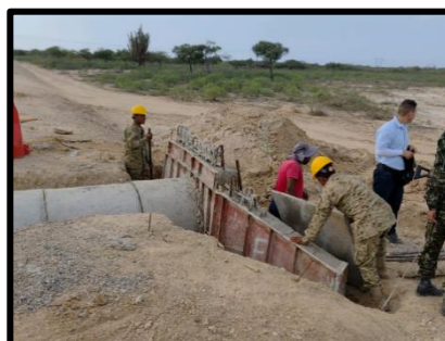
Construcción de obra de drenaje en el corredor KM 12 VALLEDUPAR MAMACHAL CASCAJALITO KEWIRRASHI CIRUELAKAT
