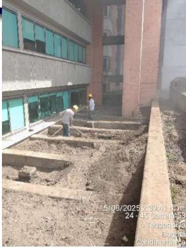
3. Levante y retiro de manto asfáltico en área A
