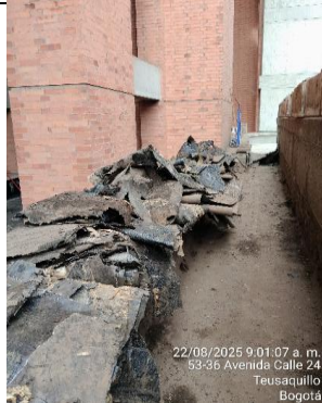
5. retiro de manto asfaltico en zona E
