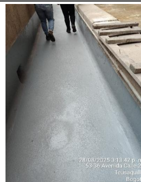
6. Instalacion de poliurea en zona S
