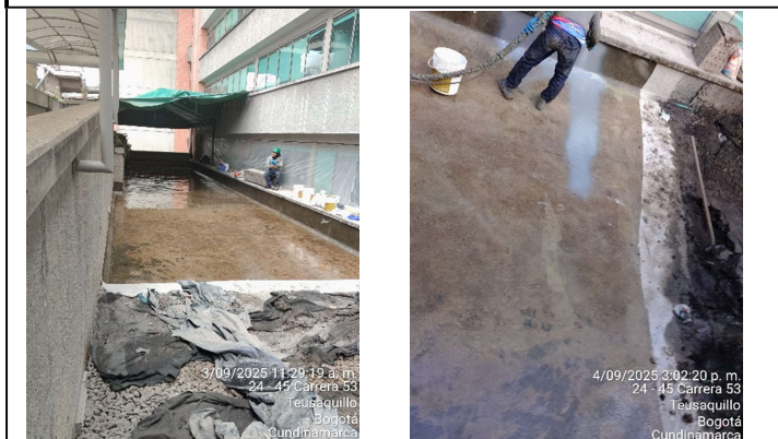
4. Instalacion de poliurea en zona G
