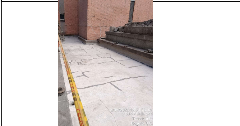
3. Tratamiento de fisuras en area S
