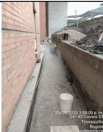
1. Pulida y levantamiento de manto en area S
