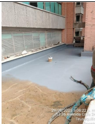
3. Instalacion de poliurea en zona E
