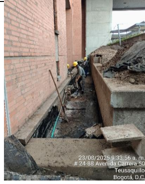
6. retiro de manto asfaltico en zona S
