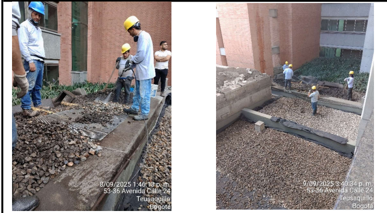
1. Lavado de triturado para filtro
