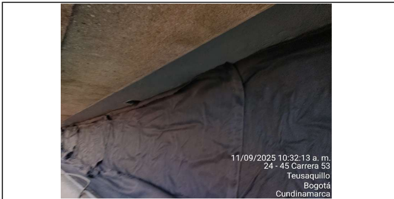
5. Instalacion de geotextil para Area S
