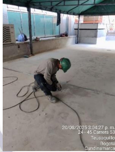
4. Pulida para alistamiento de terreno previo a instalación de poliuria
