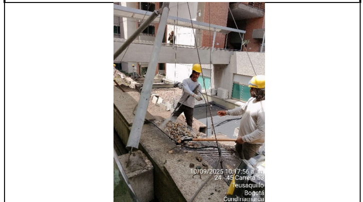
4. Lavado de triturado para filtro
