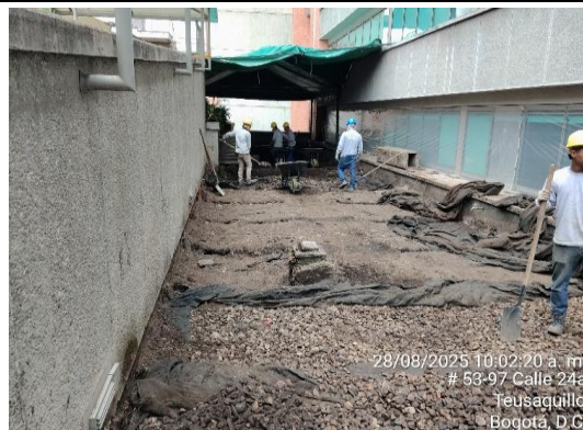
4. retiro de filtro frances en zona G
