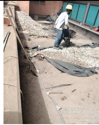
2. Retiro de filtro frances en zona A
