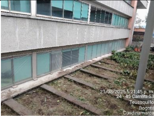
5. Excavación manual y retiro de material vegetal en área E
