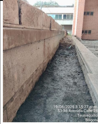
1. excavacion manual de tierra negra ZONA A y E
