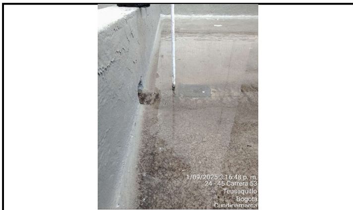
2. Prueba de estanquedad para el Area A
