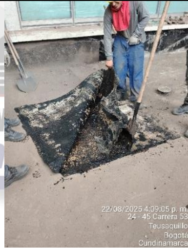
6. Sello de fisuras en área A
