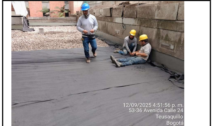
2. Conformación de filtro frances de area A
