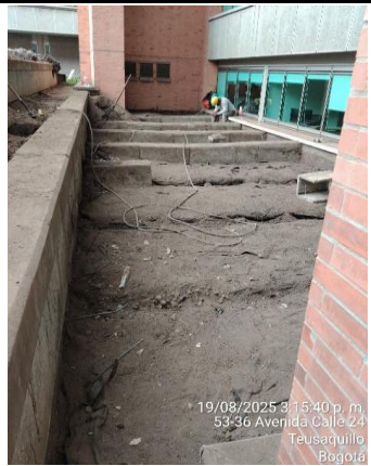
1. excavacion manual de tierra negra ZONA A y E
