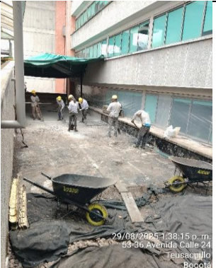
5. retiro de manto asfaltico en zona G
