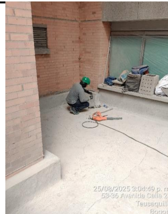
2. Sello de fisuras en area E
