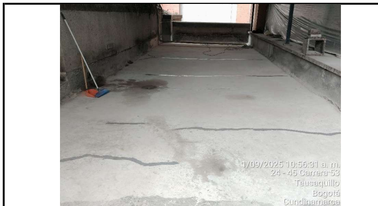
1. Sello de fisuras para area G
