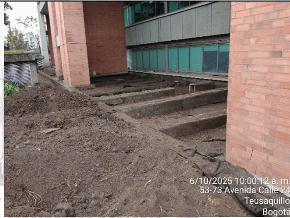
18. Excavación manual y retiro de material vegetal en Área H.
