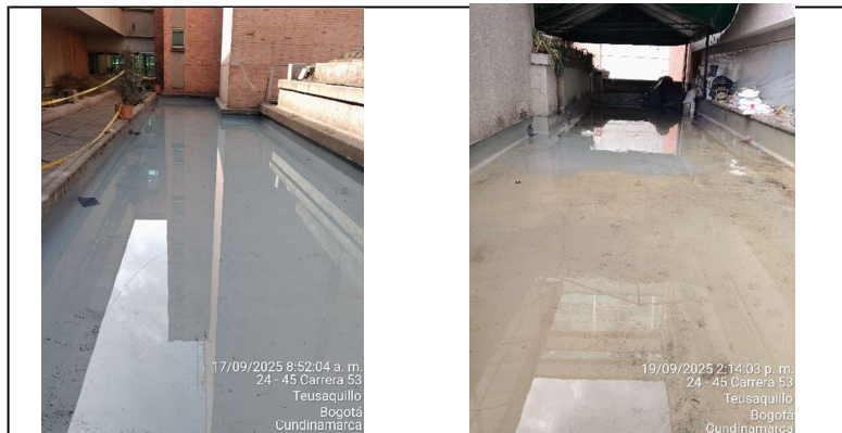
5. Prueba de estanquidad en area S y Primera zona del area G
