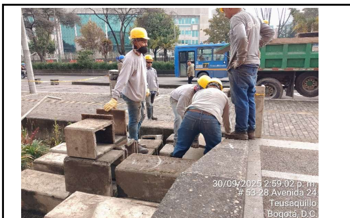
2. Retiro de RCD (prefabricados de concreto)
