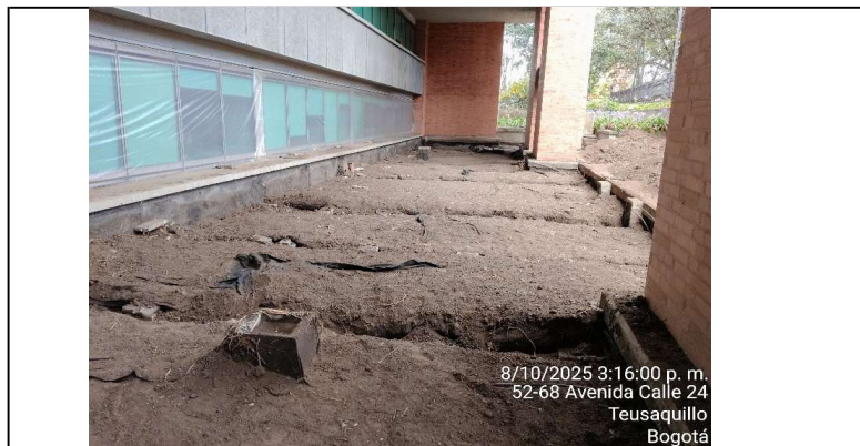
5. Retiro de prefabricados en area I
