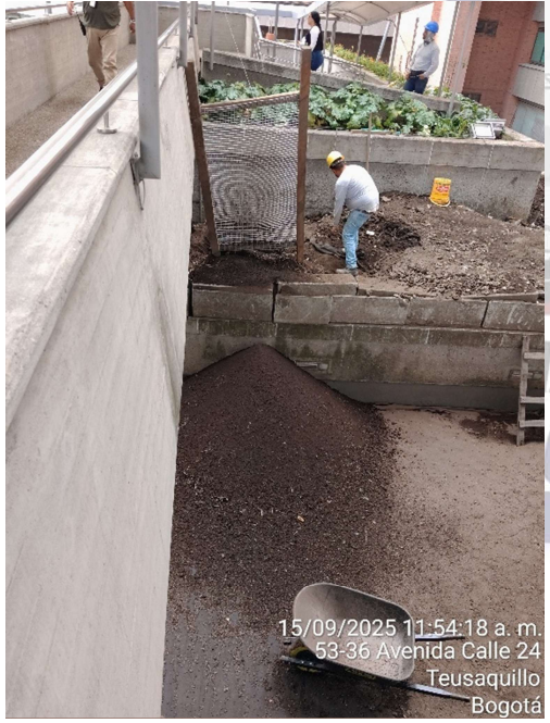
9. Lavado de triturado existente para conformación de filtro francés en áreas E Y S
