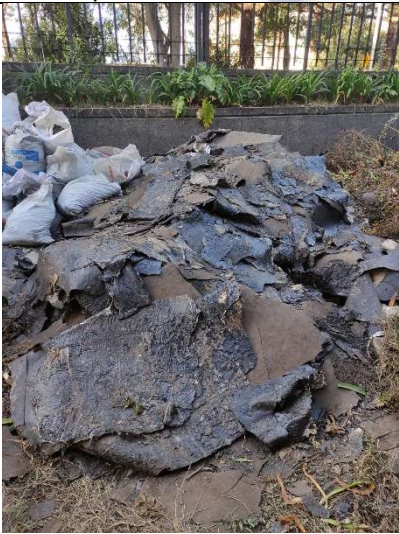
RCD manto asfáltico
