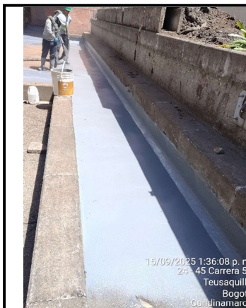
2. Instalacion de poliurea e instalacion de geotextil para filtro en area S
