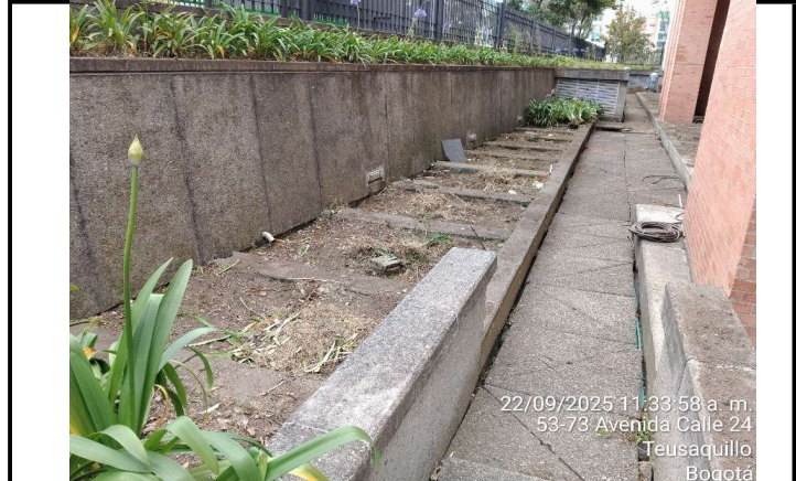
2. Retiro de capa vegetal en areas de la zona J
