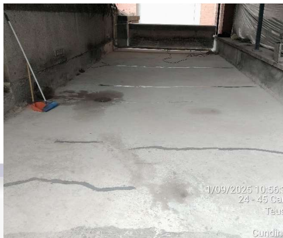
2. Sello de fisuras en placa del área G
