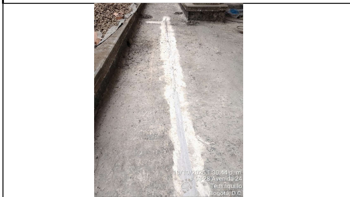
6. Sello de fisuras en area I
