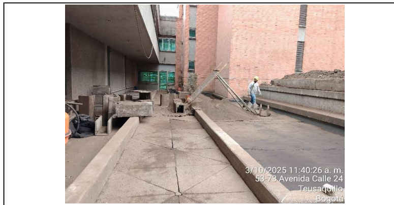
5. Tamizaje de tierra negra para retiro de impurezas en el area S
