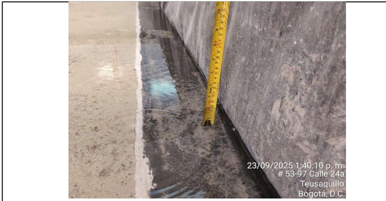
5. Prueba de estanquidad en Primera zona del area G
