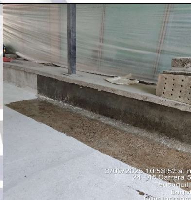
2. Sello de fisuras en placa del área G
