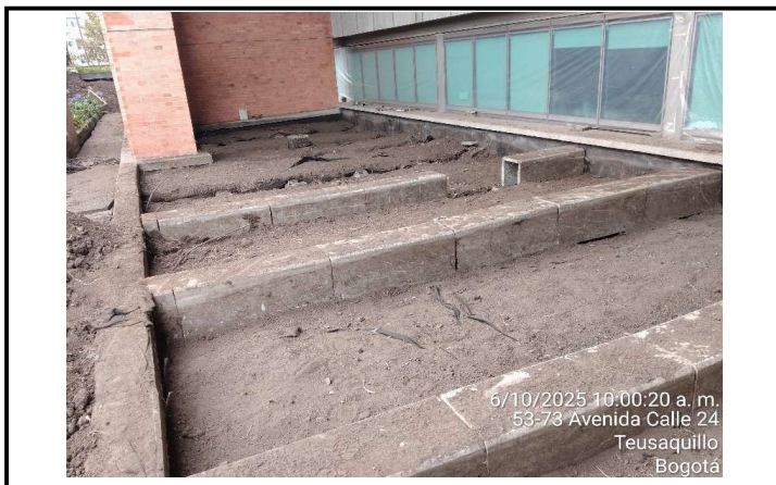
2. Excavacion manual de tierra en area I
