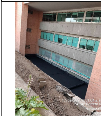
4. Instalacion de geotextil y conformacion de filtro en Area E
