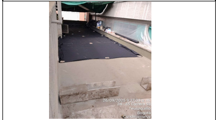
6. Instalacion de geotextil en area G
