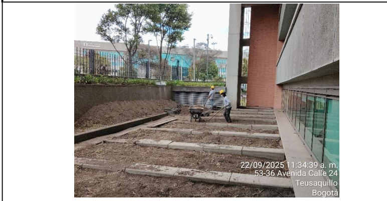
3. Excavacion manual para primer modulo del AREA I
