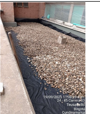
4. Instalacion de geotextil y conformacion de filtro en Area E
