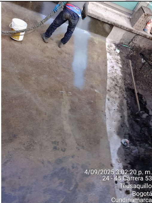
7. Instalación de poliuria en área G.
