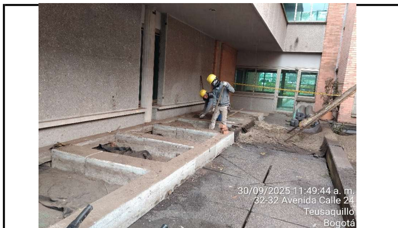
1. Excavacion manual para el area H
