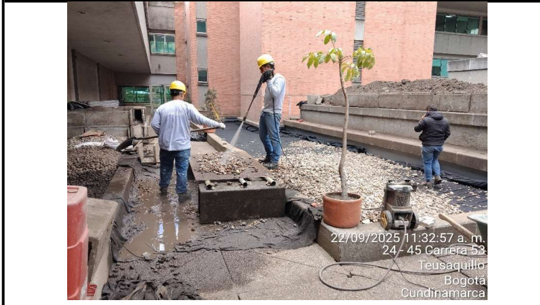
1. Lavado de triturado para conformación de filtro en area S
