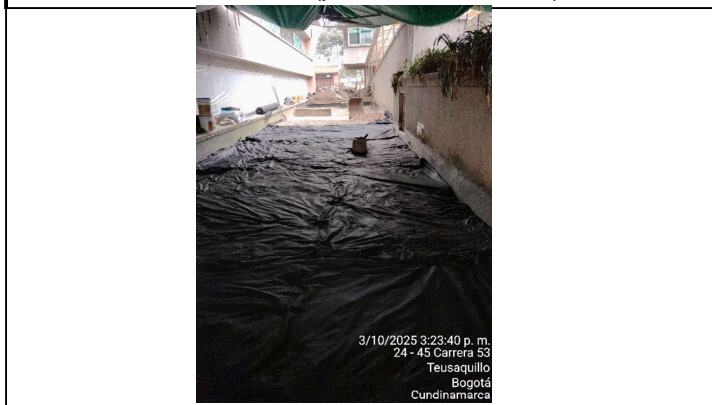
4. conformacion de filtro para el area G
