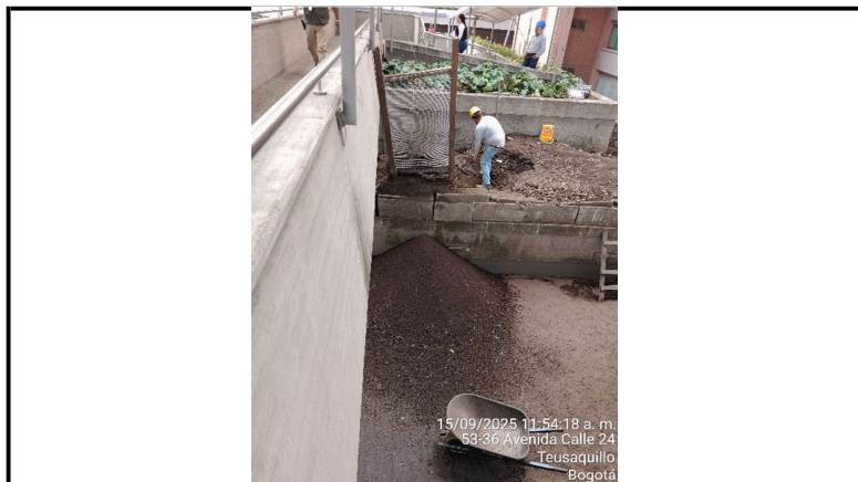
1. Tamizado de tierra negra existente para eliminar impurezas Area A
