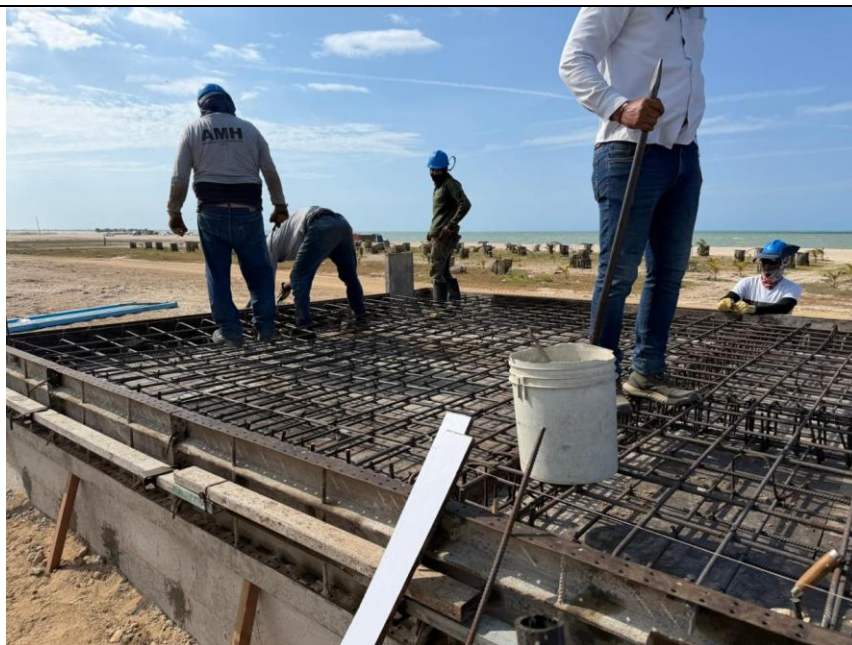
Acero de tanque
