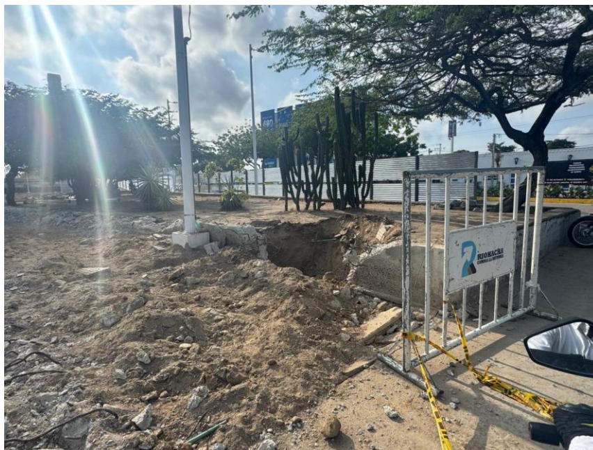
Demolición de muros
