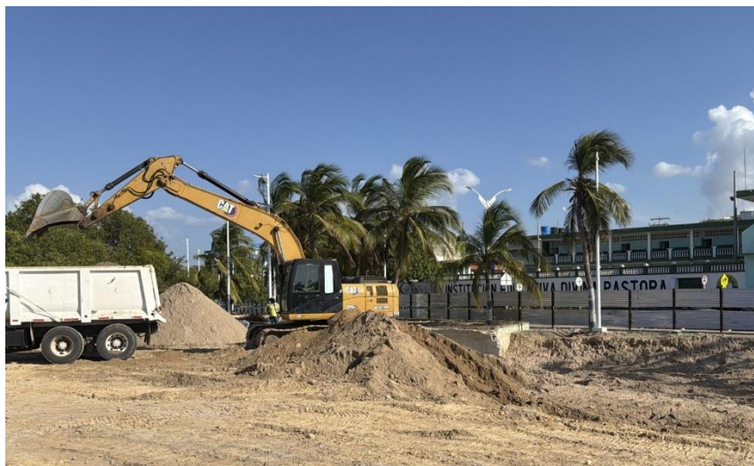
Retiro de material
