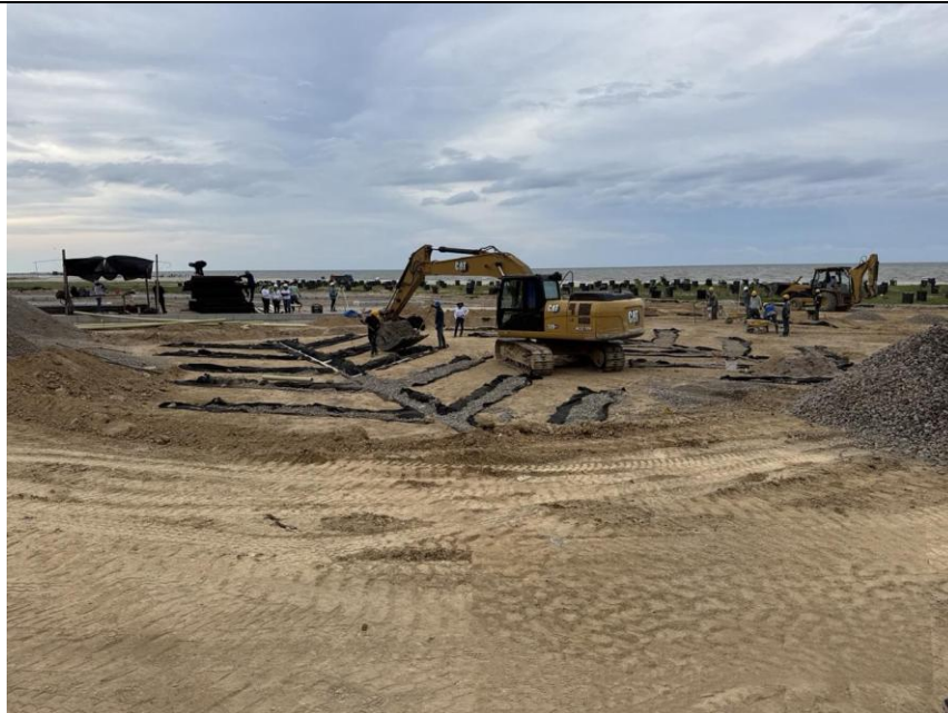
Relleno con material filtrante
