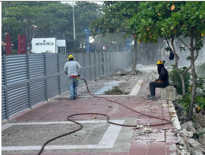
Demolición de baldosín
