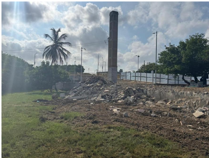
Demolición de elementos estructurales
