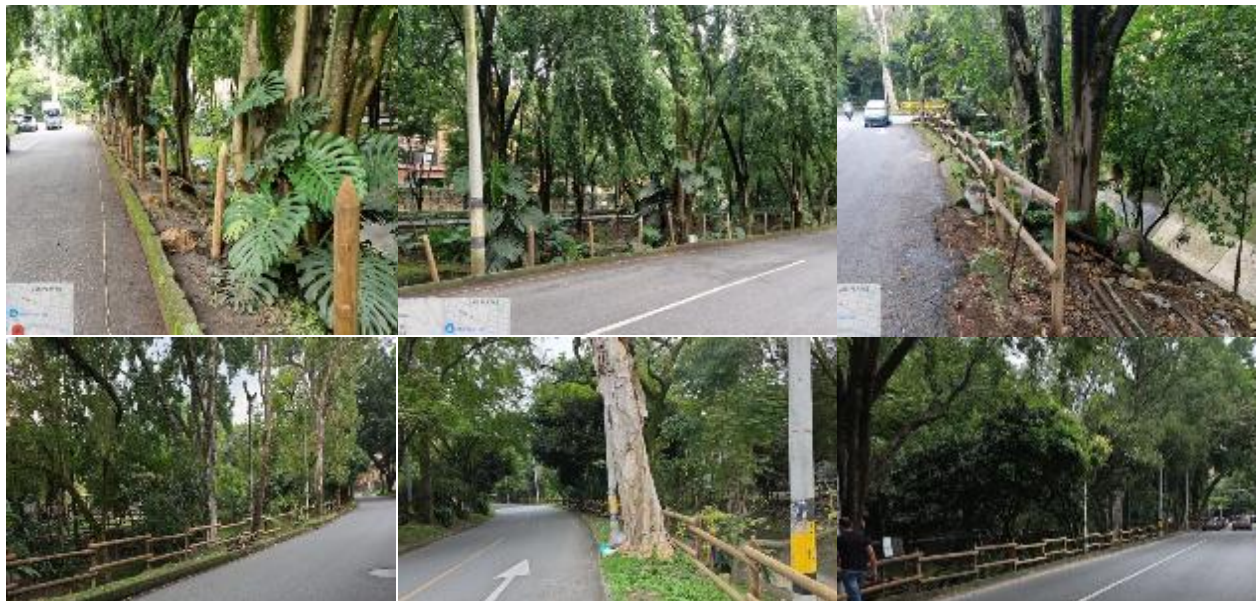
Fotografía 12. Desmonte e instalación de cercos en Madera inmunizada _ DIAGONAL 75 D CALLE 2B _Diciembre_2025.
