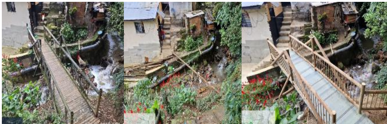
Fotografía 9. Desmante e instalación de puente en Madera inmunizada _ CARRERA 38 CALLE 94 _Diciembre_2025.
