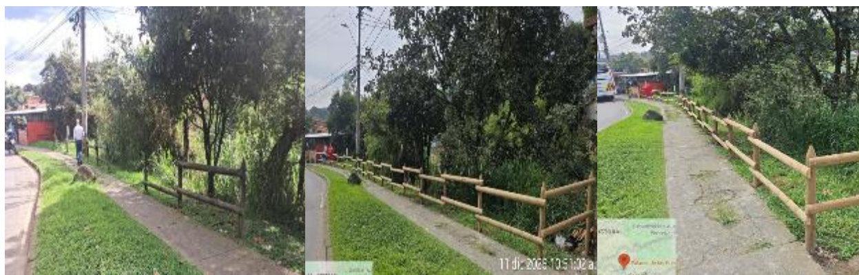
Fotografía 11. Desmote e instalación de cercos en Madera inmunizada _ CALLE 112 A CARRERA 64 A _ Diciembre _2025.
