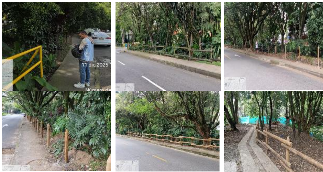
Fotografía 4. Instalación de cerco en Madera Inmunizada Calle 48 #91-40_Diciembre_2025.
