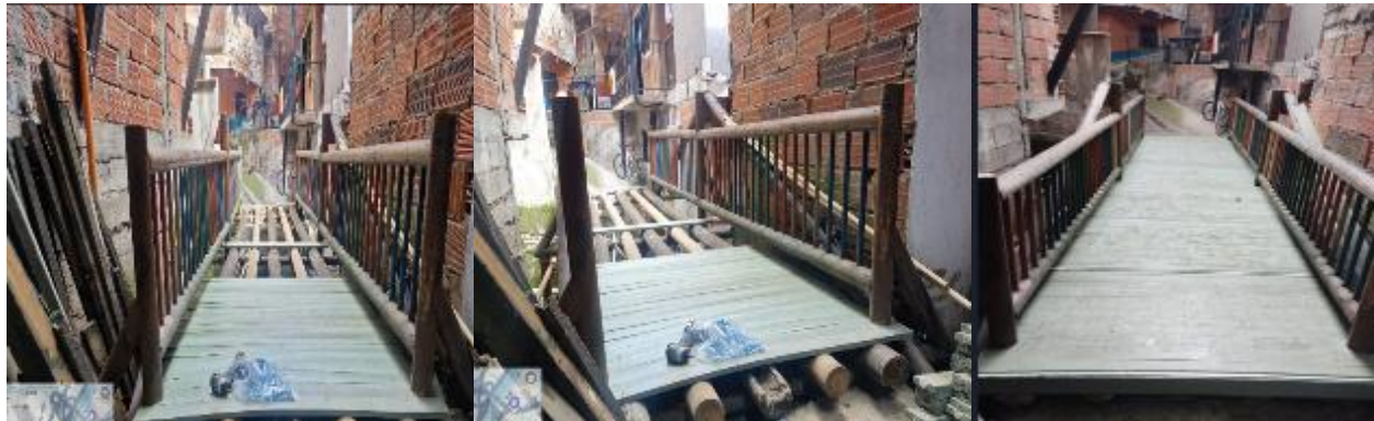
Fotografía 10. Suministro e instalación de pisos en Madera sintética _ CALLE 112 A CARRERA 64 A _Diciembre 2025.
