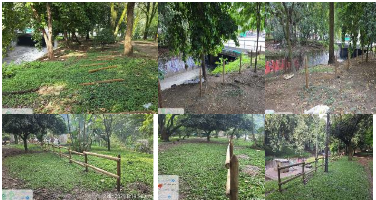
Fotografía 8. Suministro de cerco en Madera_ CALLE 48 CARRERA 68_Diciembre_2025.
