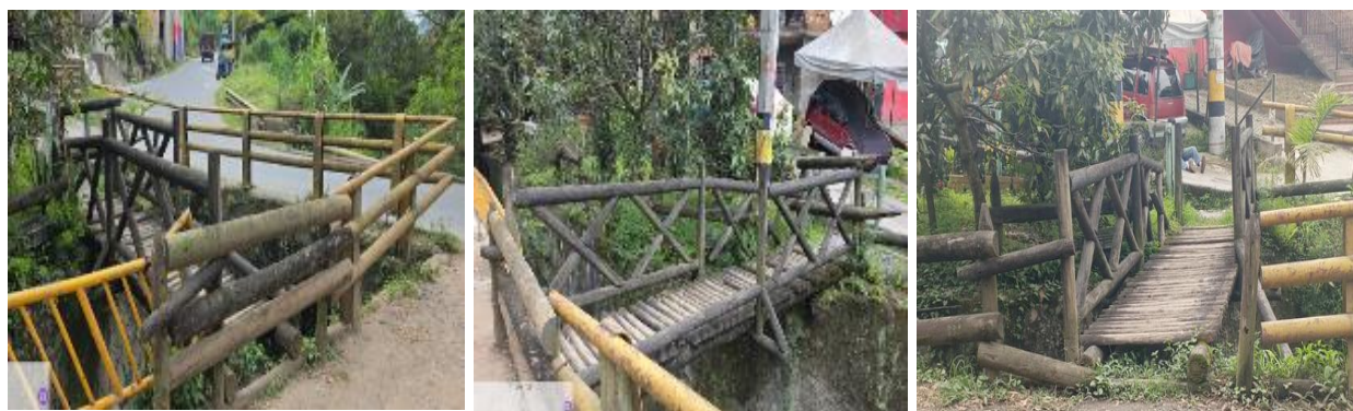
Fotografía 5. Desmonte de puente en madera inmunizada _ Carrera 120F Calle 48B _Diciembre_2025
