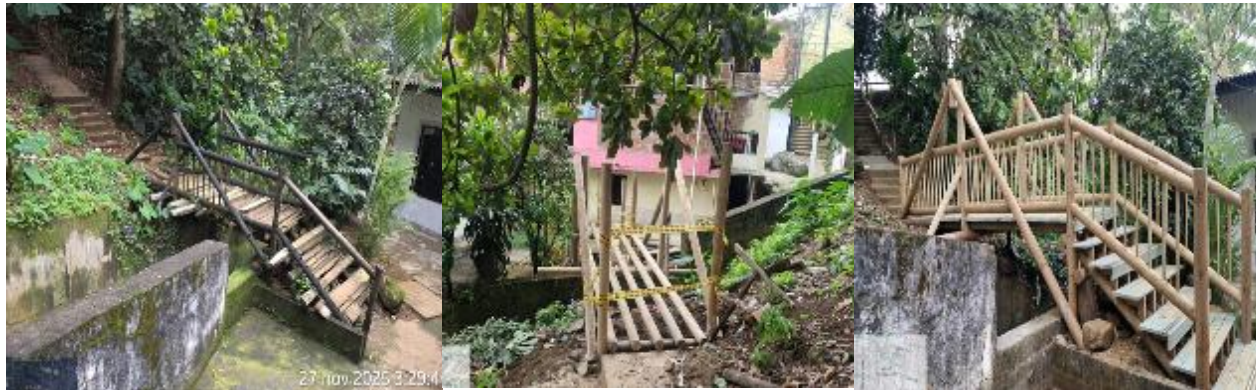
Fotografía 7. Desmante e instalación de puente en Madera inmunizada_ CALLE 45A CARRERA 89 75_Diciembre_2025.
