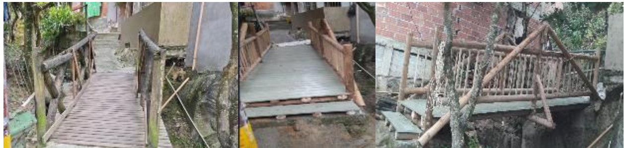
Fotografía 3. Desmonte e instalación de puente en madera inmunizada _ Carrera 125 #49-72_Diciembre_2025
