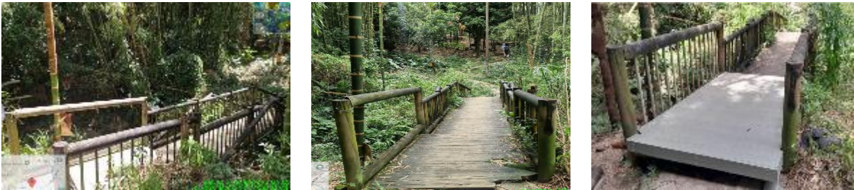
Fotografía 2. Instalación de pisos en madera sintética_ CARRERA 89 CALLE 68 _DICIEMBRE_2025.
