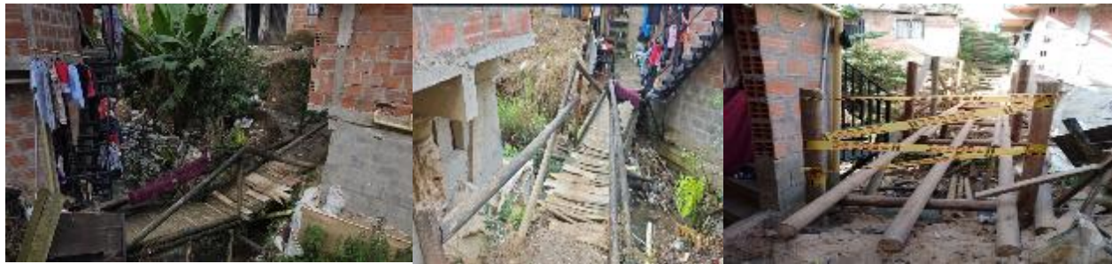
Fotografía 6. Desmonte de puente en Madera inmunizada_ Carrera 51 b #2-56_ Diciembre_ 2025.
