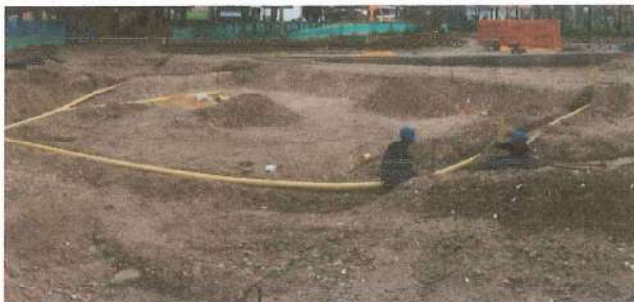
Foto No. 7- Instalación Red Hidráulica Street
