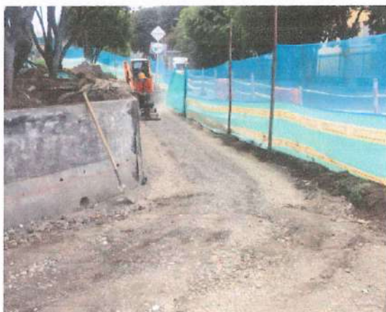
Foto No. 5- Relleno y Conformación de Subbase en Senderos
