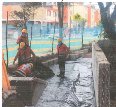
Foto No. 16- Instalación Geotextil Sendero Calle 164
