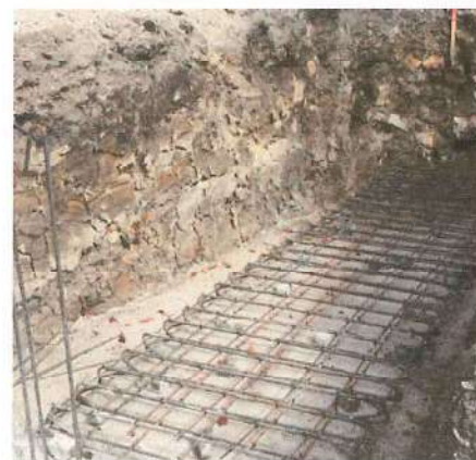
Foto No. 12- Armado Zarpa Muro B
