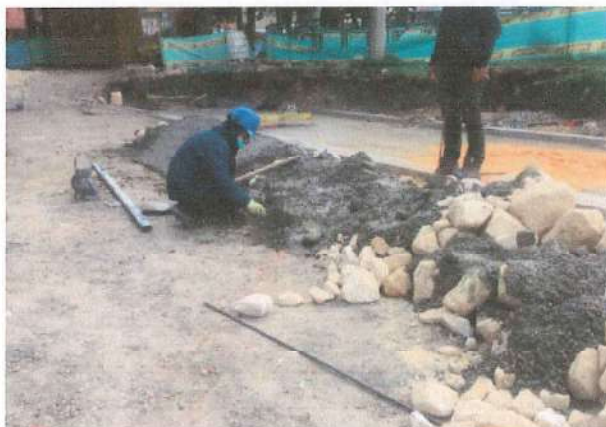
Foto No. 11- Vaciado de Concreto para Ciclópeo Street
