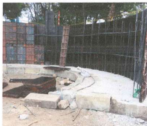
Foto No. 6- Armado y Encofrado Muro Costado Sur Occidental Bowl
