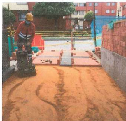
Foto No. 14- Instalación Adoquin Sendero CAI
