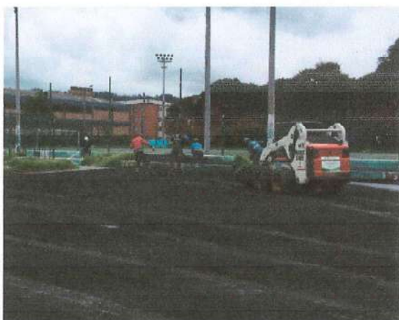
Foto No. 9- Instalación de Rodadura 1350 en Cancha Baloncesto
