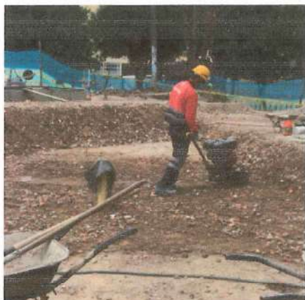
Foto No. 1- Conformacion Terrazas Street
