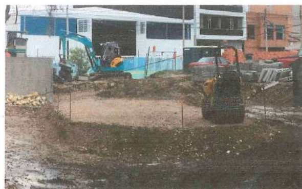
Foto No. 20- Conformación Terrazas Mejoramiento Bowl
