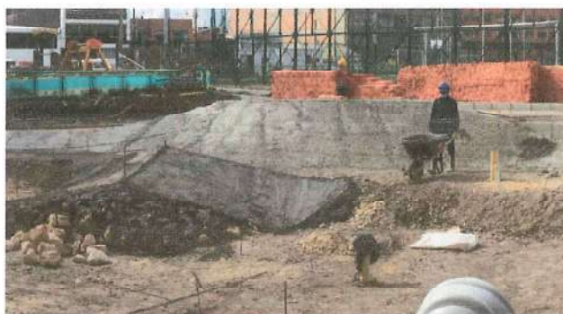
Foto No. 15- Concreto Ciclopeo Street
