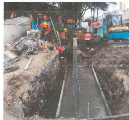
Foto No. 22- Vaciado Zarpa Muro I
