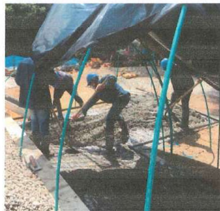
Foto No. 24- Concreto Lanzado Street
