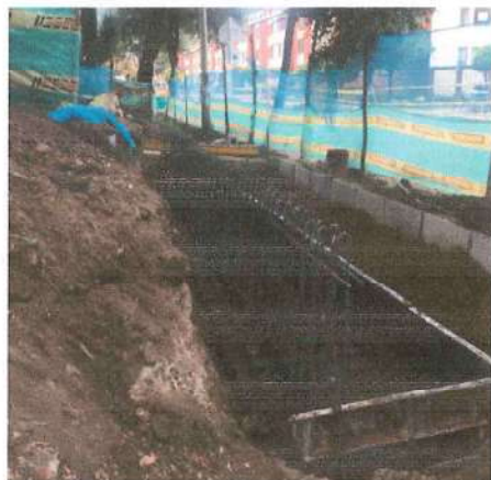
Foto No. 17- Armado Muro H
