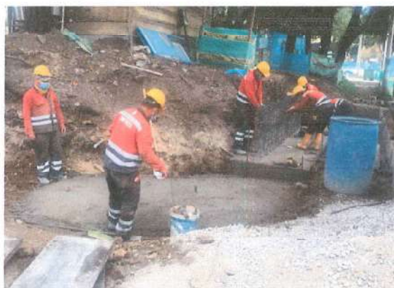
Foto No. 18- Solado para continuación de Muro H
