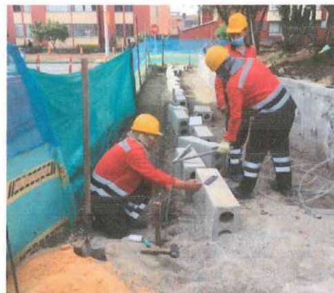
Foto No. 8- Instalacion Brillo Sendero Carrera 16C
