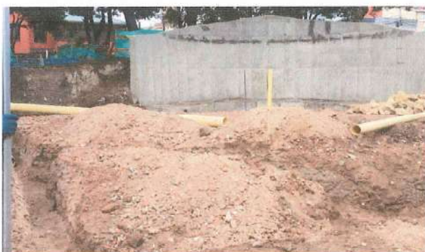
Foto No. 3- Instalación Red Hidráulica Bowl
