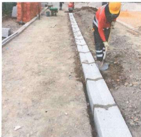
Foto No. 23- Instalación de Cañuela
