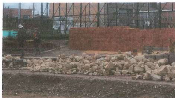
Foto No. 10- Instalación de Rajon en Street
