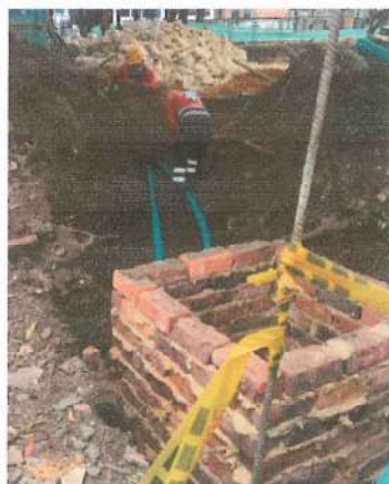
Foto No. 19- Instalación de Canalización Eléctrica
