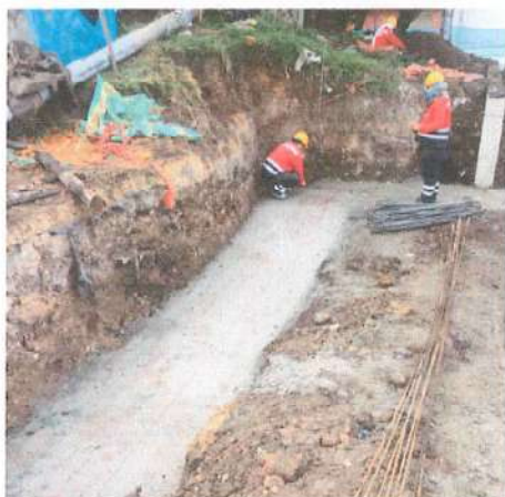
Foto No. 21- Solado para continuación Muro I
