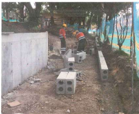
Foto No. 13- Instalación Bordillo Sendero Calle 164
